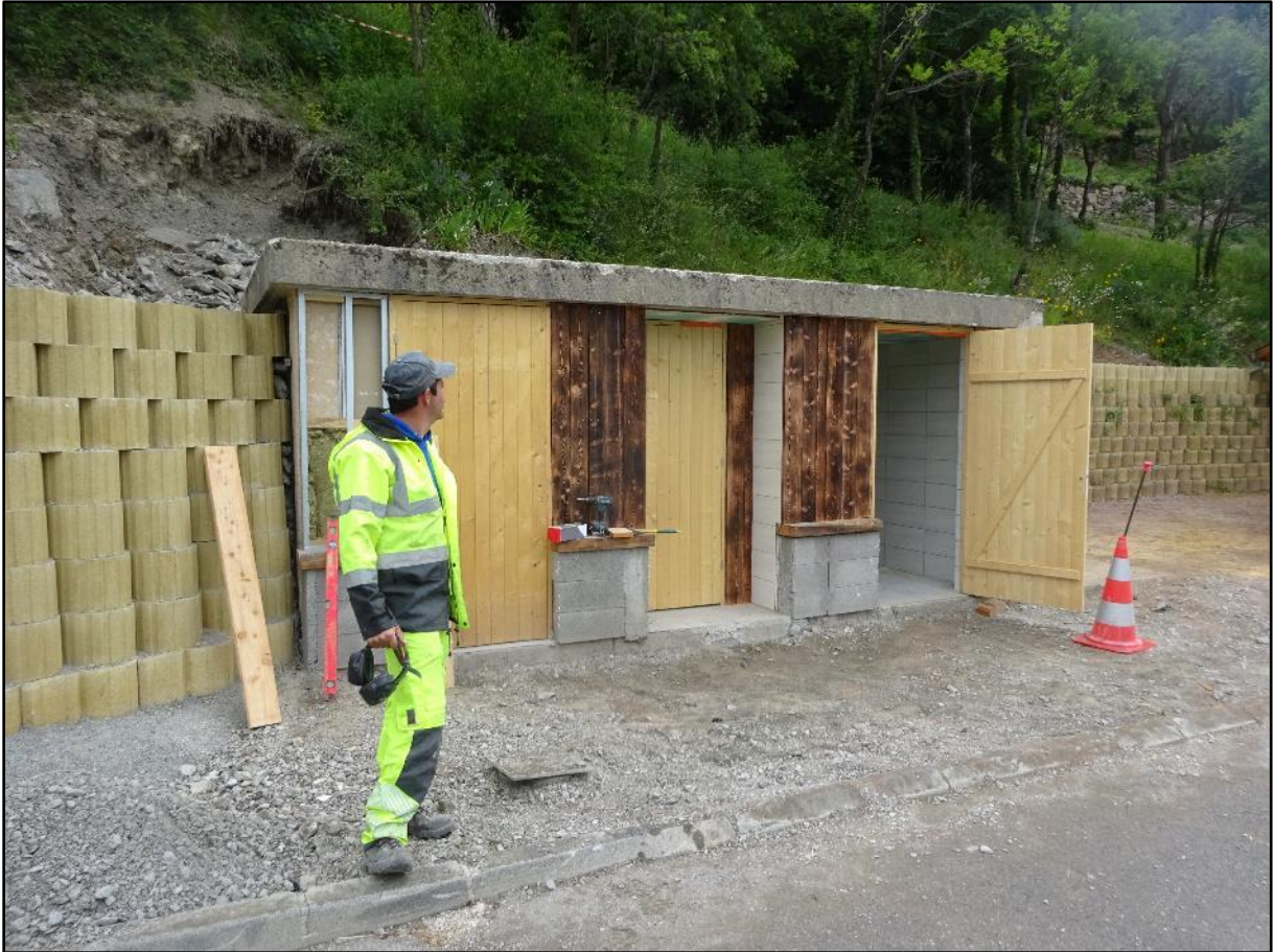
Image n°8 : mise en place des boiseries
