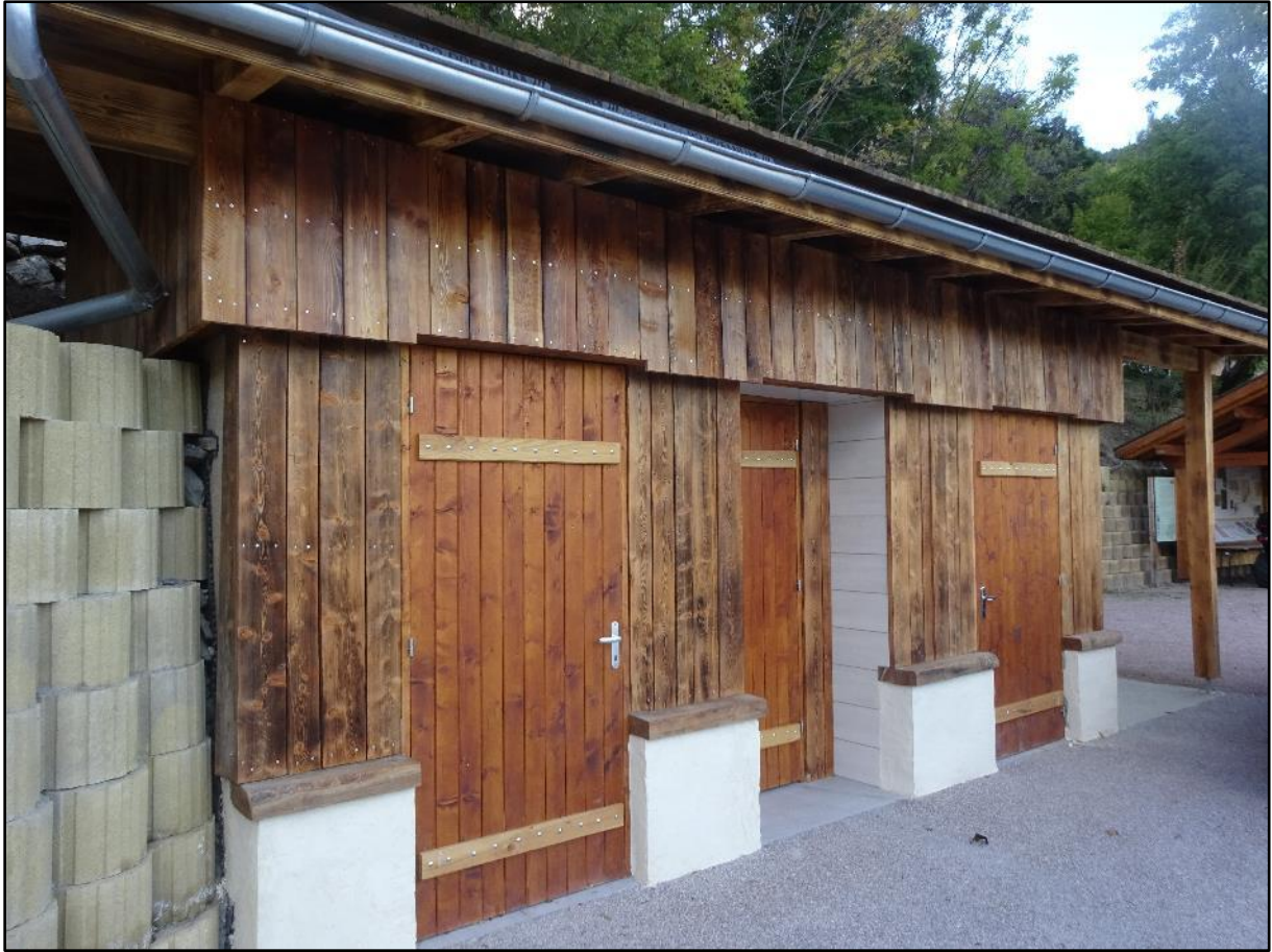
Image n°24 : le local des WC terminé
