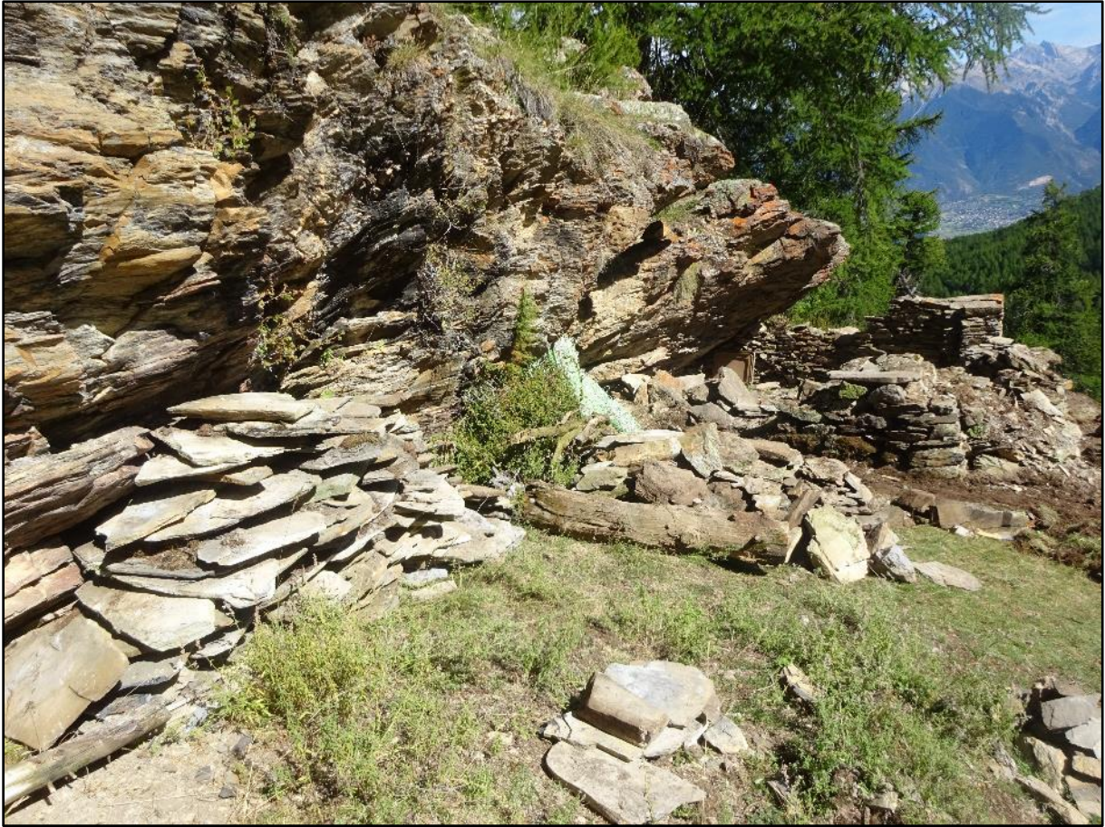
Image 23 : un chantier en ordre
