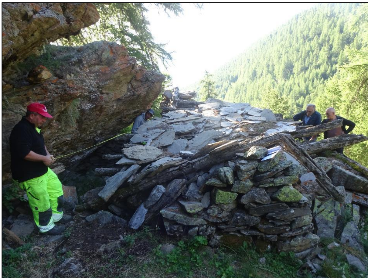
Image 10 : des mesures sont prises
