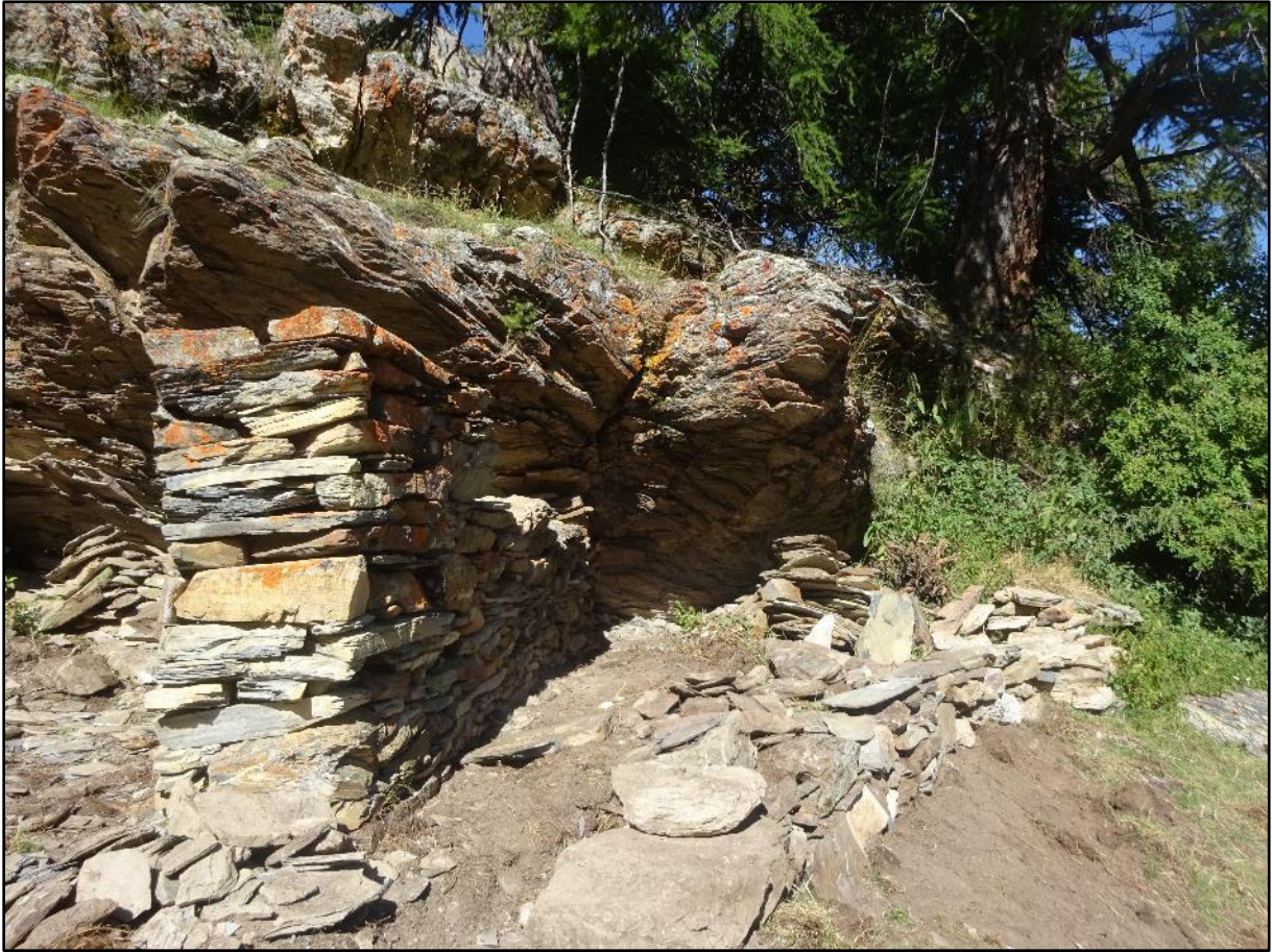
Image 24 : un chantier en ordre
