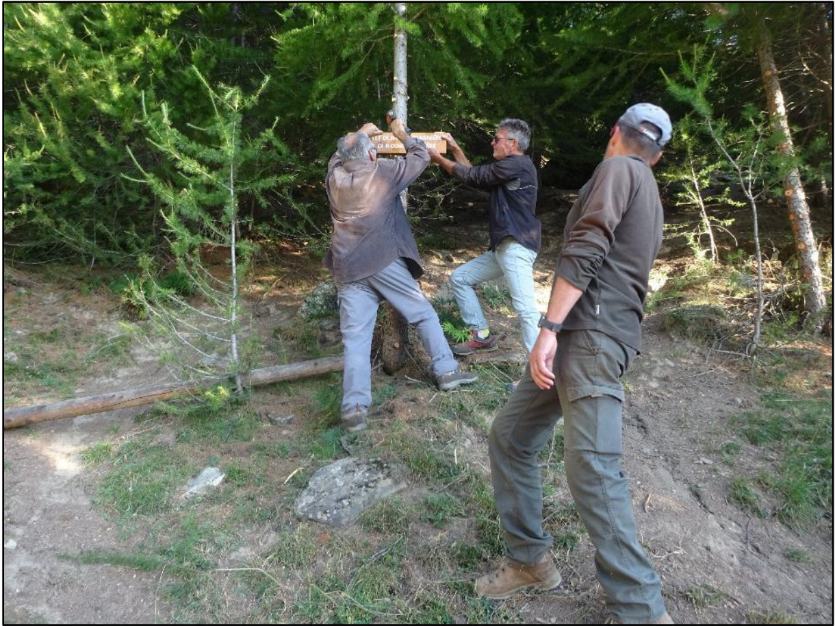
Image 20 : mise en place du panneau inférieur
