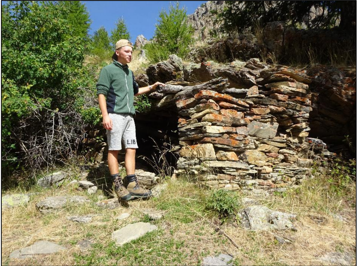
Image 4 : porte et mur latéral
