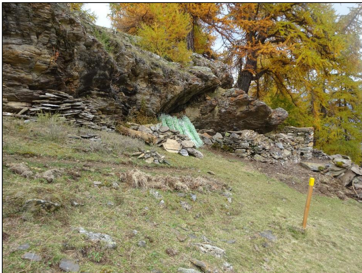
Image 23 : la cabane de Roche Charnière en chantier
