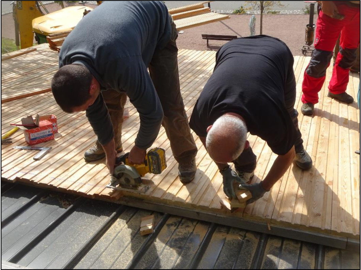
Image n°22 : sur le toit
