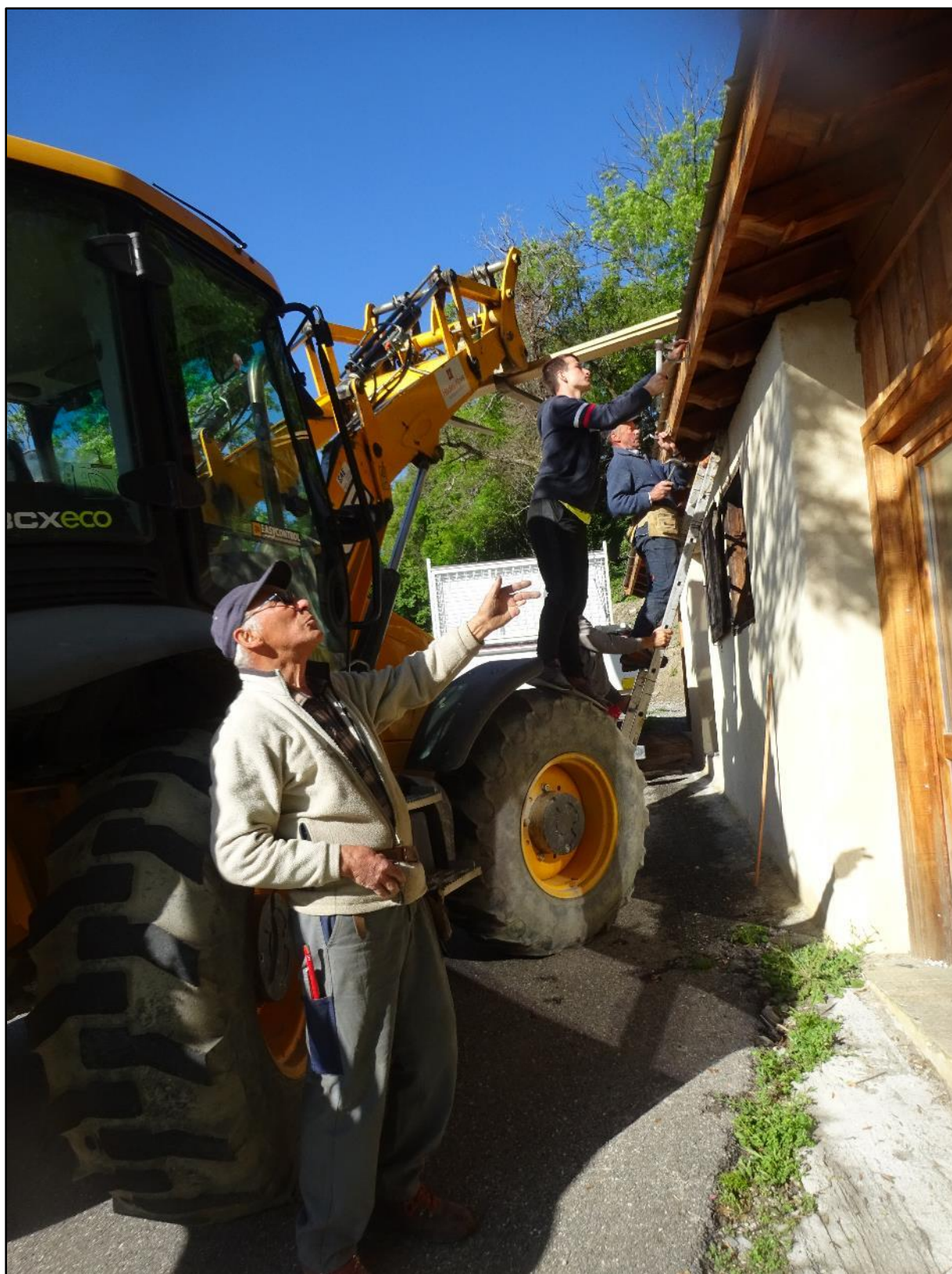
Image n°7 : installer une gouttière
