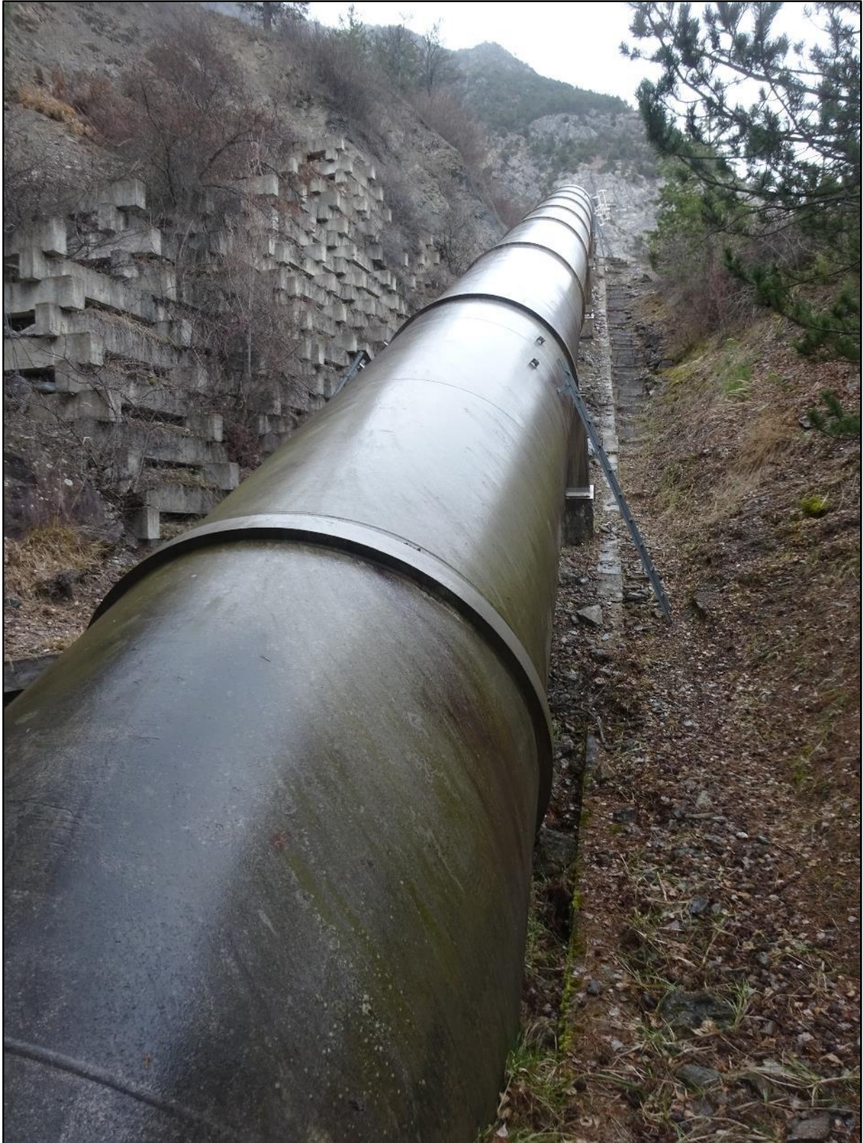
Image 13 : l'arrivée de la conduite forcée
