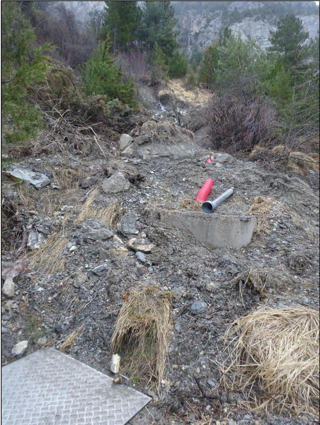
Image 17 : arrivée à une zone d'éboulement
