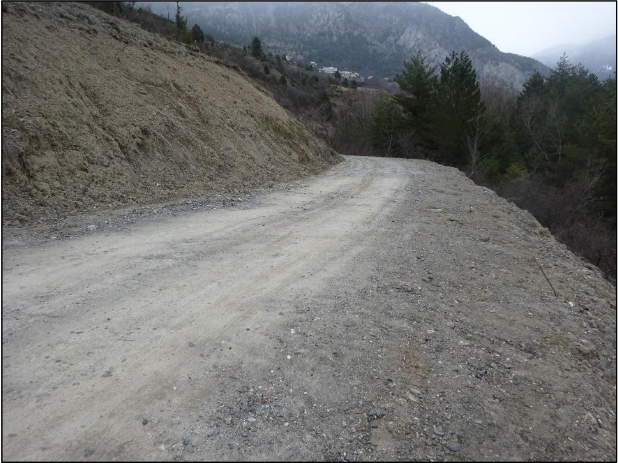
Image 2 : la chaussée remise en état
