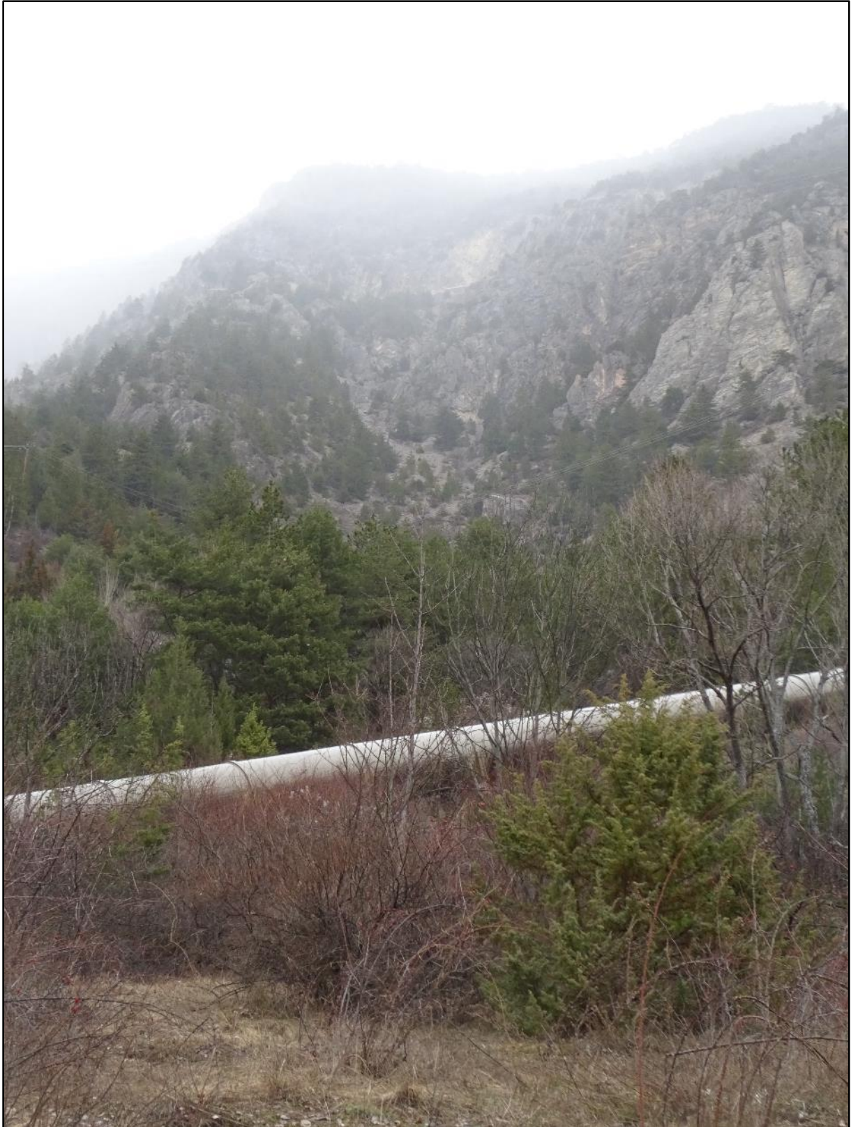
Image 16 : vue sur la conduite
