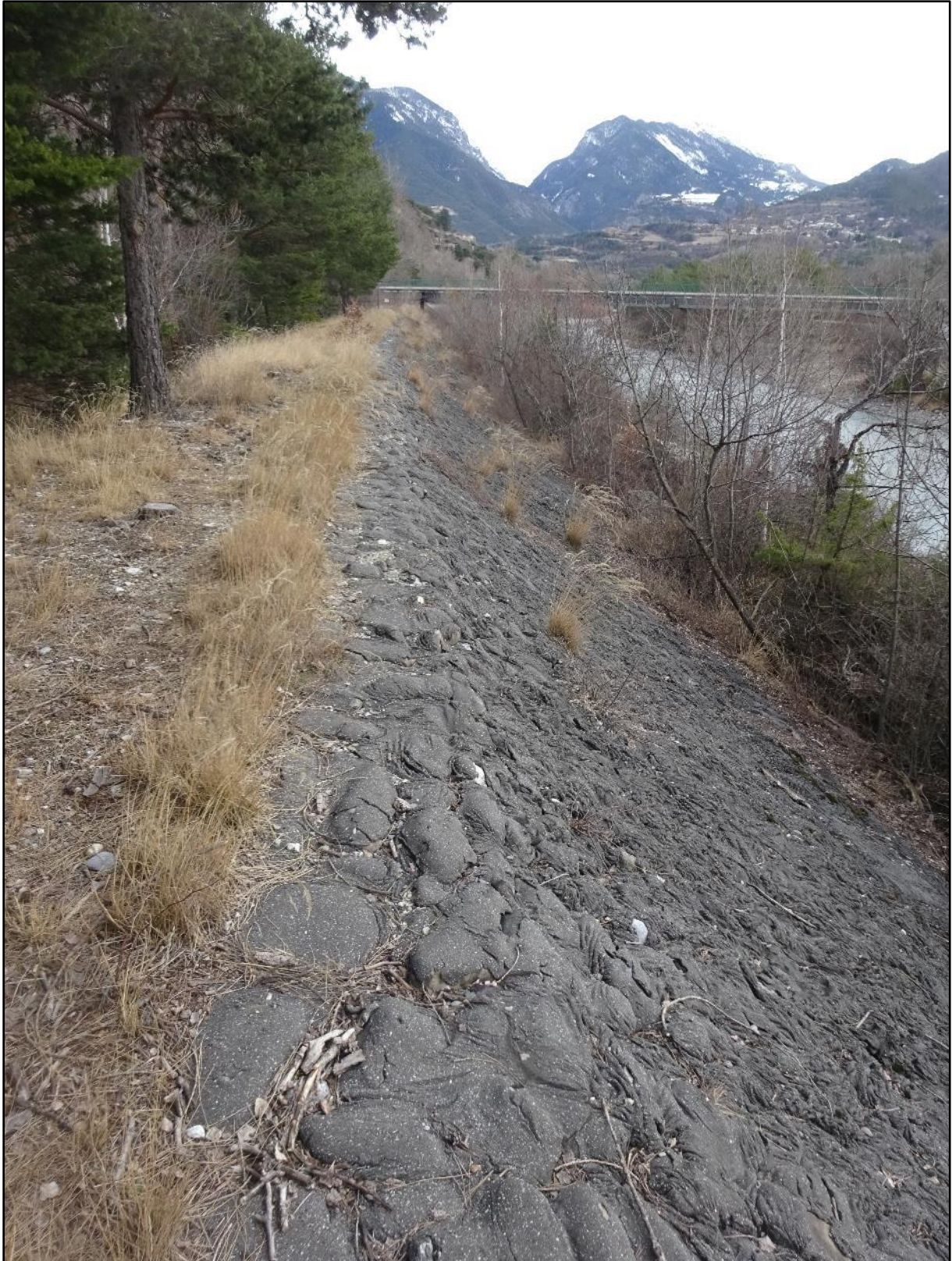
Image 3 : la digue imperméabilisée
