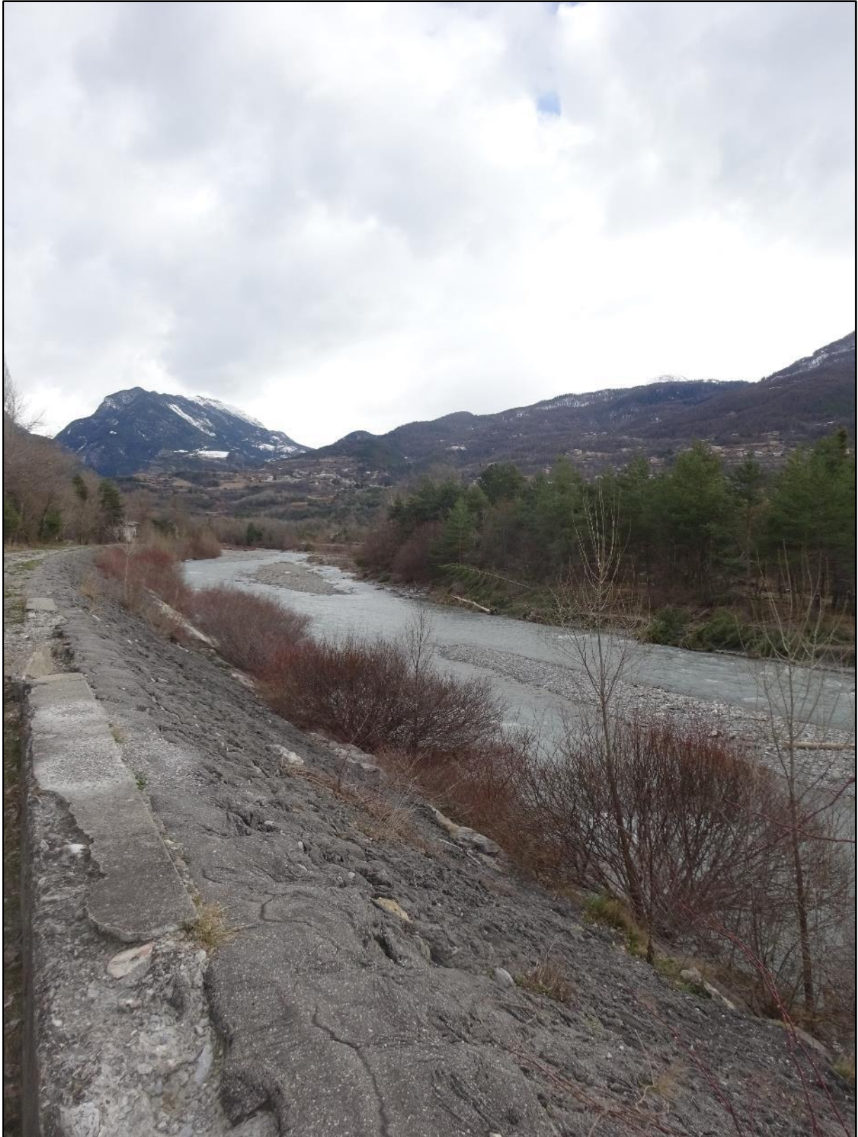
Image 6 : la poursuite de la digue
