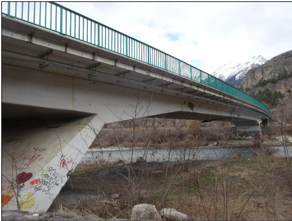
Image 11 : le pont vu de la rive gauche
