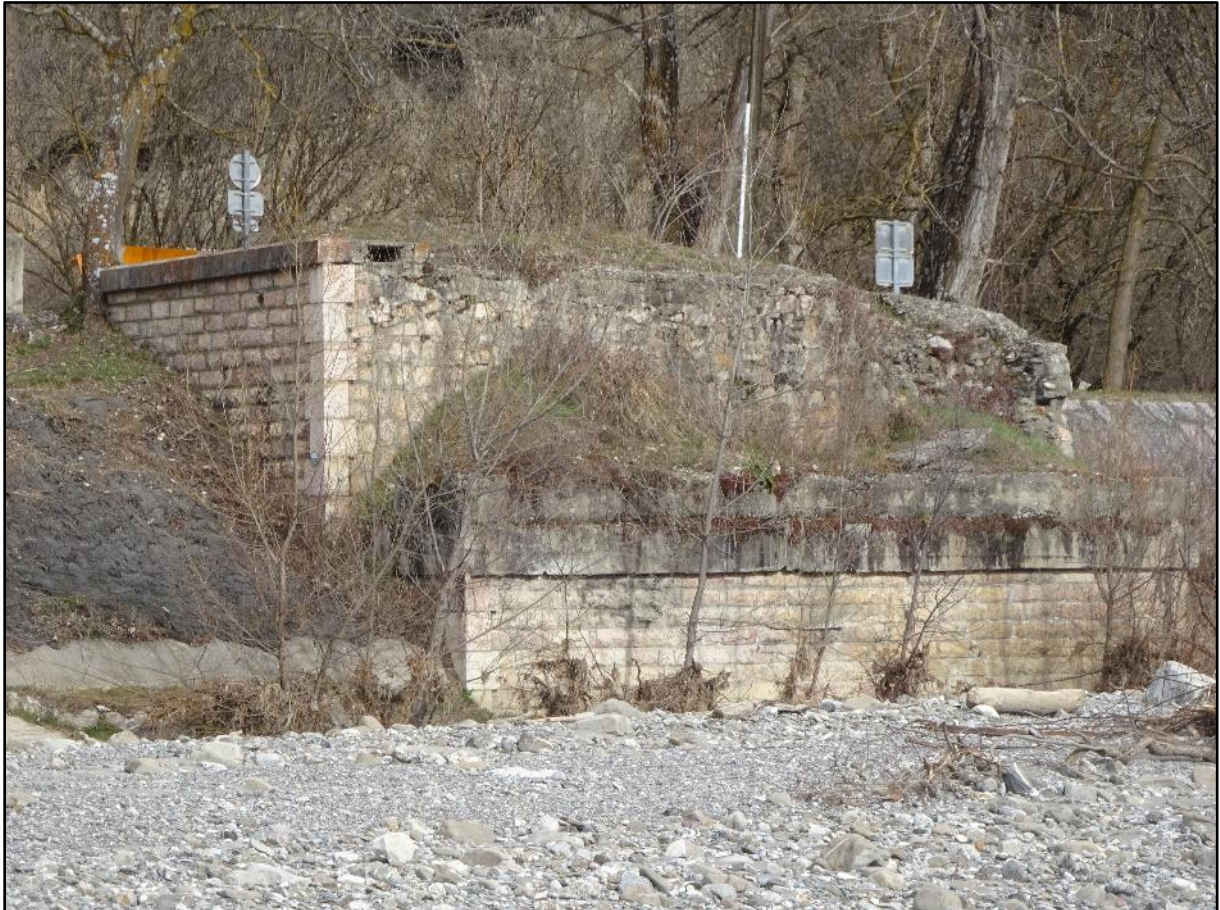
Image 15 : l'ancien pont de la nationale
