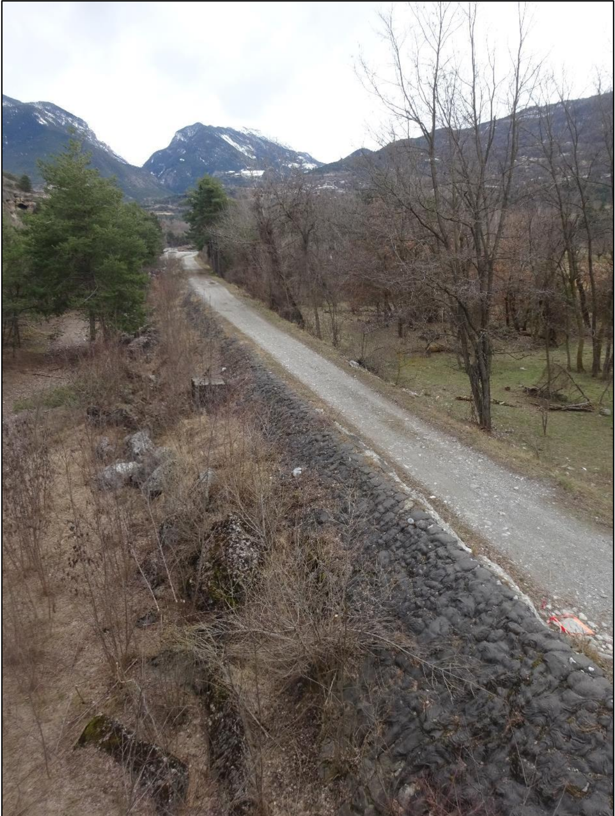
Image 10 : la digue en rive gauche
