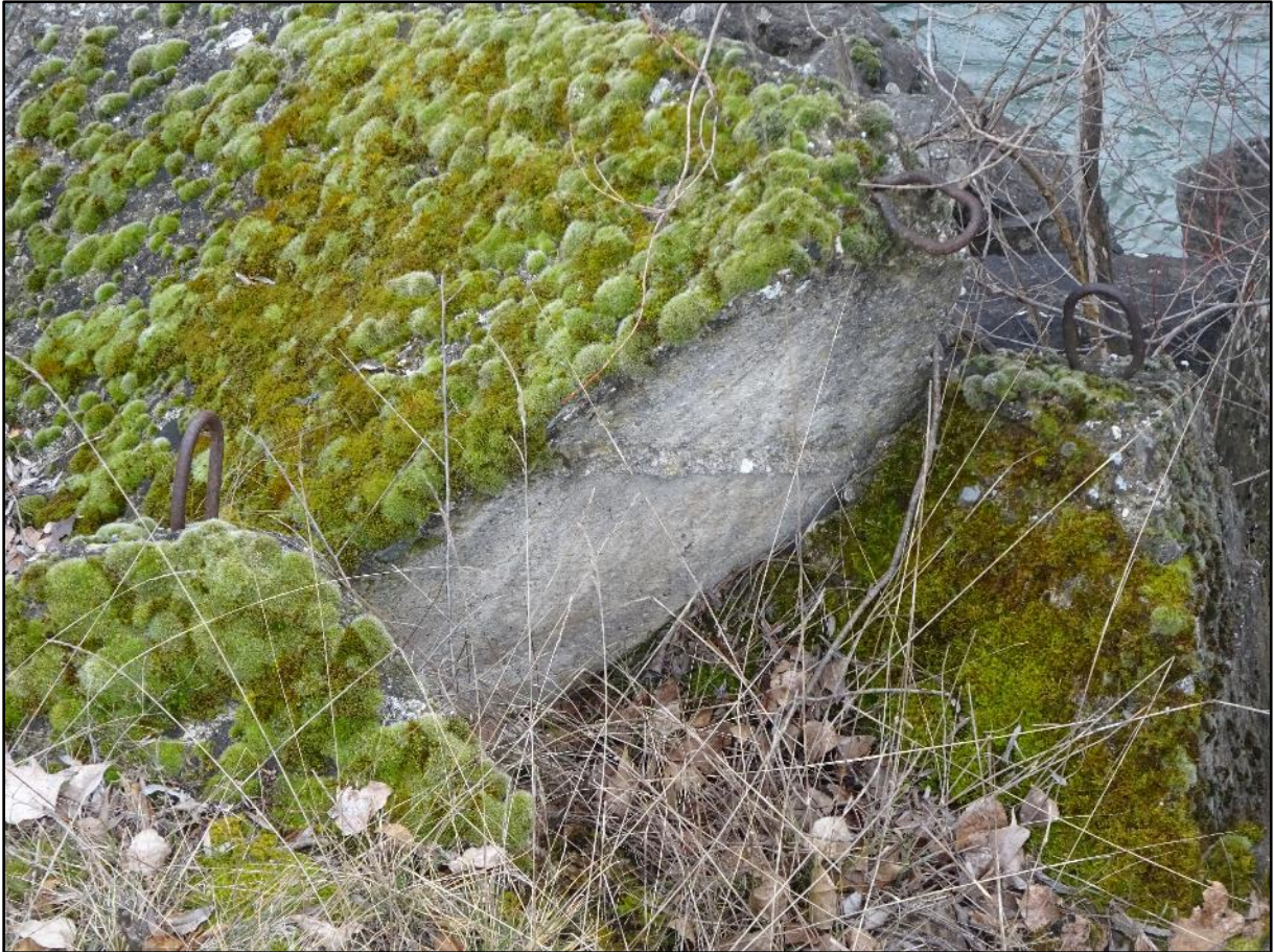
Image 4 : protection de la digue
