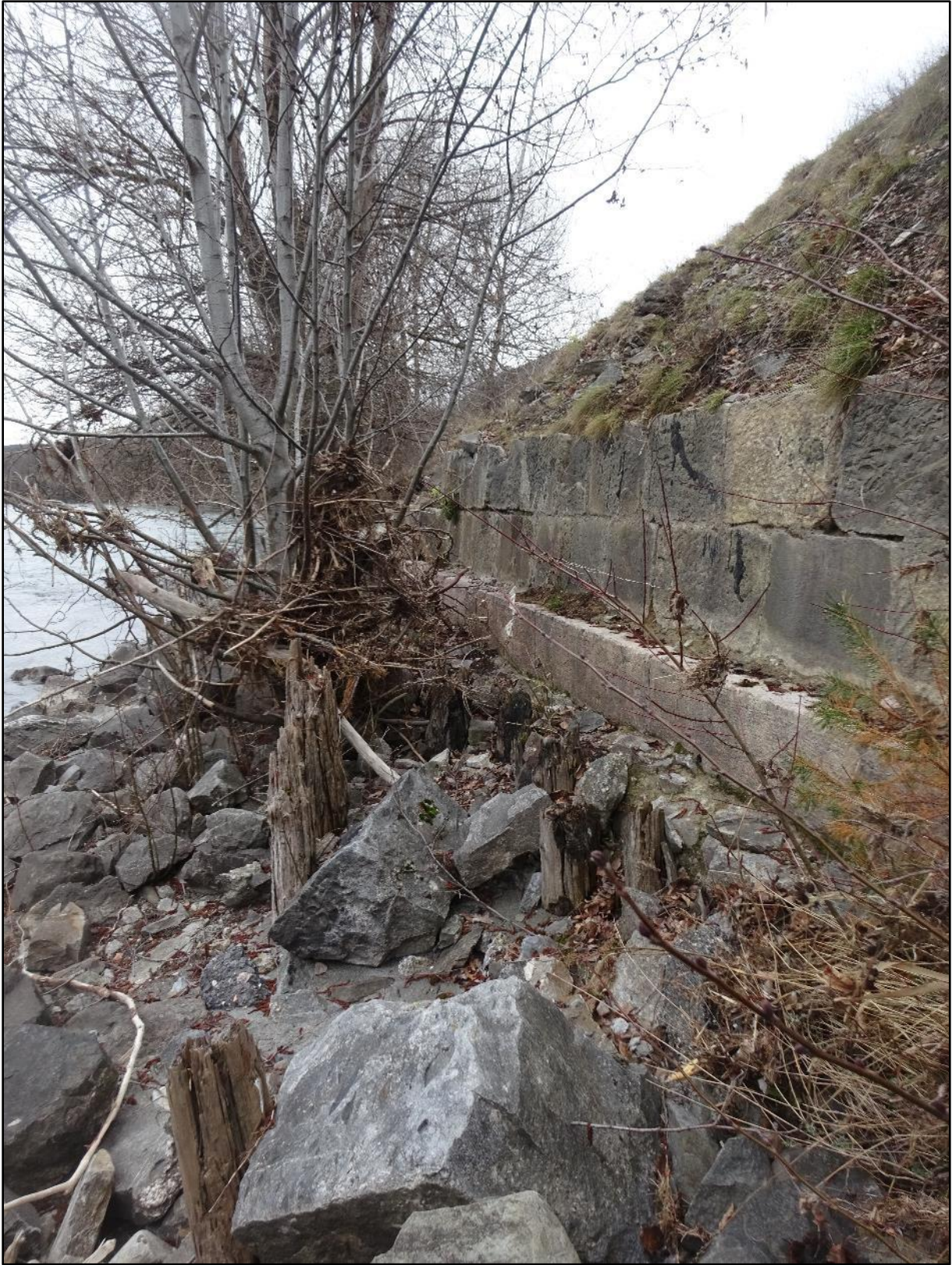
Vue vers l'aval, avec des pieux verticaux fichés au-devant de l'ouvrage.
