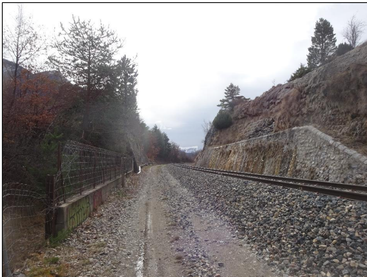
Image 18 : la tranchée ferroviaire
