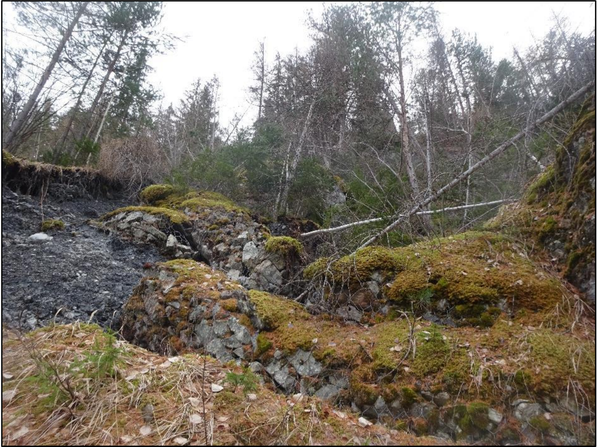
Image 7 : séries de gabions renversés
