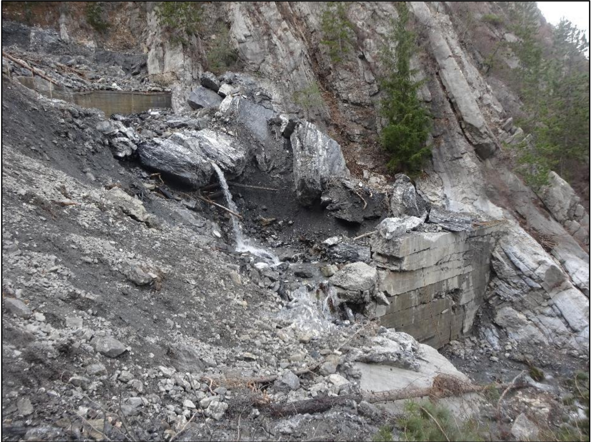
Image 13 : entre les deux seuils
