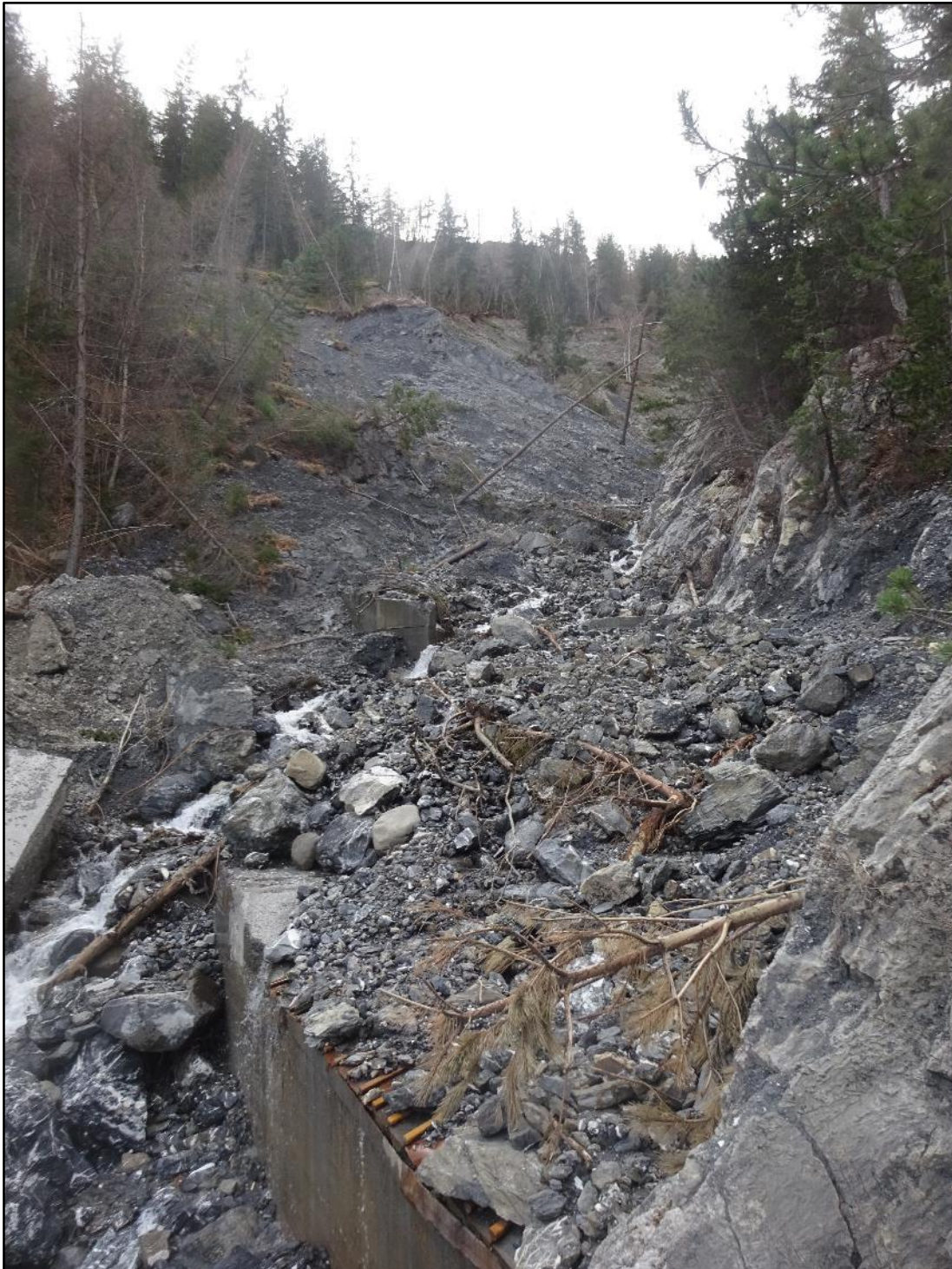
Image 19 : en amont du seuil supérieur
