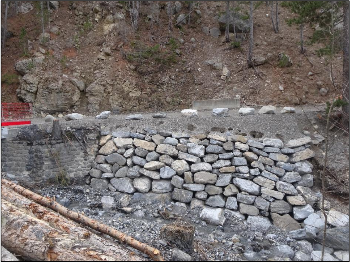
Image 3 : un enrochement en rive gauche
