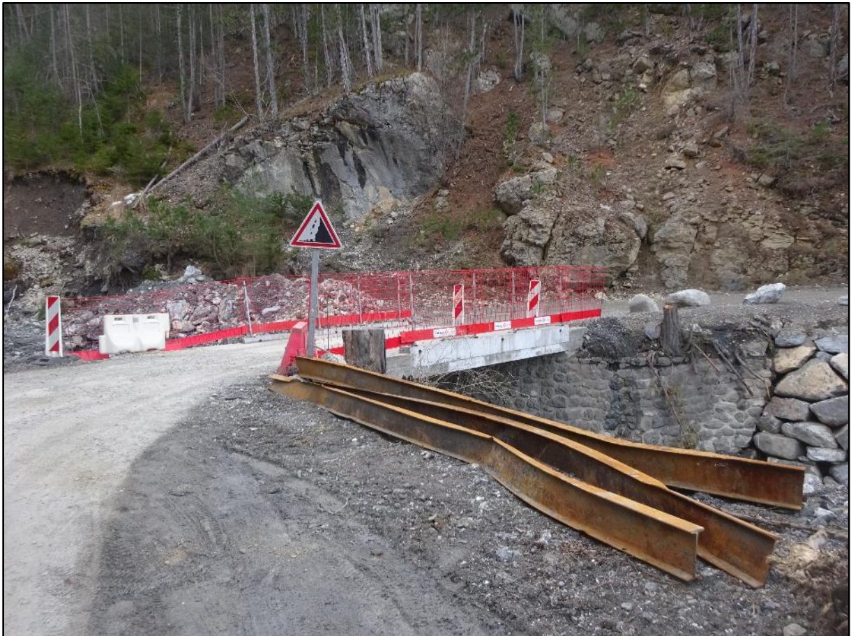
Image 1 : le nouveau pont de Barbein
