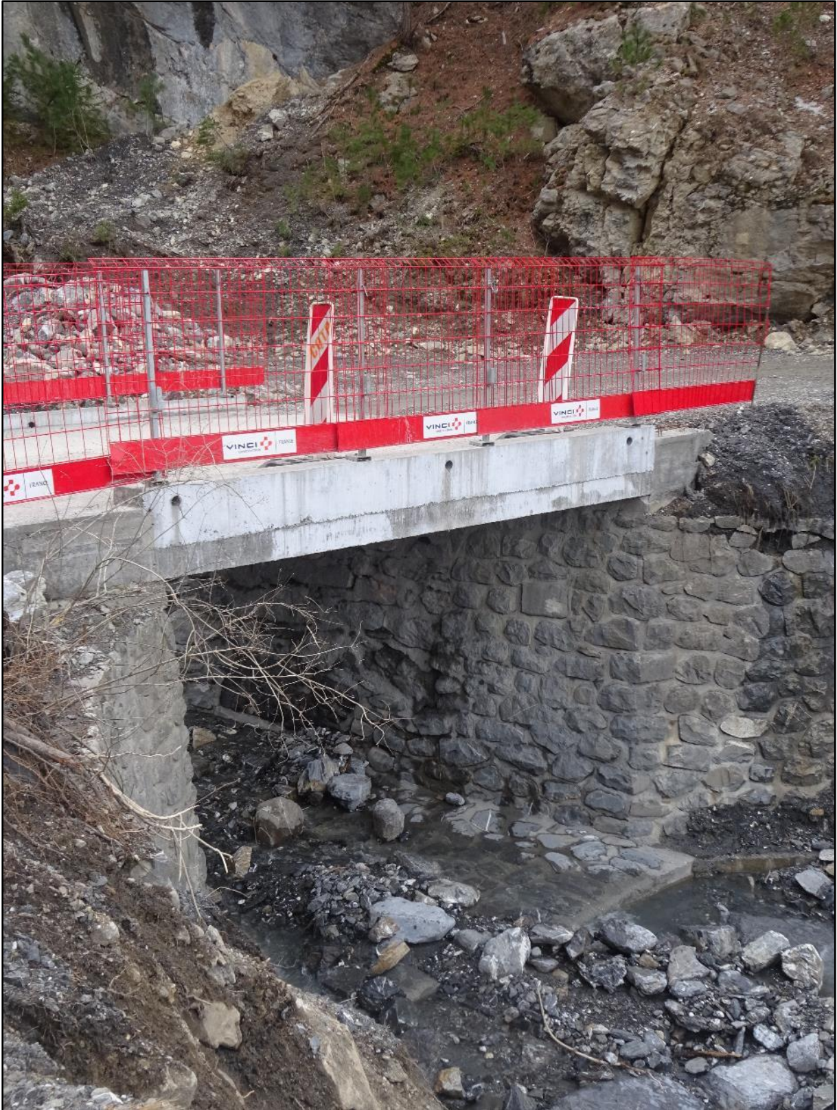
Image 2 : le nouveau pont de Barbein
