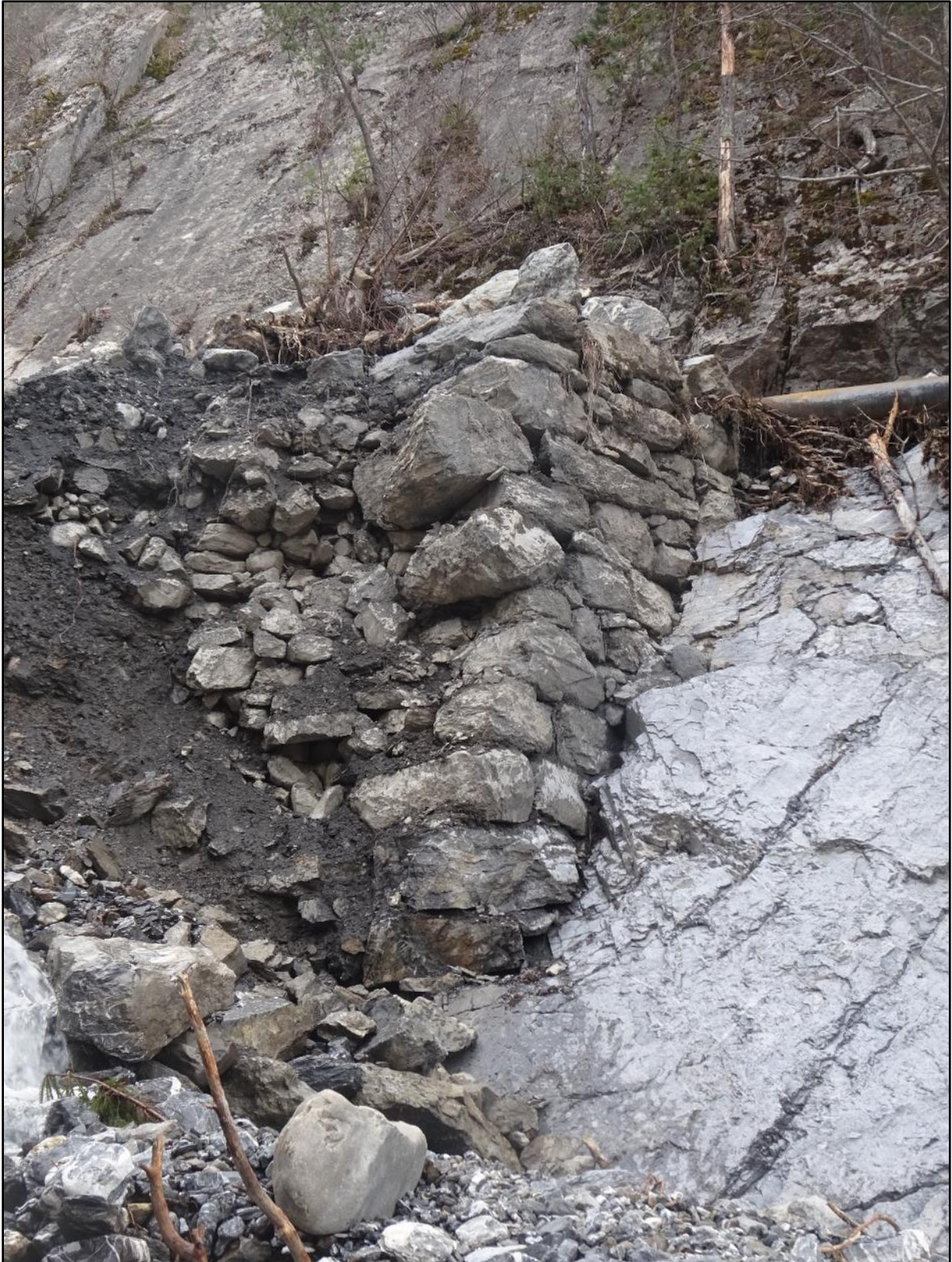
Image 16 : l'ancrage en rive gauche
