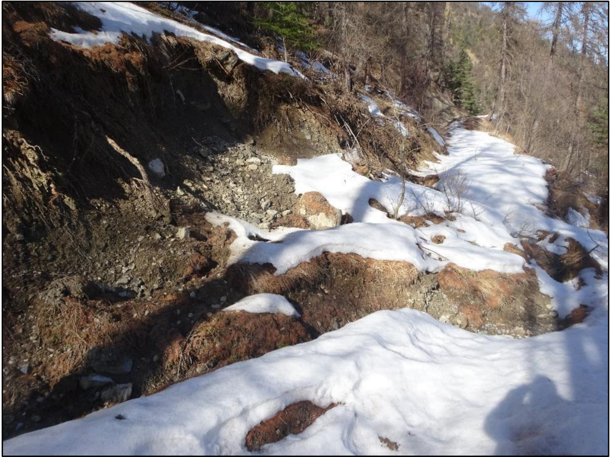
Image 10 : glissement de terrain
