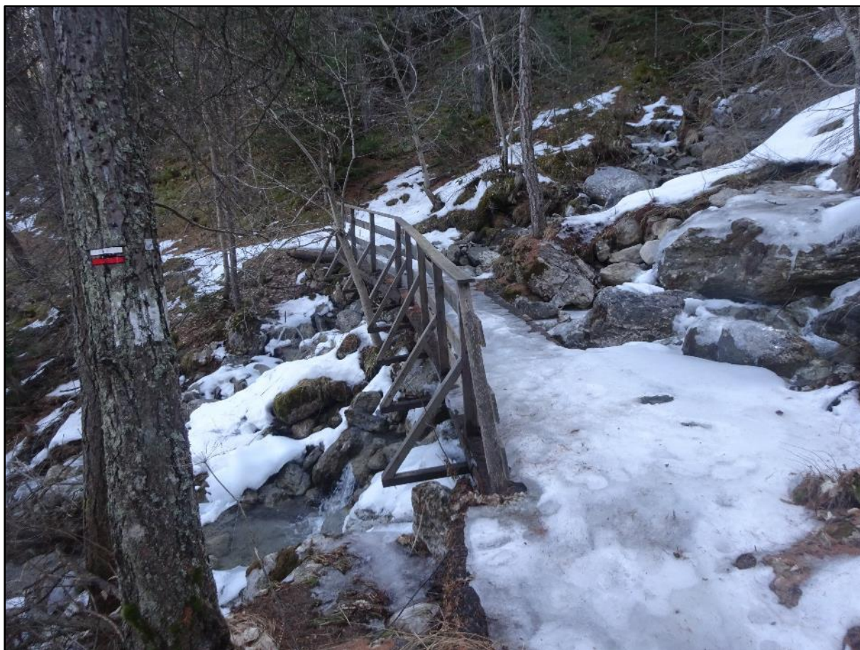
Image 11 : la passerelle sur le torrent
