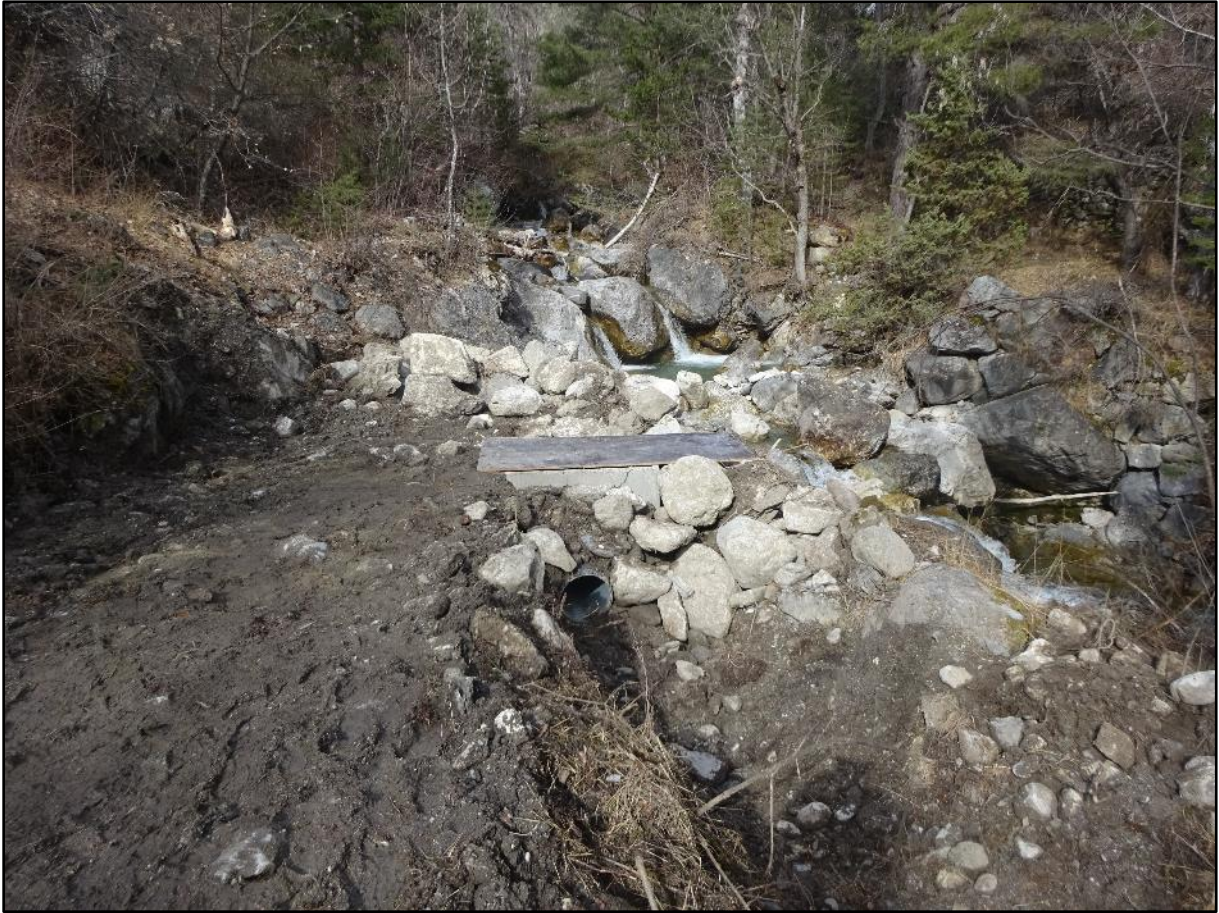
Image 23 : travaux en bordure de torrent
