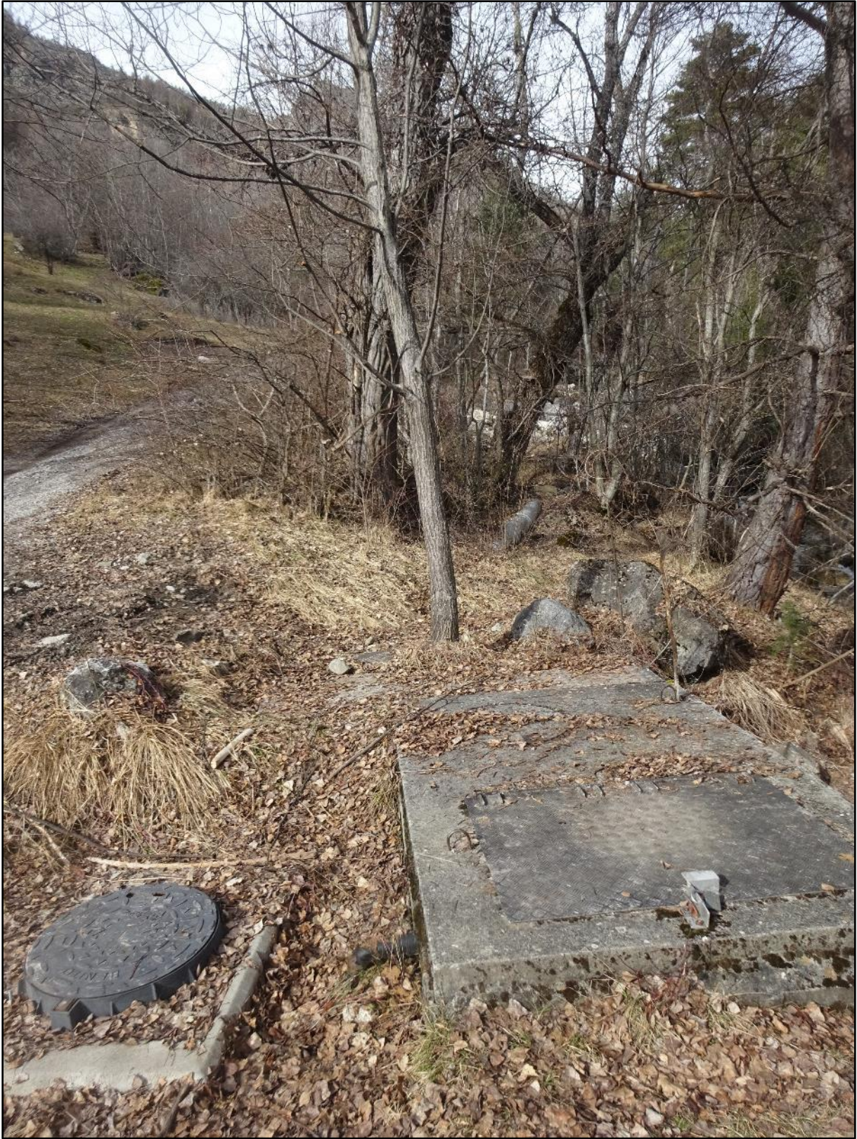
Passage d'une canalisation souterraine plus moderne.
