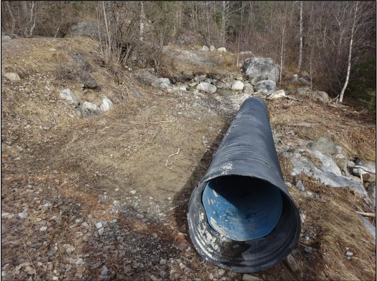
Image 24 : travaux en bord de torrent
