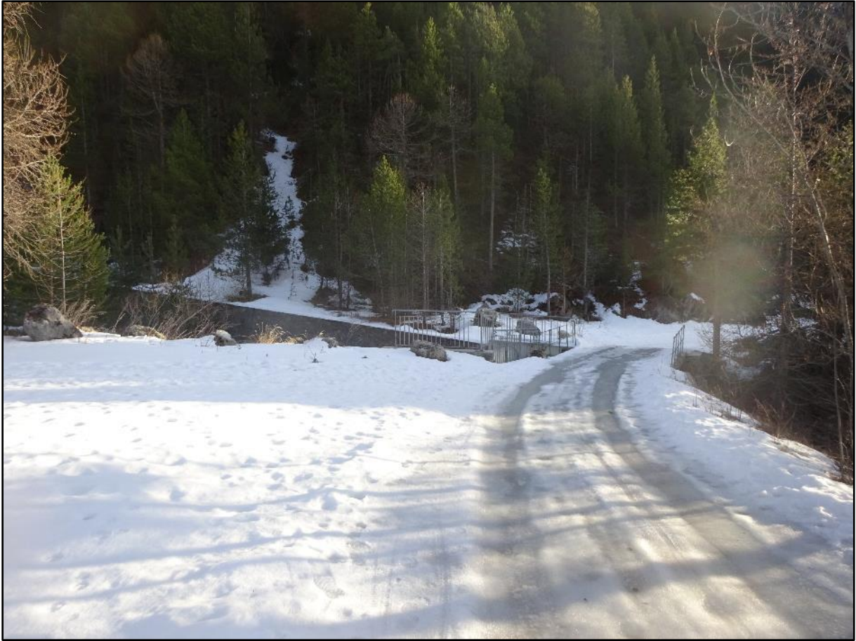
Le pont, ses barrières et en amont une longue digue bétonnée.
