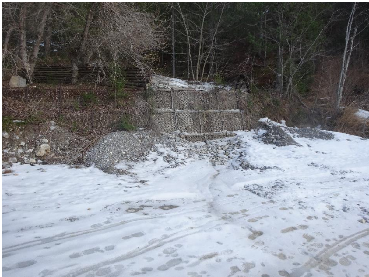
Image 24 : treillis métalliques en bordure de route
