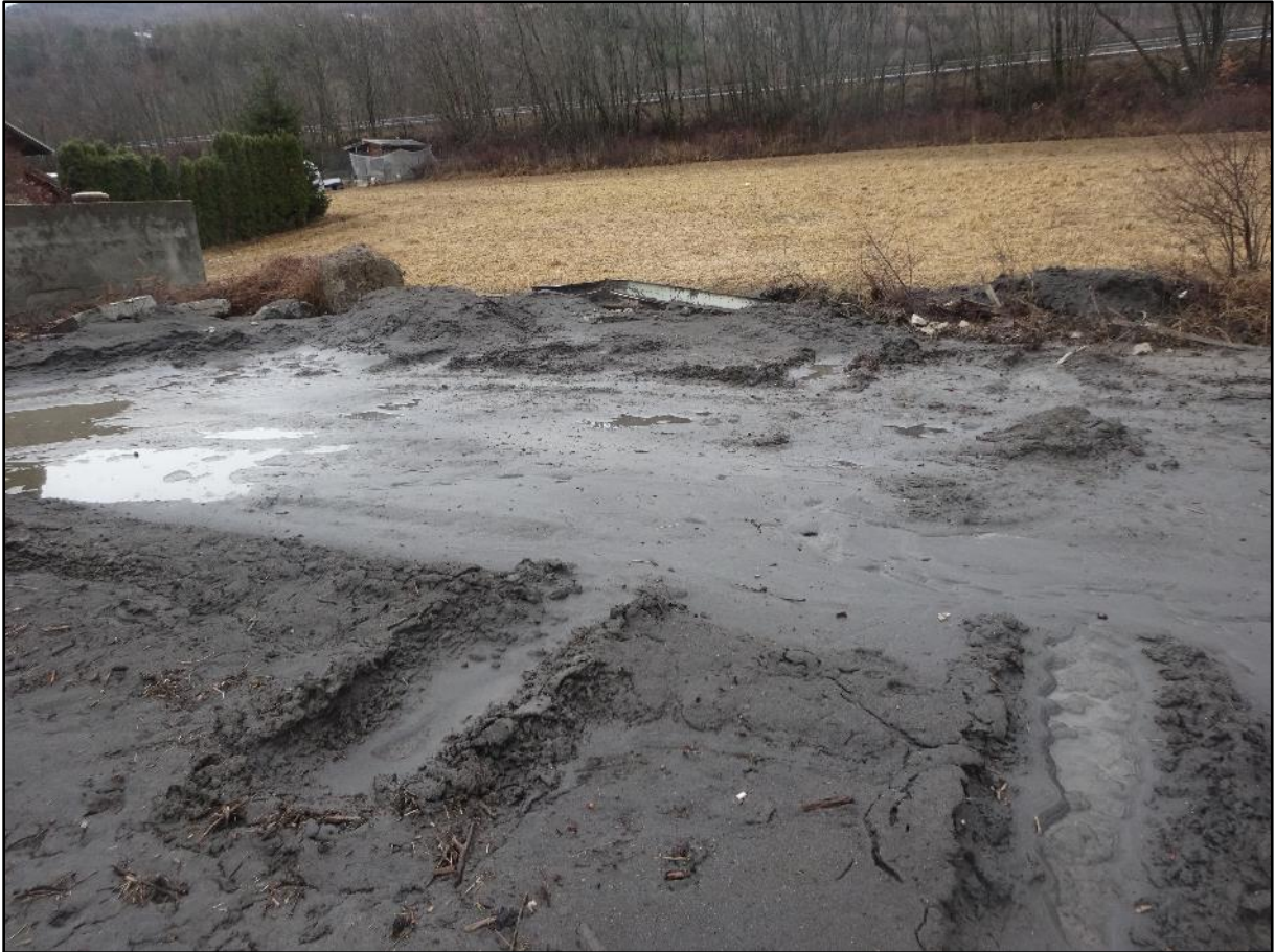
Image 4 : sous la route de Guillestre
