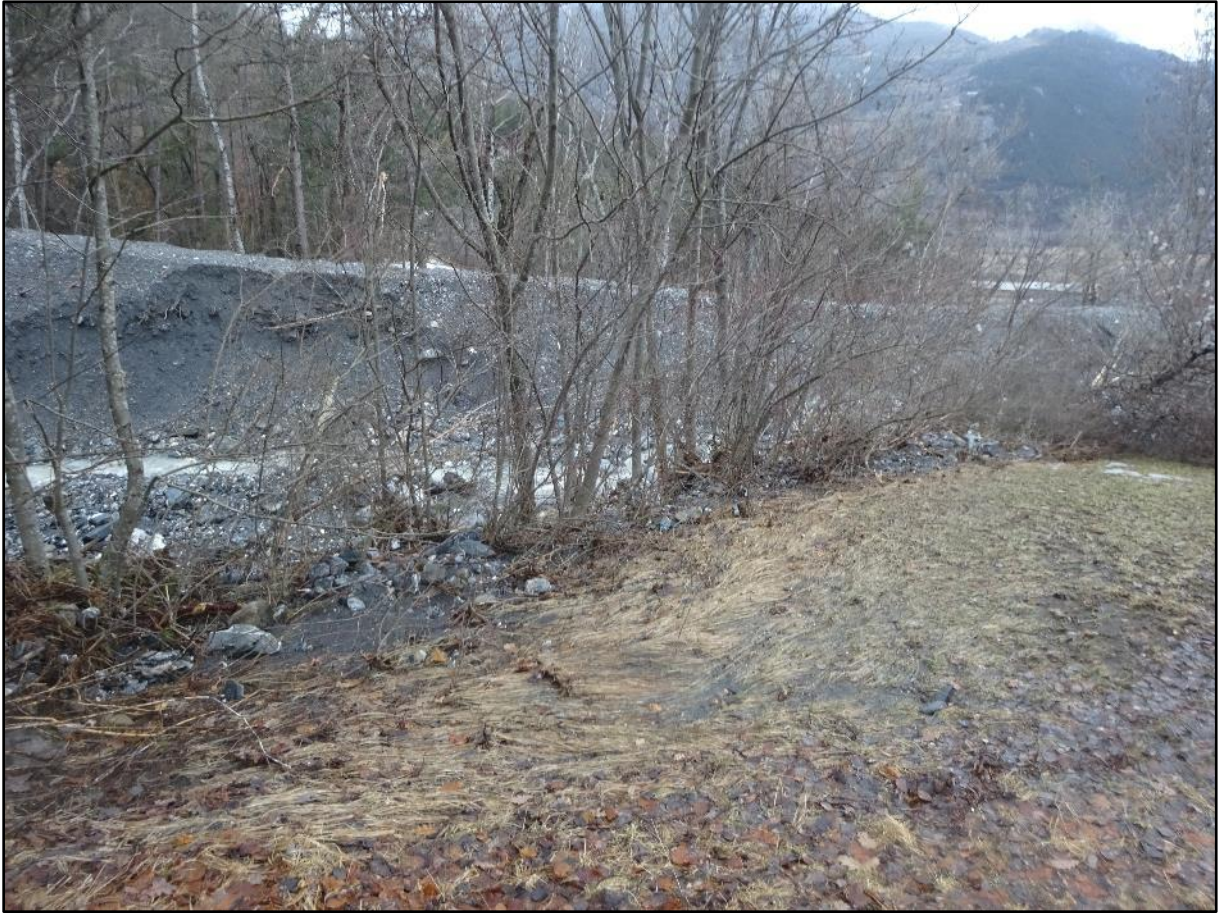
Image 9 : l'eau est passée
