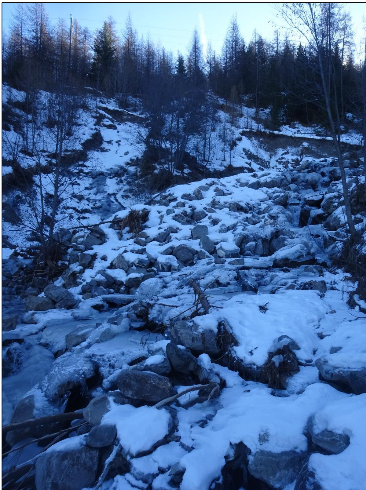
Image 26 : en amont du plus haut seuil
