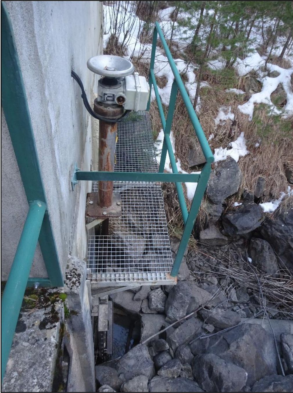
Image 24 : la vanne côté aval de l'édicule
