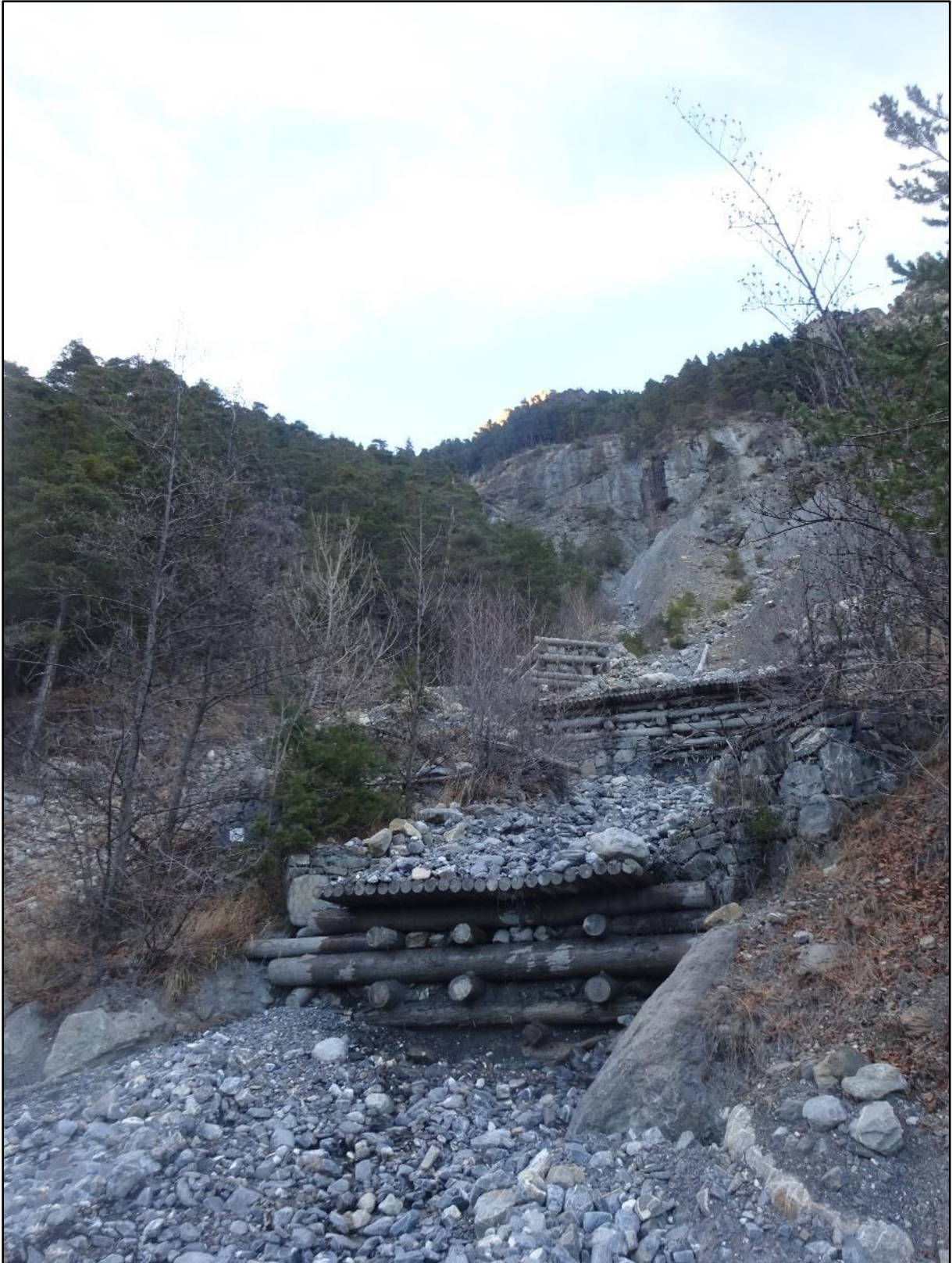
Image 20 : ouvrages de protection de la piste
