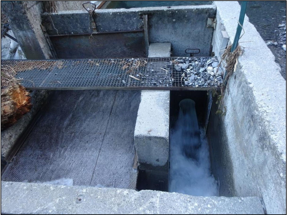
Image 28 : deux entrées d'eau
