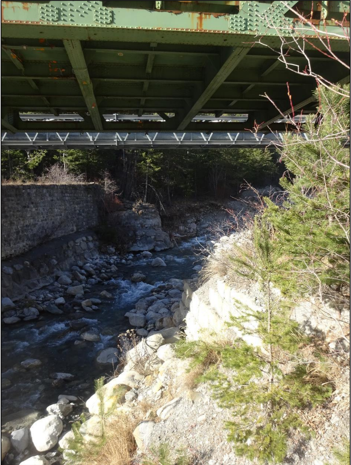
Image 21 : sous le pont routier
