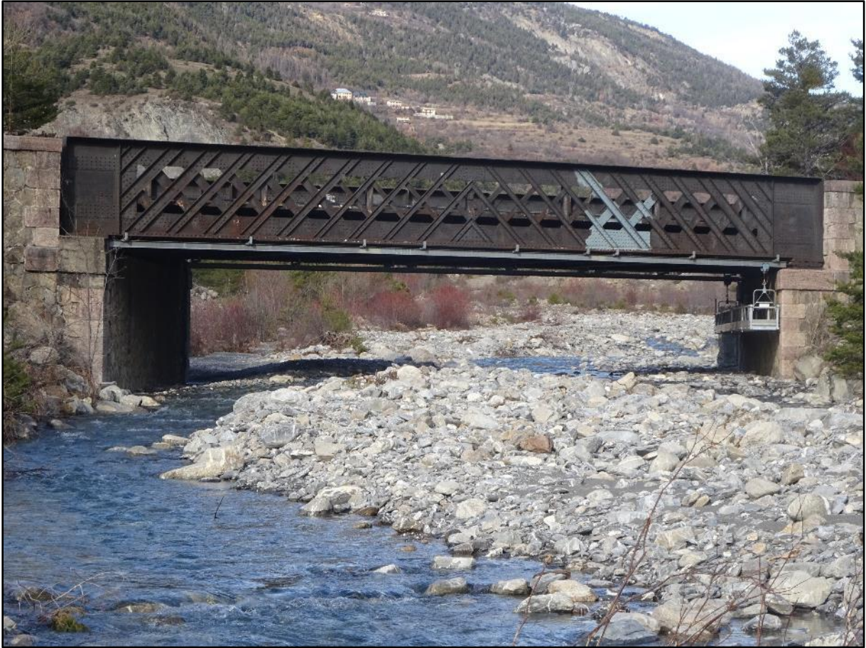
Image 10 : le pont ferroviaire vu de près
