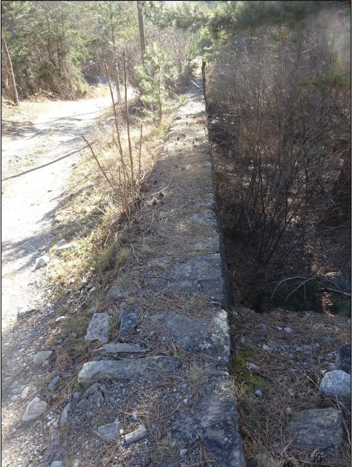
Image 25 : la digue plus en amont
