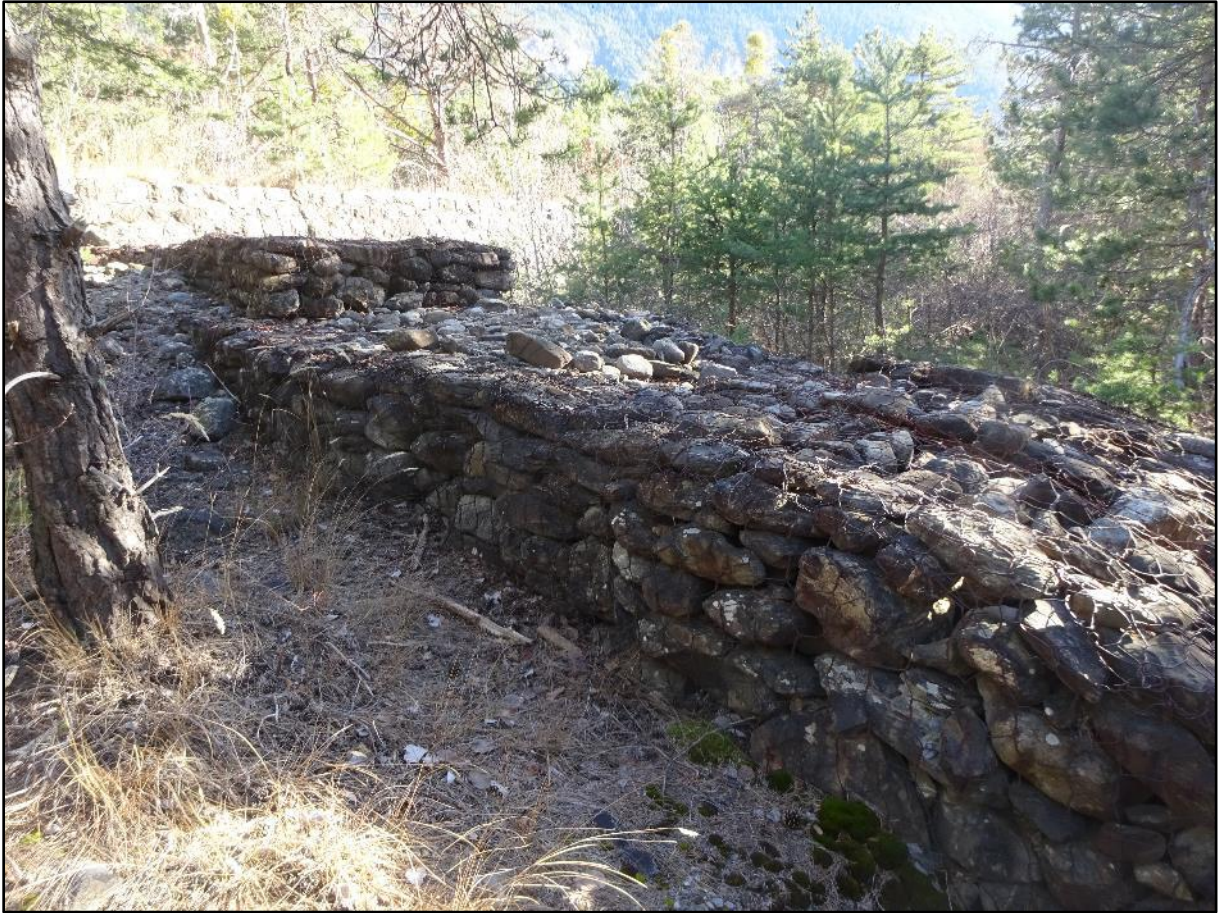
Somme de larges gabions perpendiculaires au cours d'eau et à la digue.
