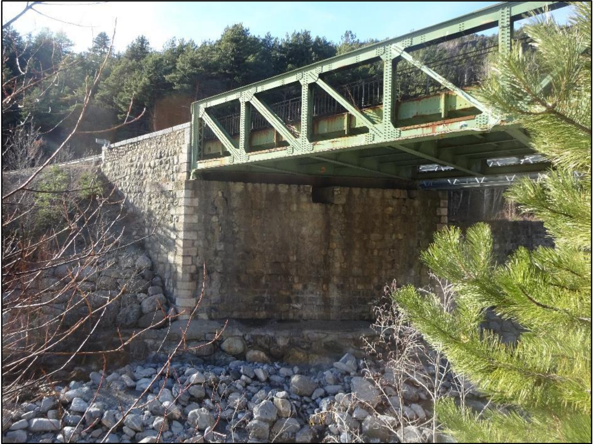
Image 19 : le pont et sa base en rive droite
