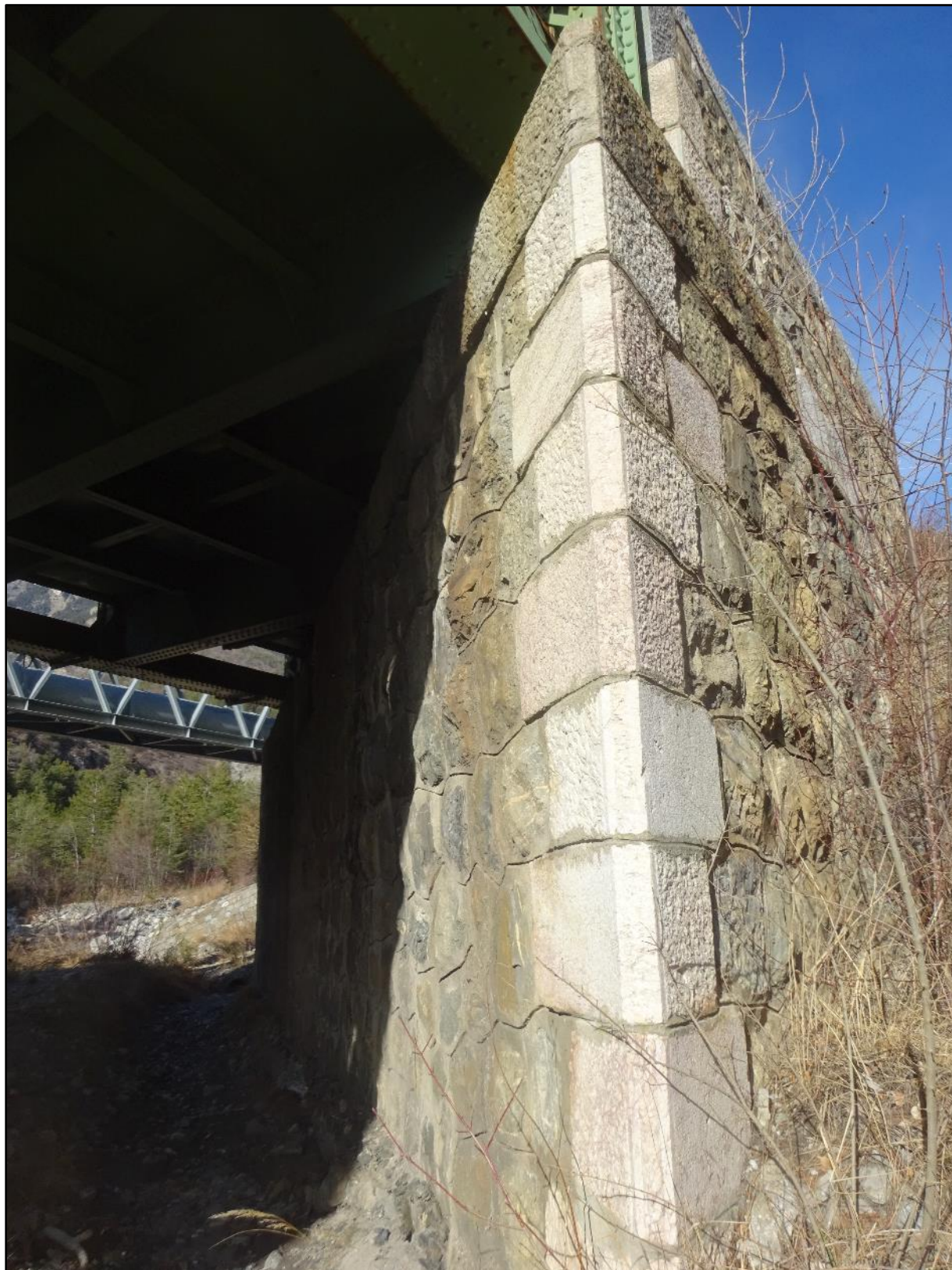
Image 22 : le pont en rive gauche
