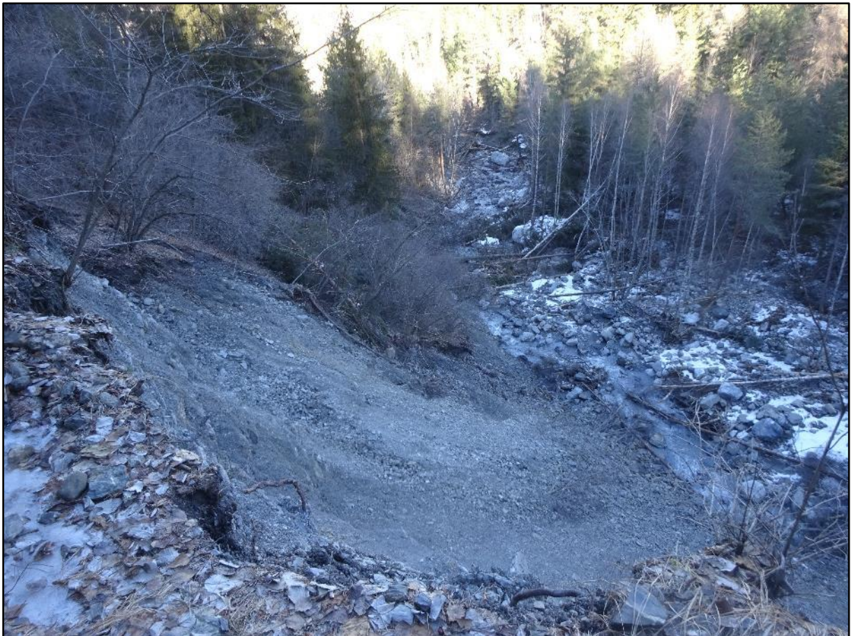
Image 1 : vue des dégâts par en haut
