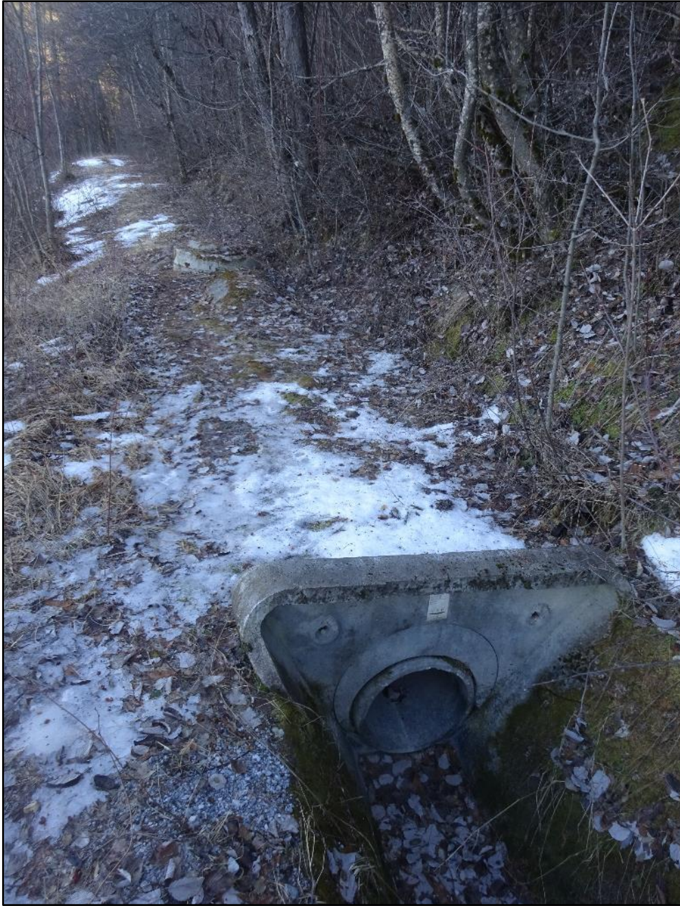
Image 6 : fin de portion busée et enterrée
