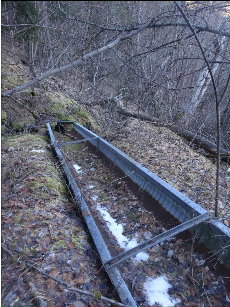
Image 7 : une section avec demi-buse en tôle ondulée
