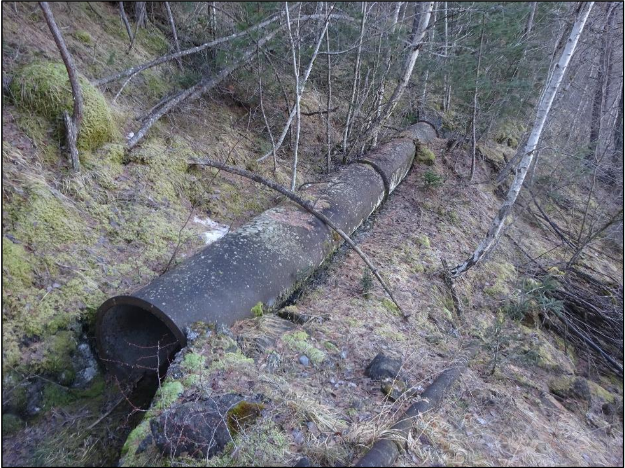
Image 6 : une section avec canalisation métallique
