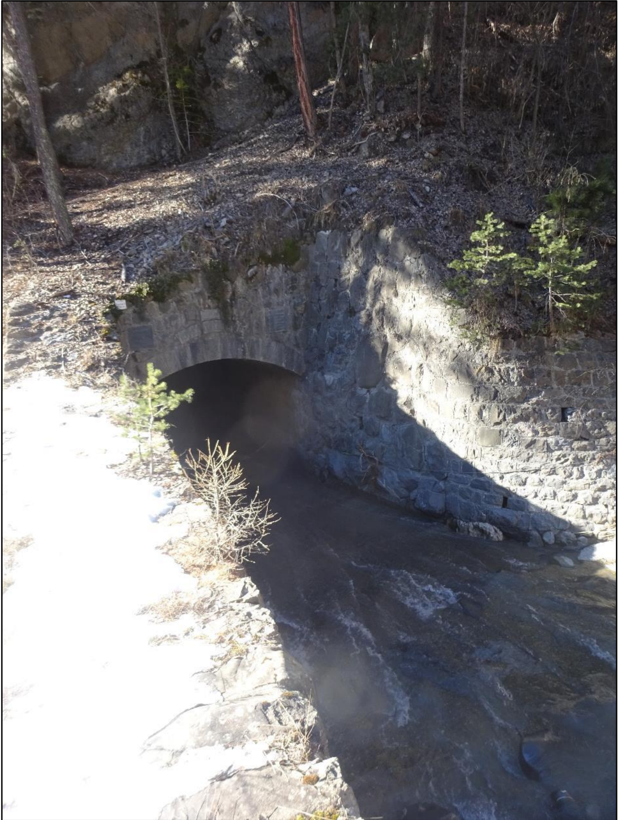
Image 3 : le tunnel du Chagne
