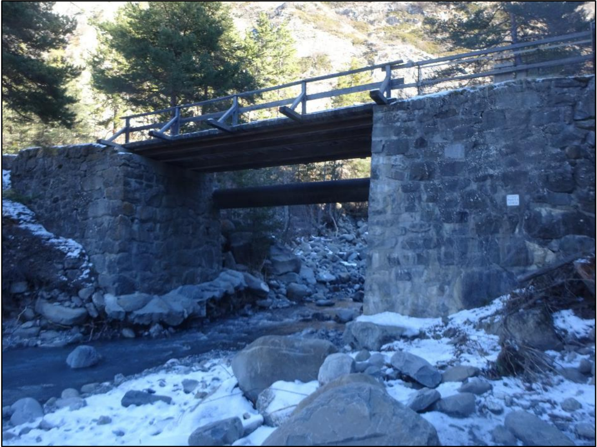
Image 20 : sous le pont de Panacelle
