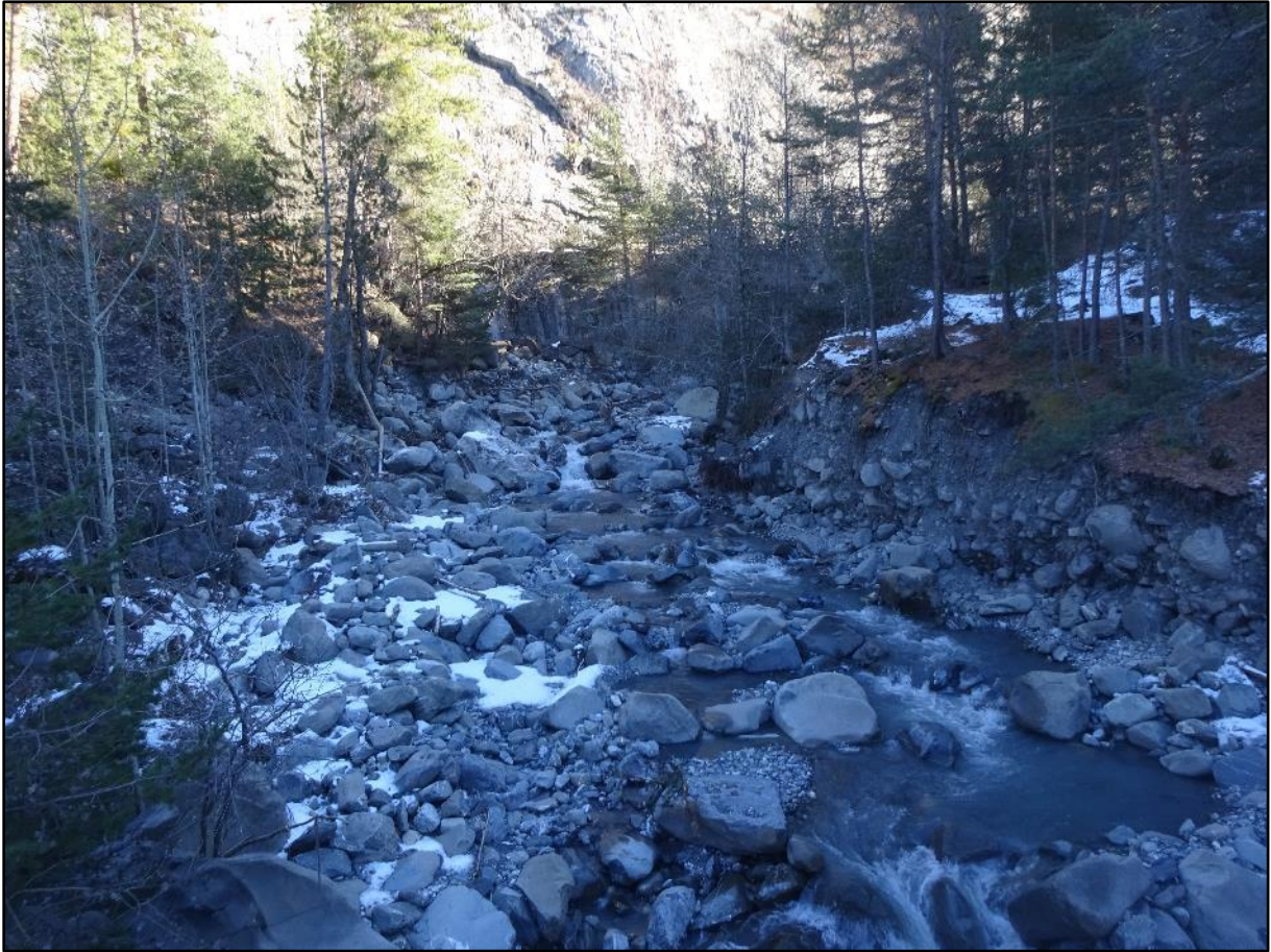
Image 21 : en amont depuis le pont
