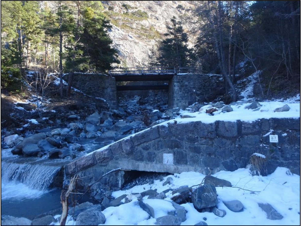
Image 19 : le seuil intermédiaire et le pont
