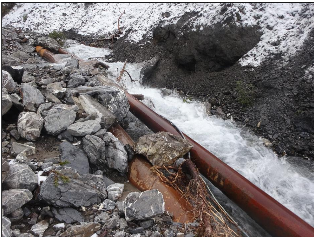
Image 18 : réapparition des conduites
