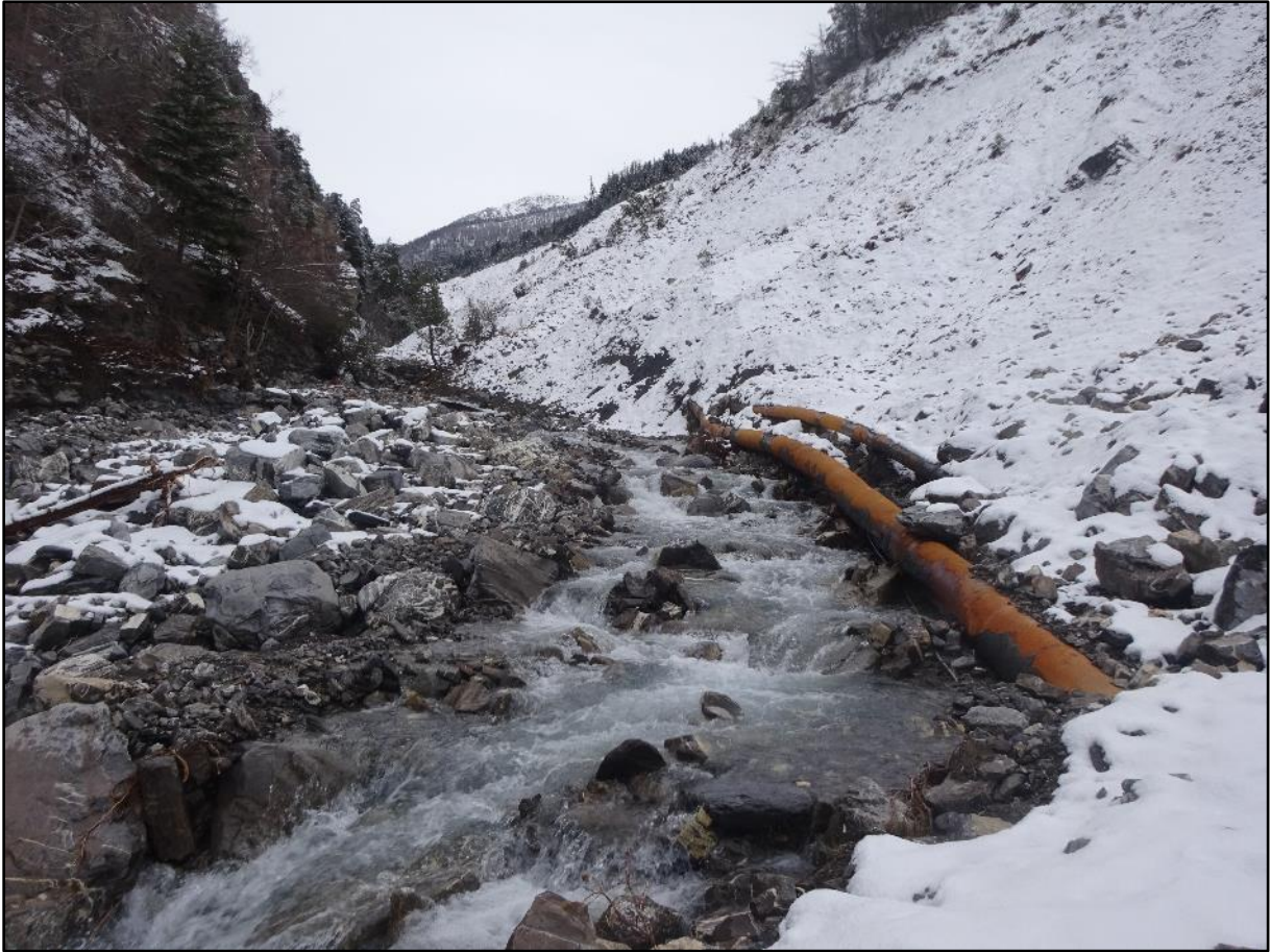
Image 22 : revoilà les conduites
