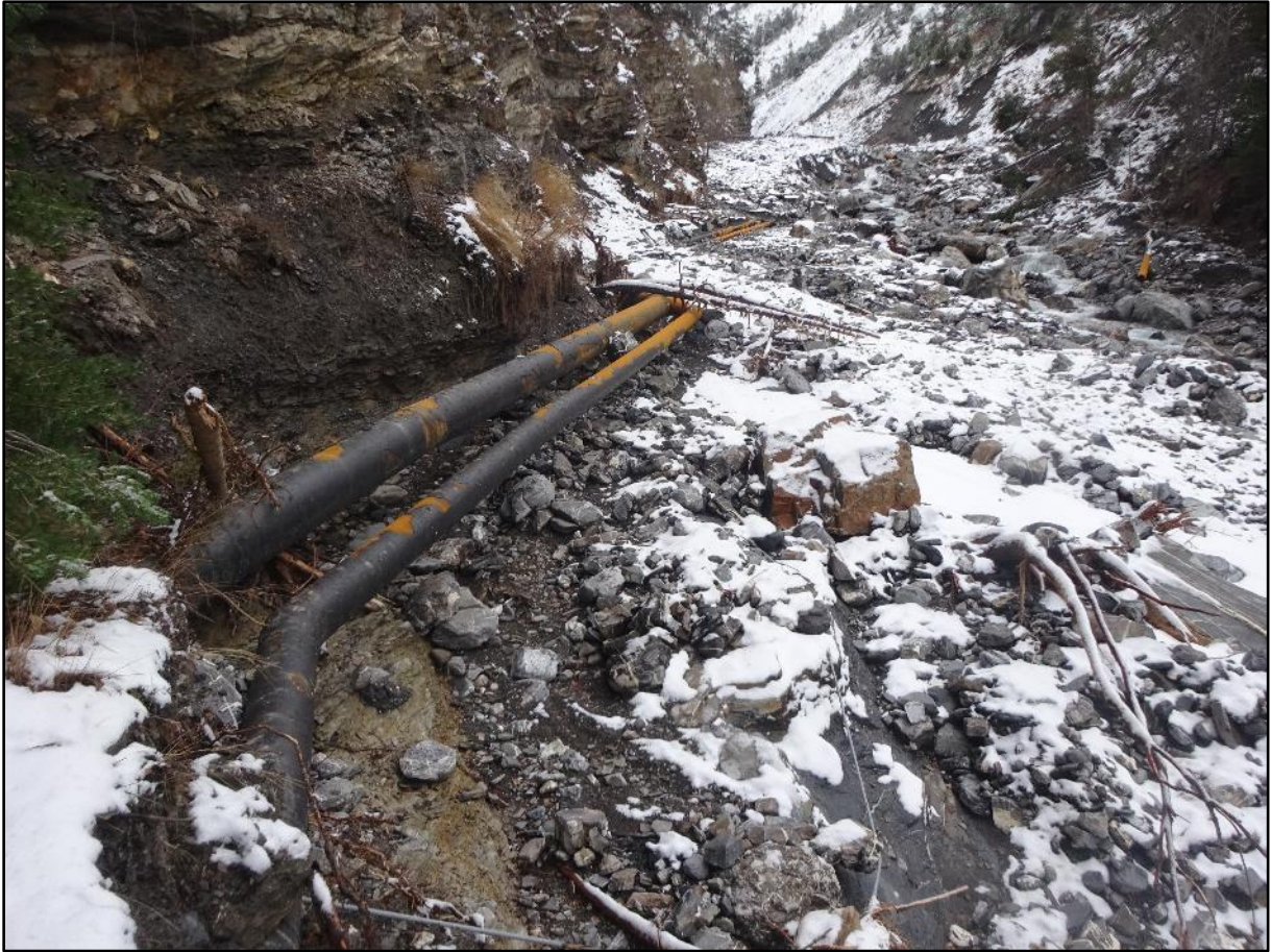
Image 10 : les conduites forcées
