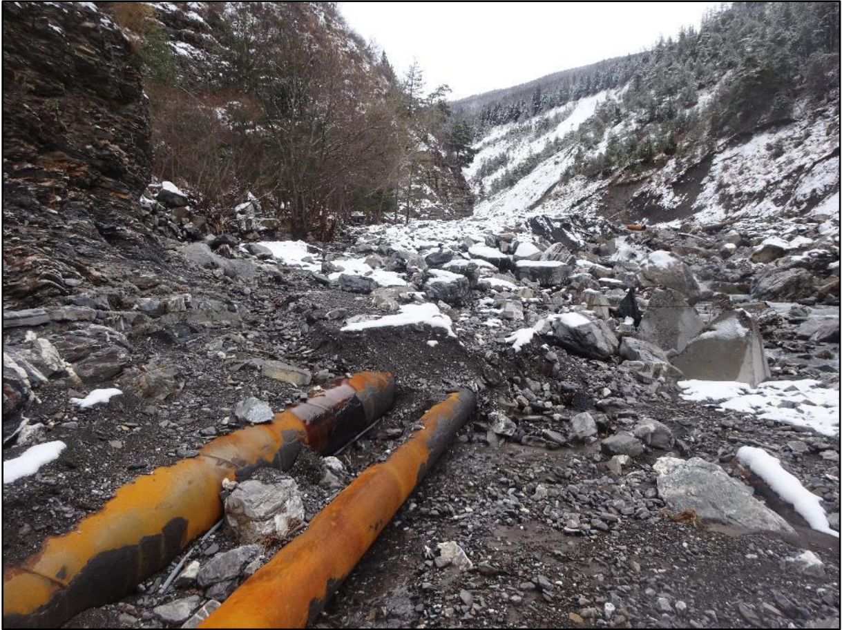
Image 13 : les conduites s'enfoncent sous le torrent
