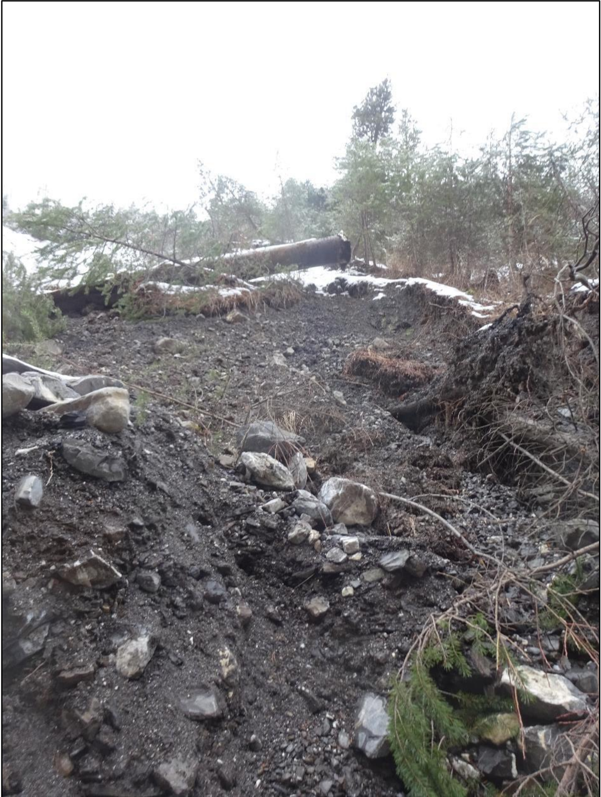
Image 20 : conduite pour l'arrosage
