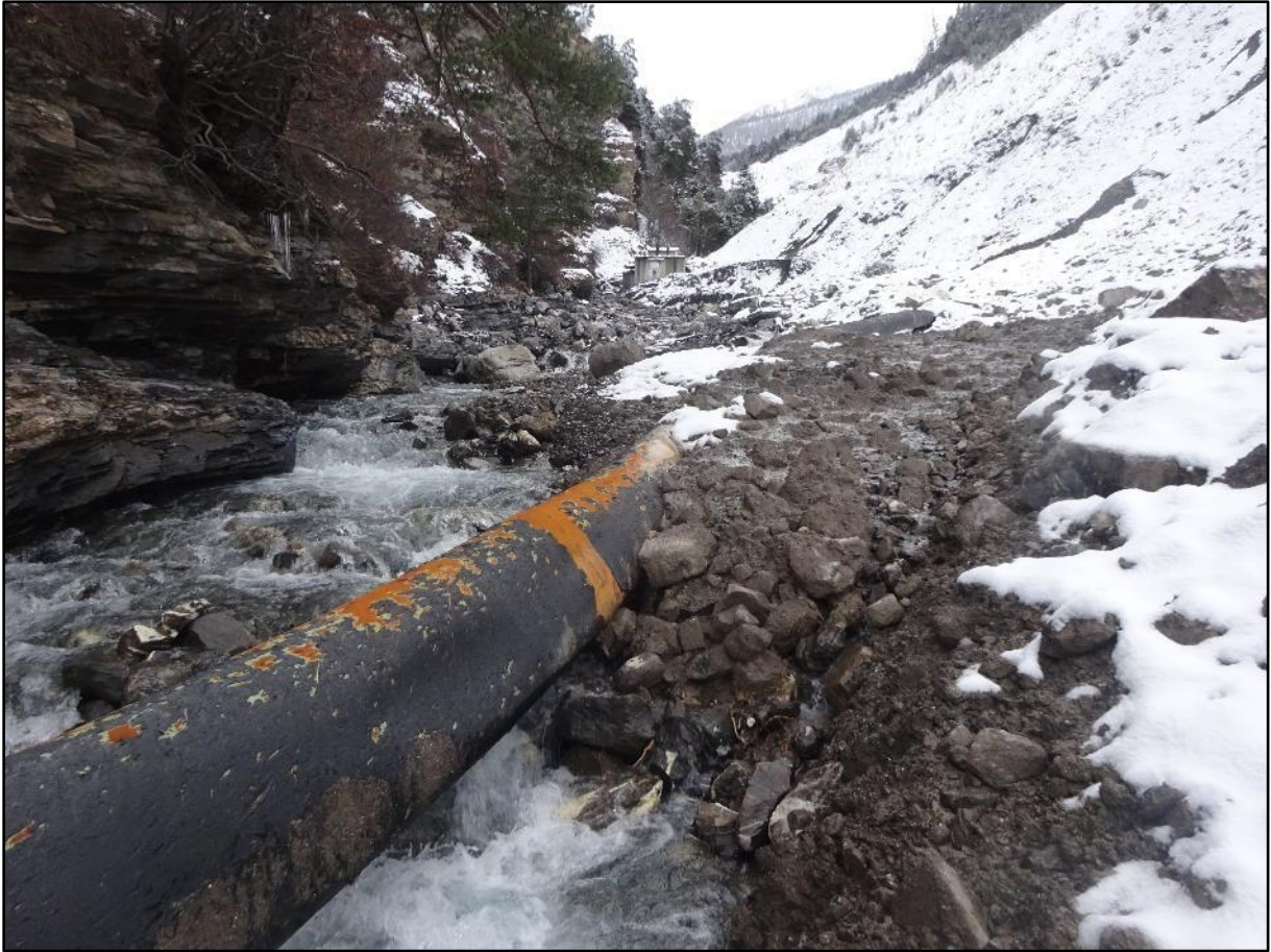
Image 25 : coulée de boue
