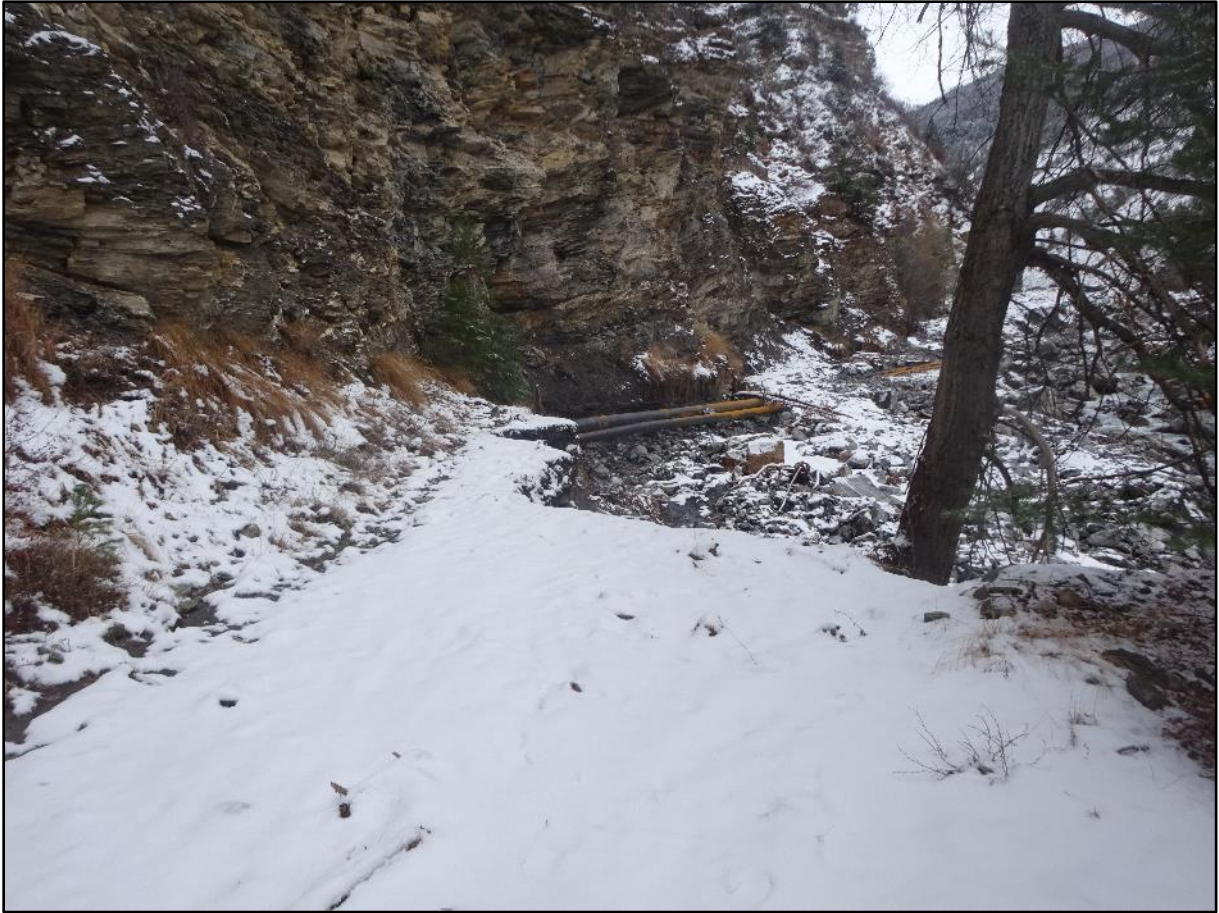
Image 9 : conduite forcée en vue
