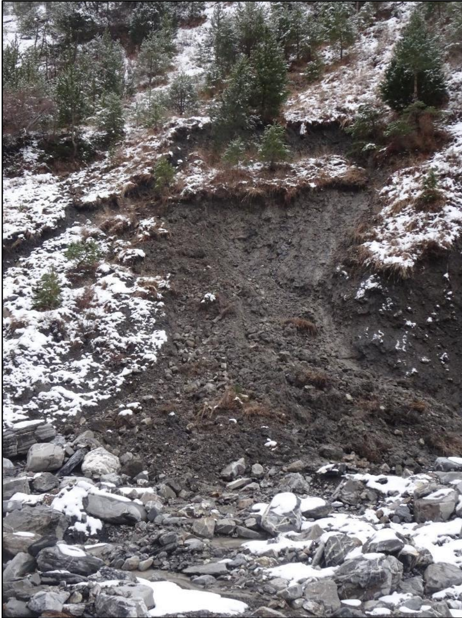
Image 15 : un éboulement en cours
