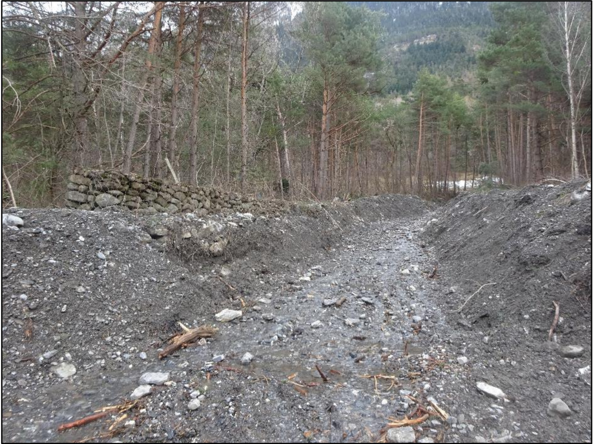
Image 6 : vieux gabion et endiguement
