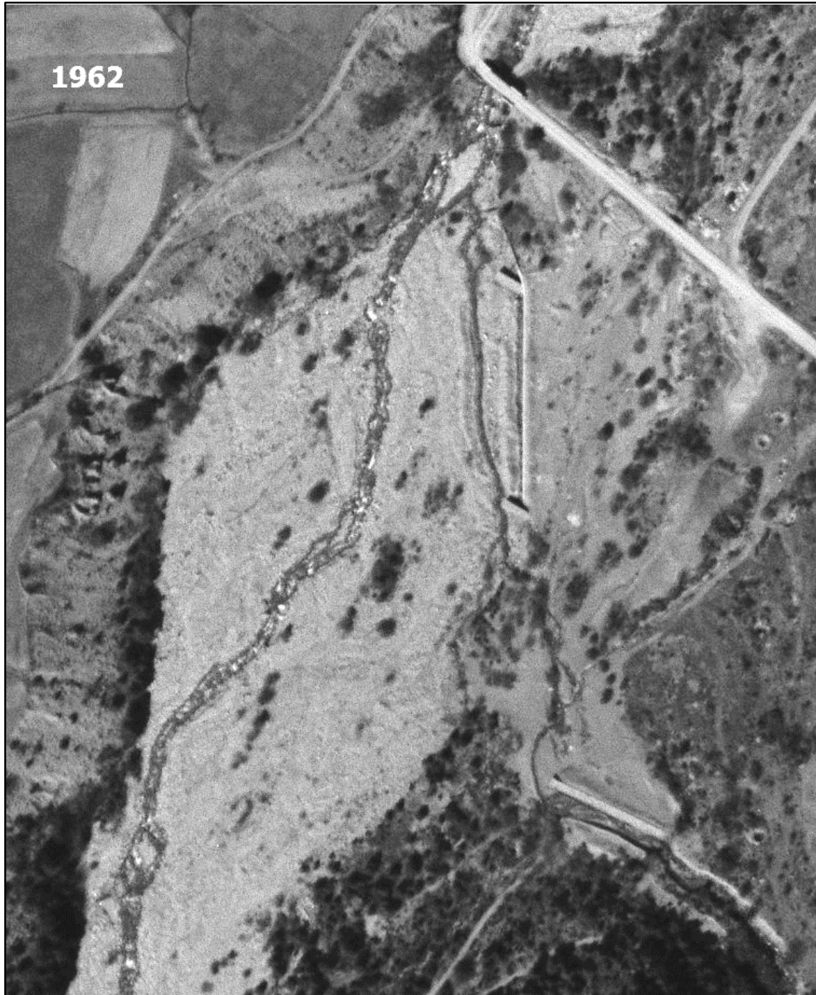
Image 7 : ouvrages de protection
