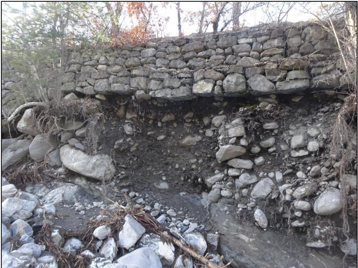
Image 20 : le gabion en question
