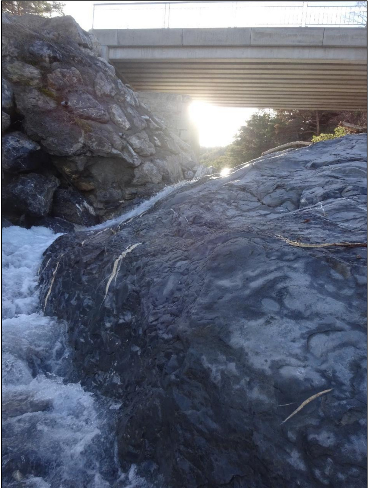
Image 21 : arrivée sous le pont
