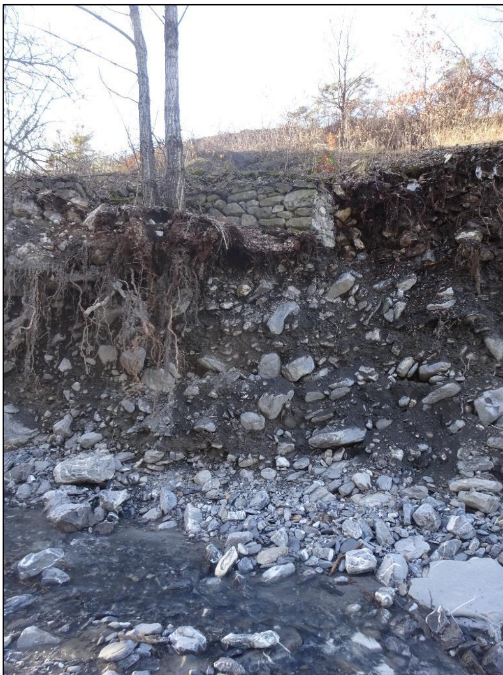
Image 19 : un gabion en hauteur
