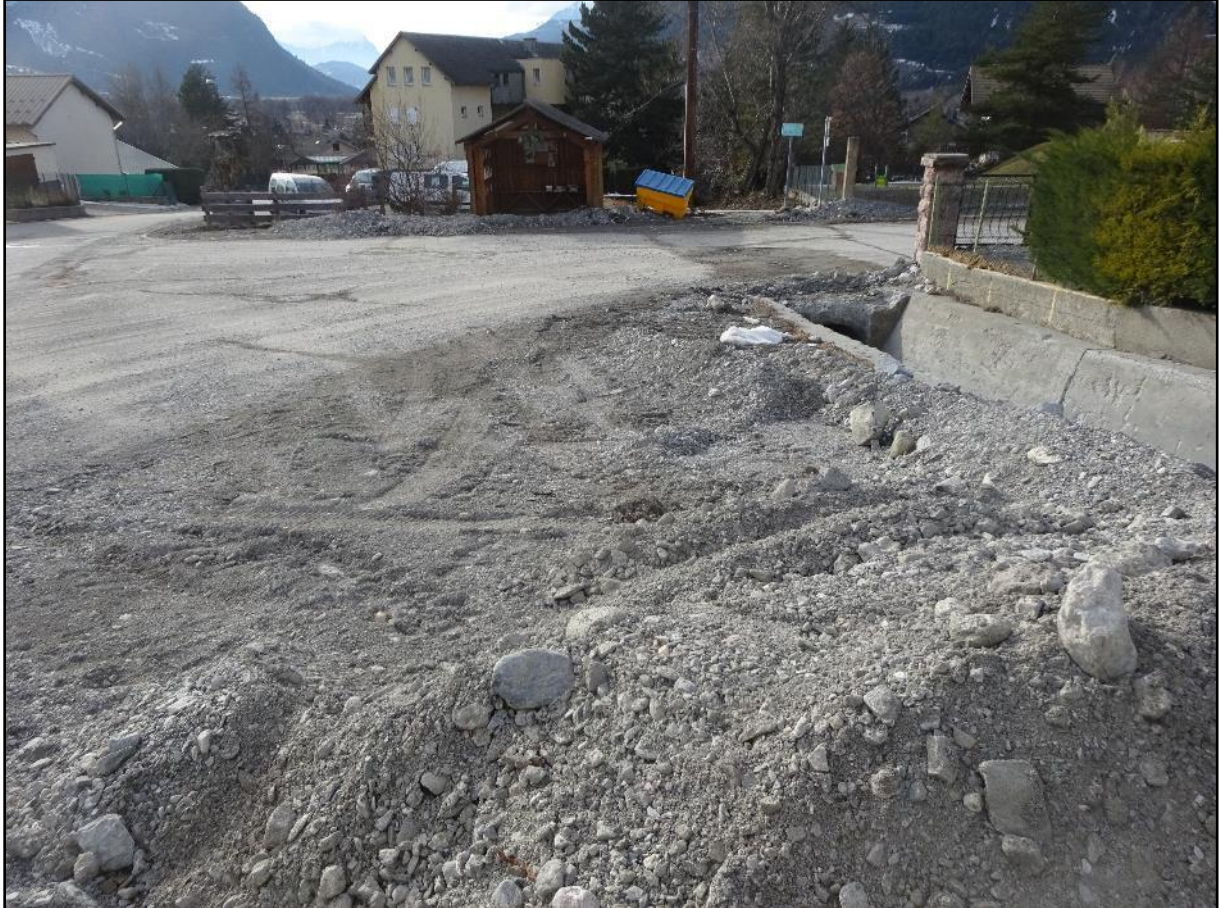
Image 8 : une buse sous-dimensionnée
