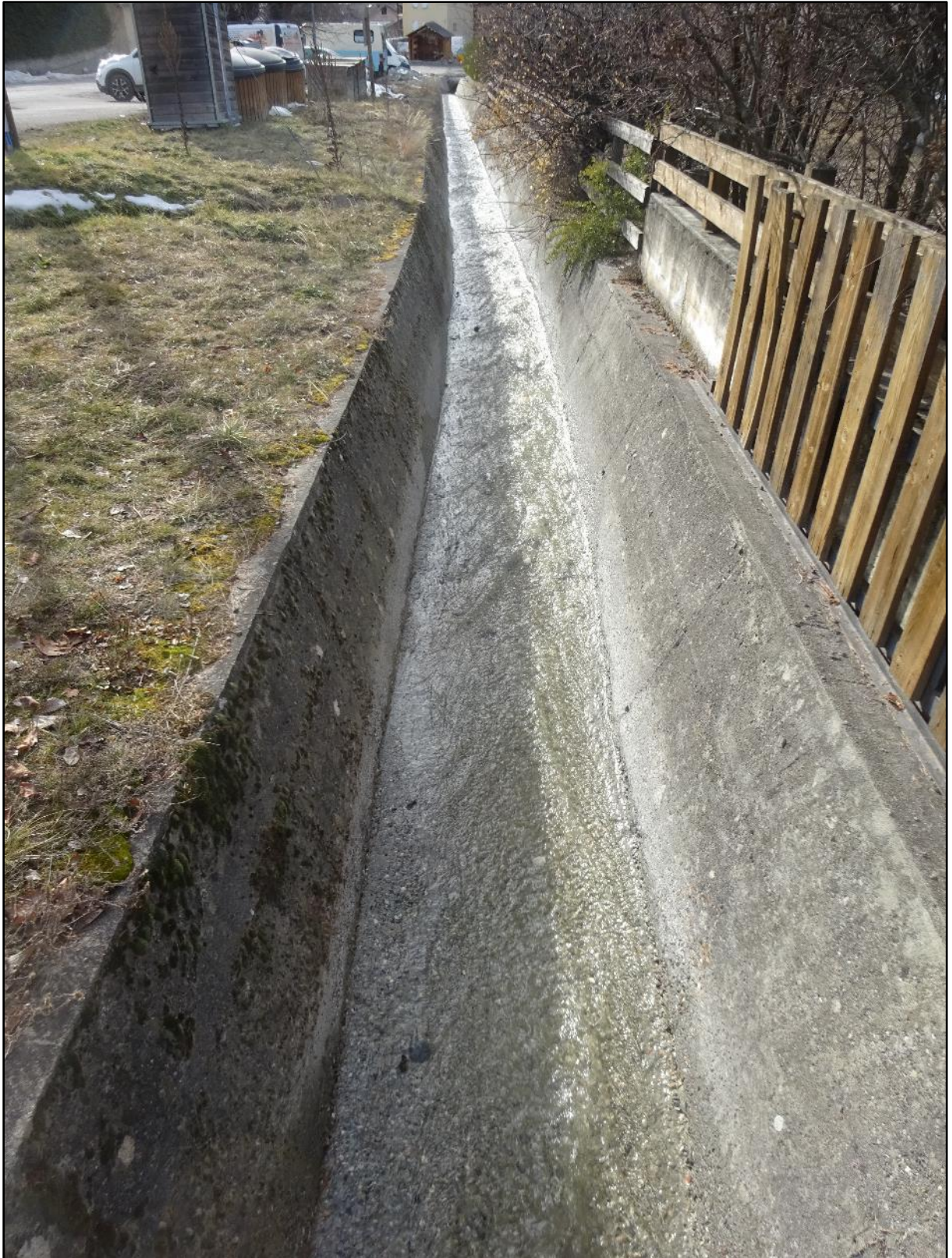
Image 7 : une section bétonnée
