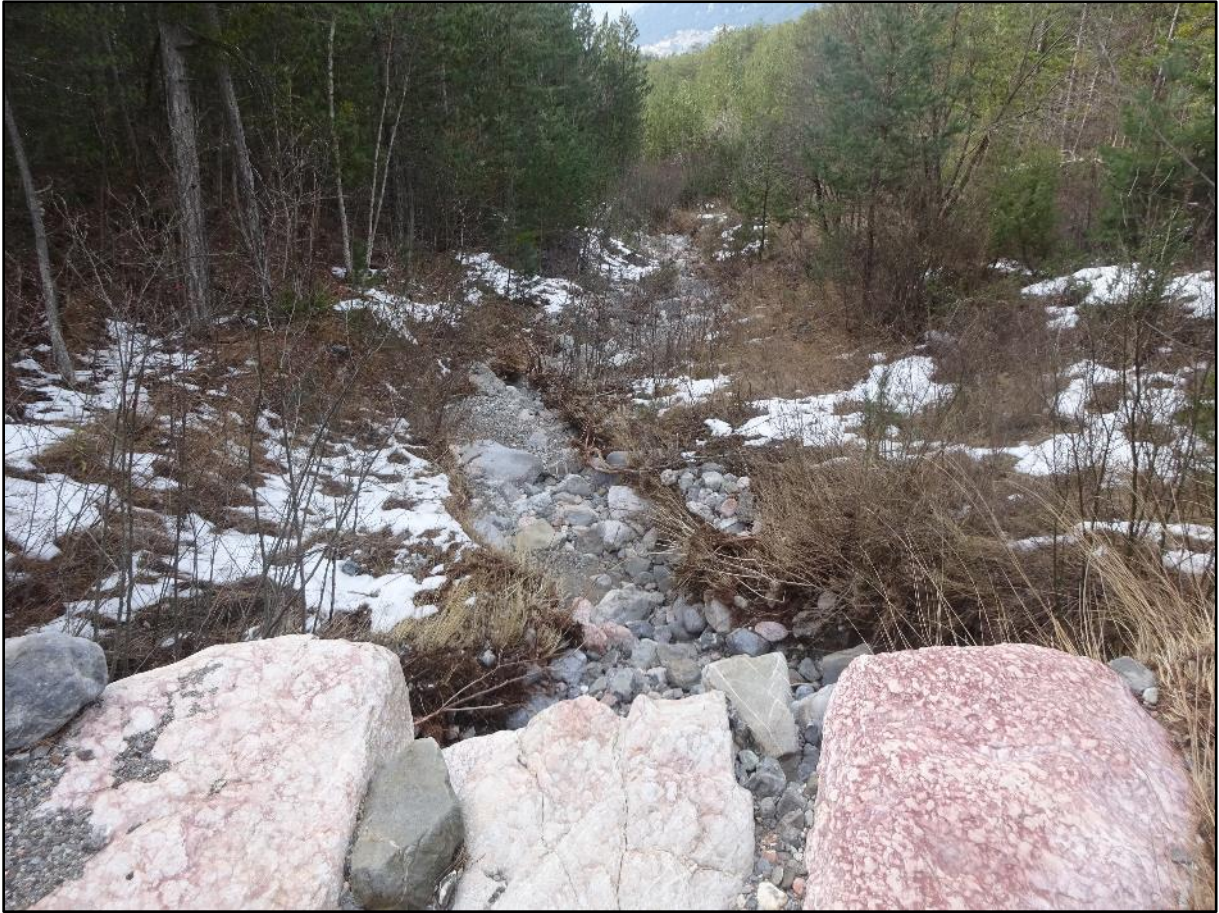
Image 7 : le vieux seuil vu de dessus
