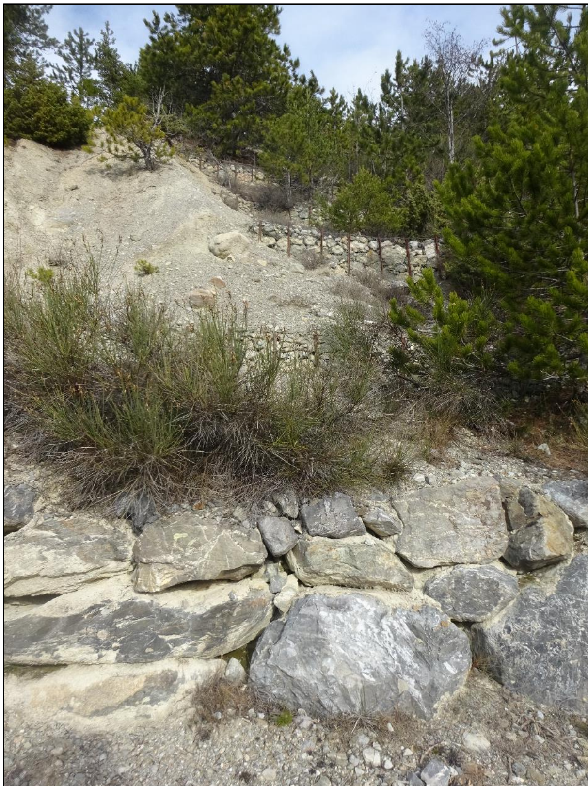
Image 17 : lutte contre l'érosion
