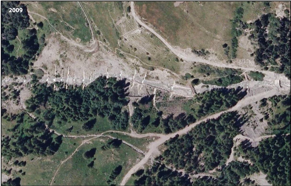
Image 6 : en aval du pont de la Salce (2009)
