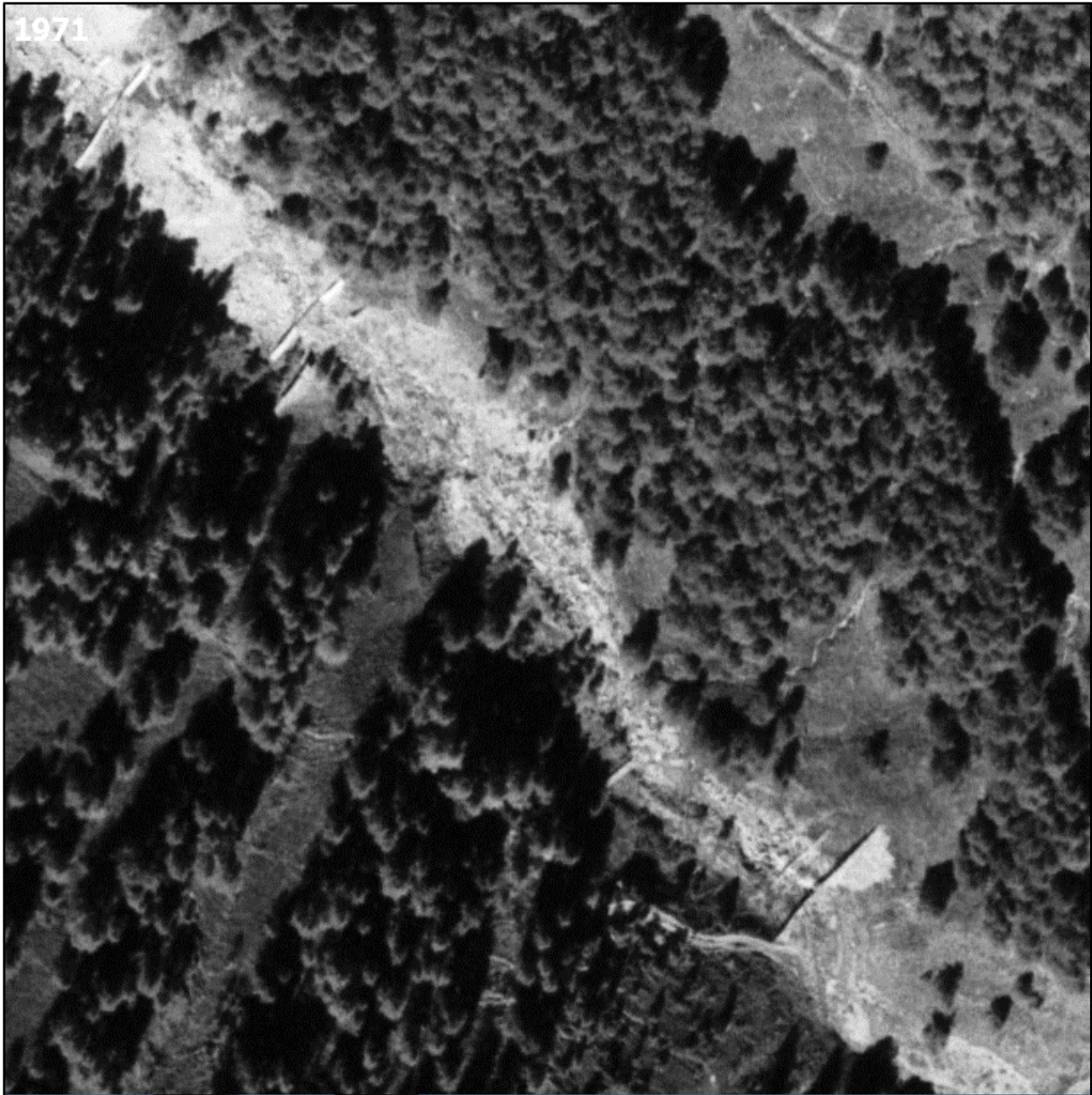
Image 12 : le Chagnon dans sa partie supérieure (1971)
