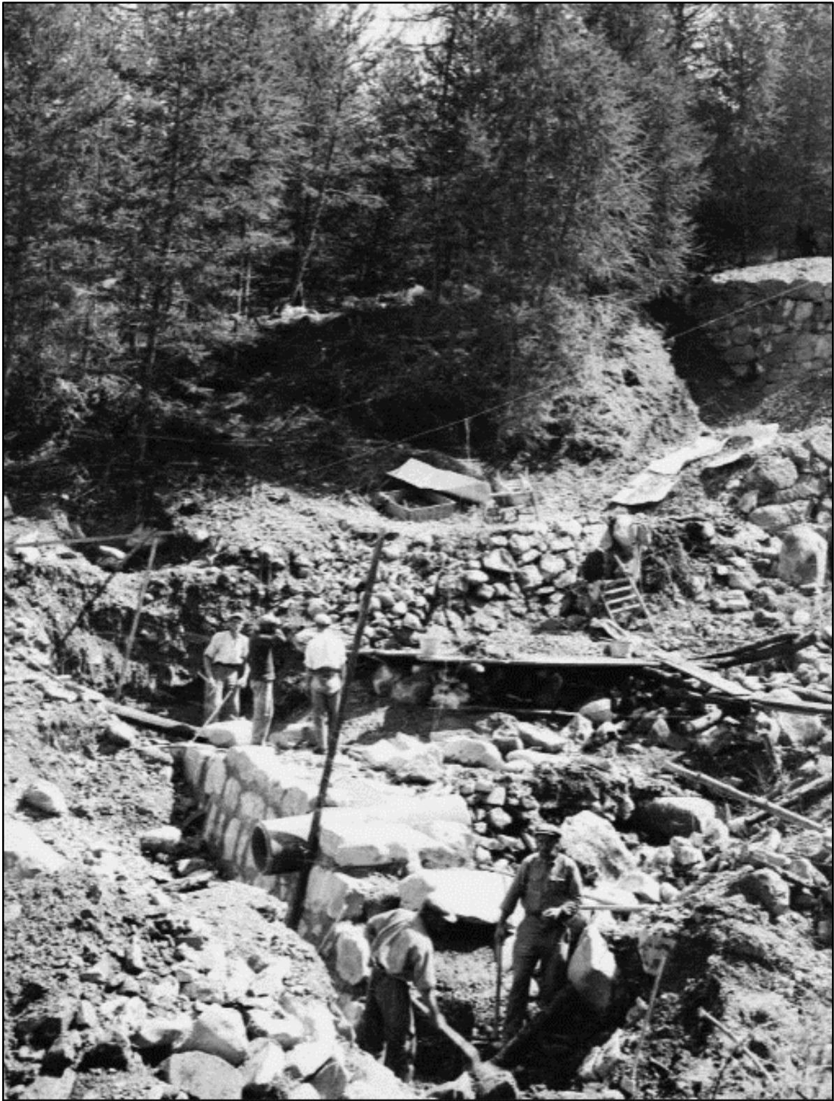
Image 10 : « Torrent du Chagnon, construction du contre-barrage n°29 »
