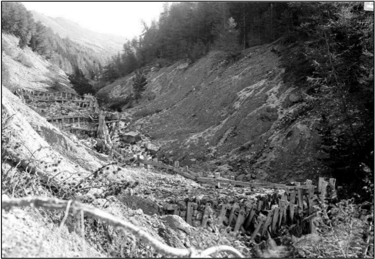
Image 6 : « Torrent du Chagnon, anciens ouvrages en bois construits en 1910/11 »
