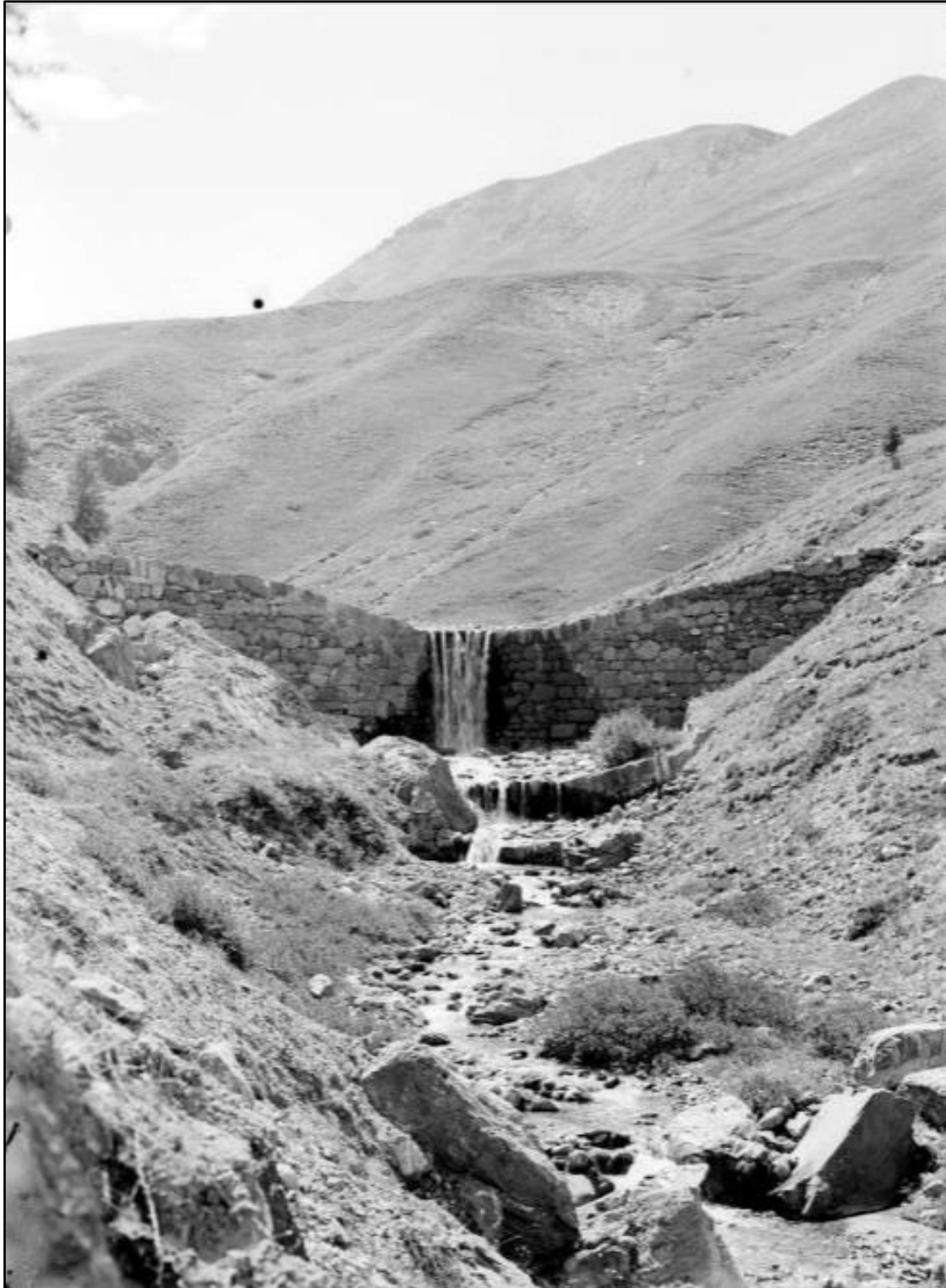
Image 3 : « Torrent du Chagnon - barrage »
