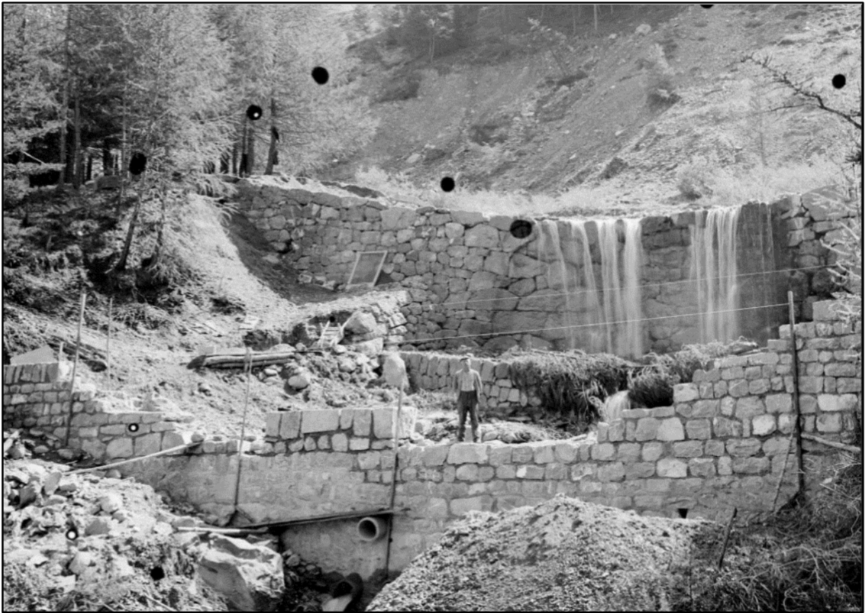
Image 14 : « Torrent du Chagnon, construction du contre-barrage n°29 »
