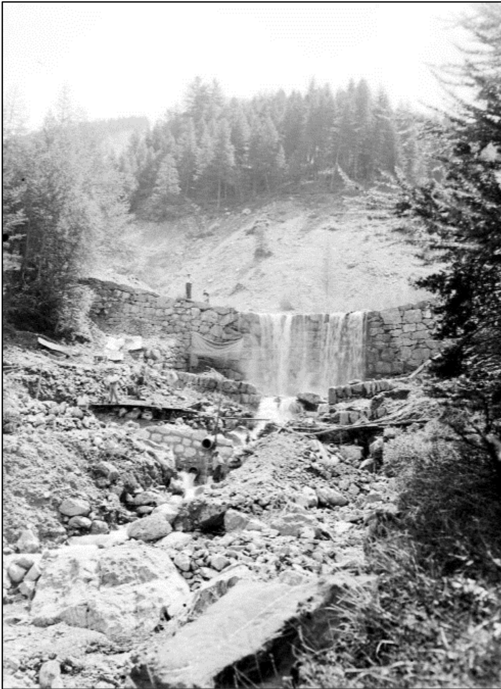
Image 9 : « Torrent du Chagnon, construction du contre-barrage n°29 »
