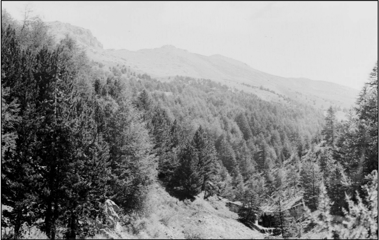
Image 2 : « Torrent du Chagnon - barrages »
