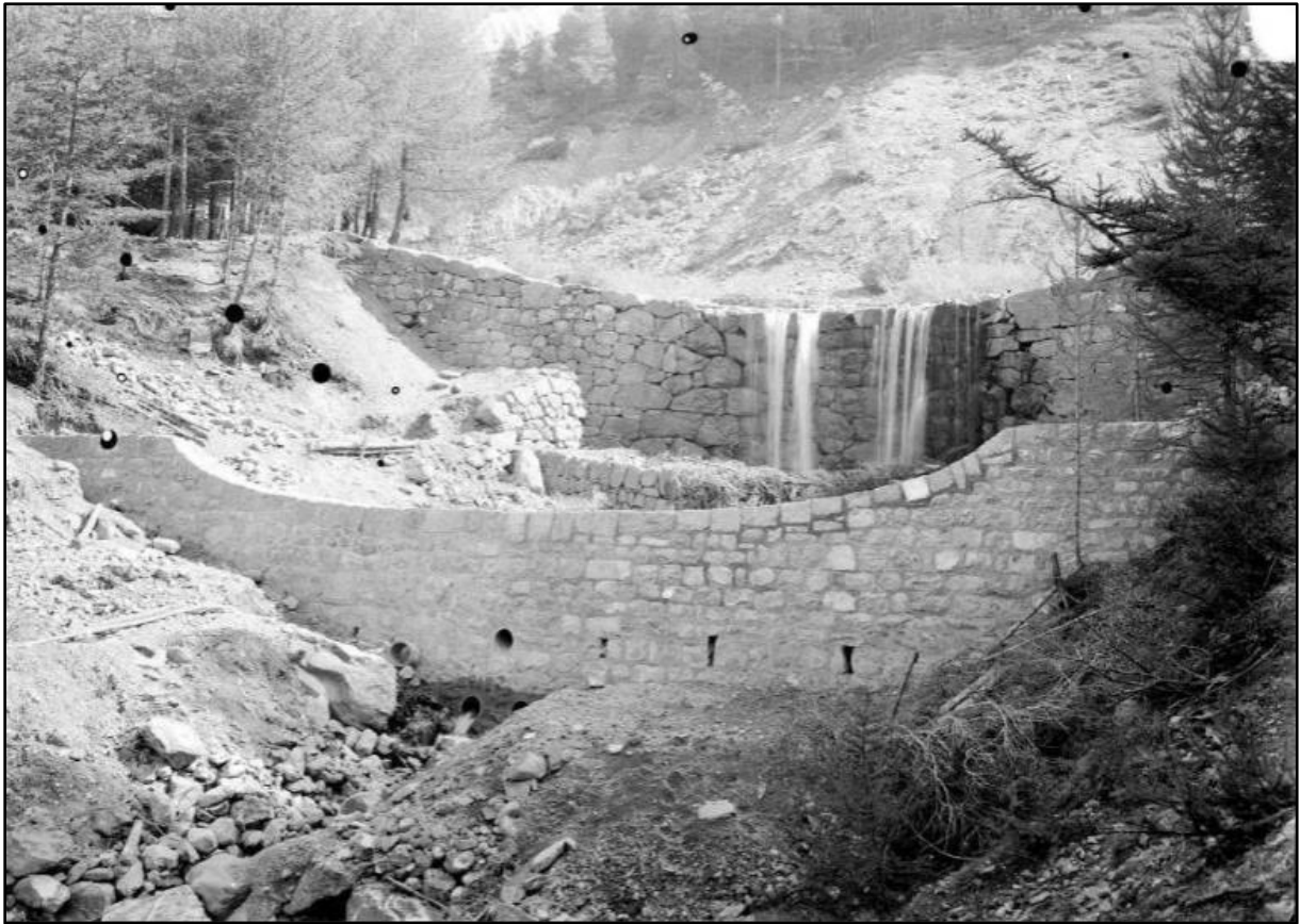
Image 16 : « Achèvement de la construction du contre-barrage n°29 »
