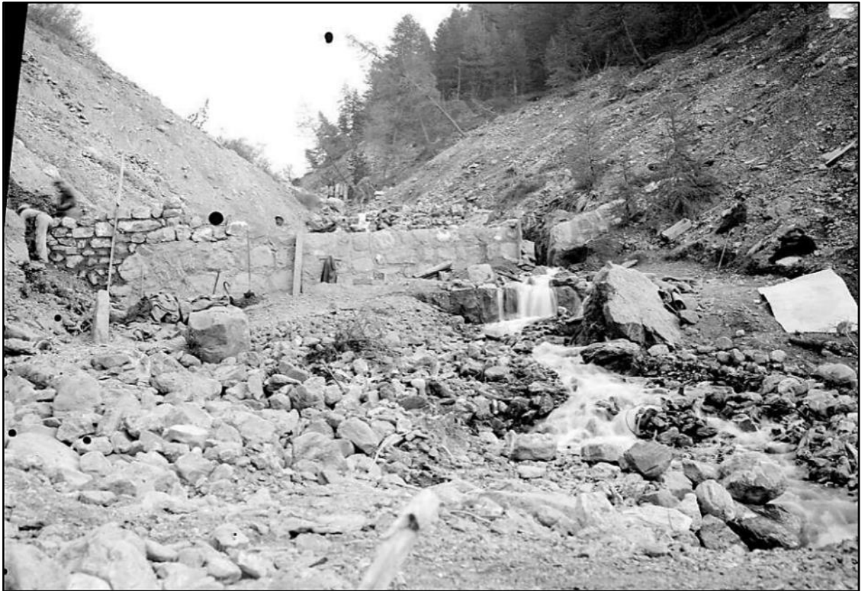
Image 7 : « Torrent du Chagnon, seuil en reconstruction »
