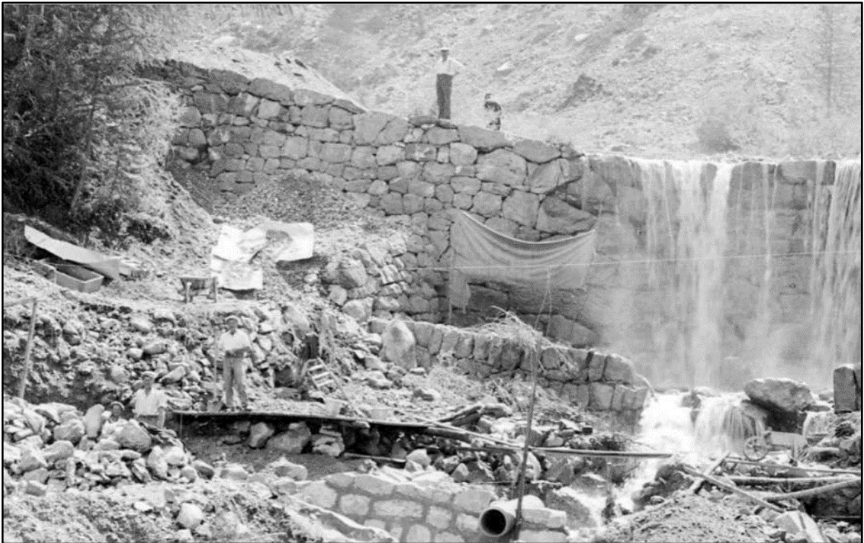
Image 13 : « Torrent du Chagnon, construction du contre-barrage n°29 »
