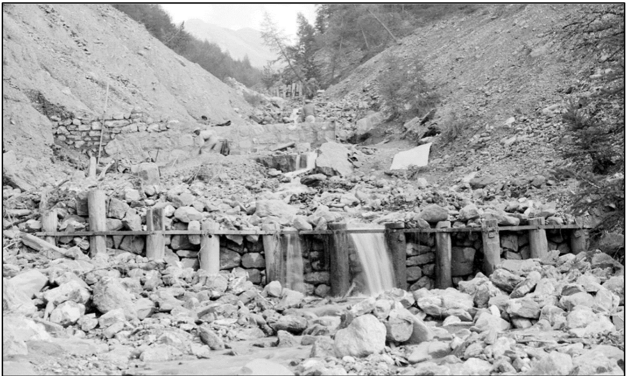
Image 8 : « Torrent du Chagnon, seuil en reconstruction, ouvrages bois et pierres »
