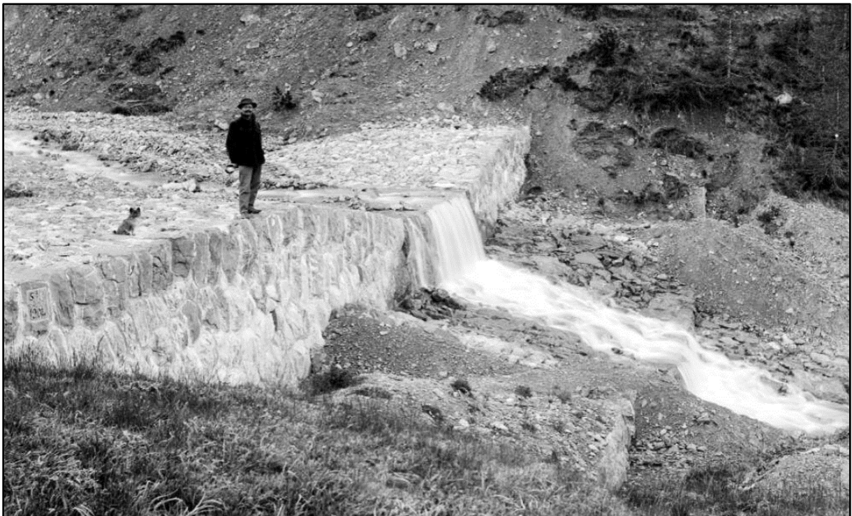
Image 16 : « le barrage n°5/1 construit en 1904 »
