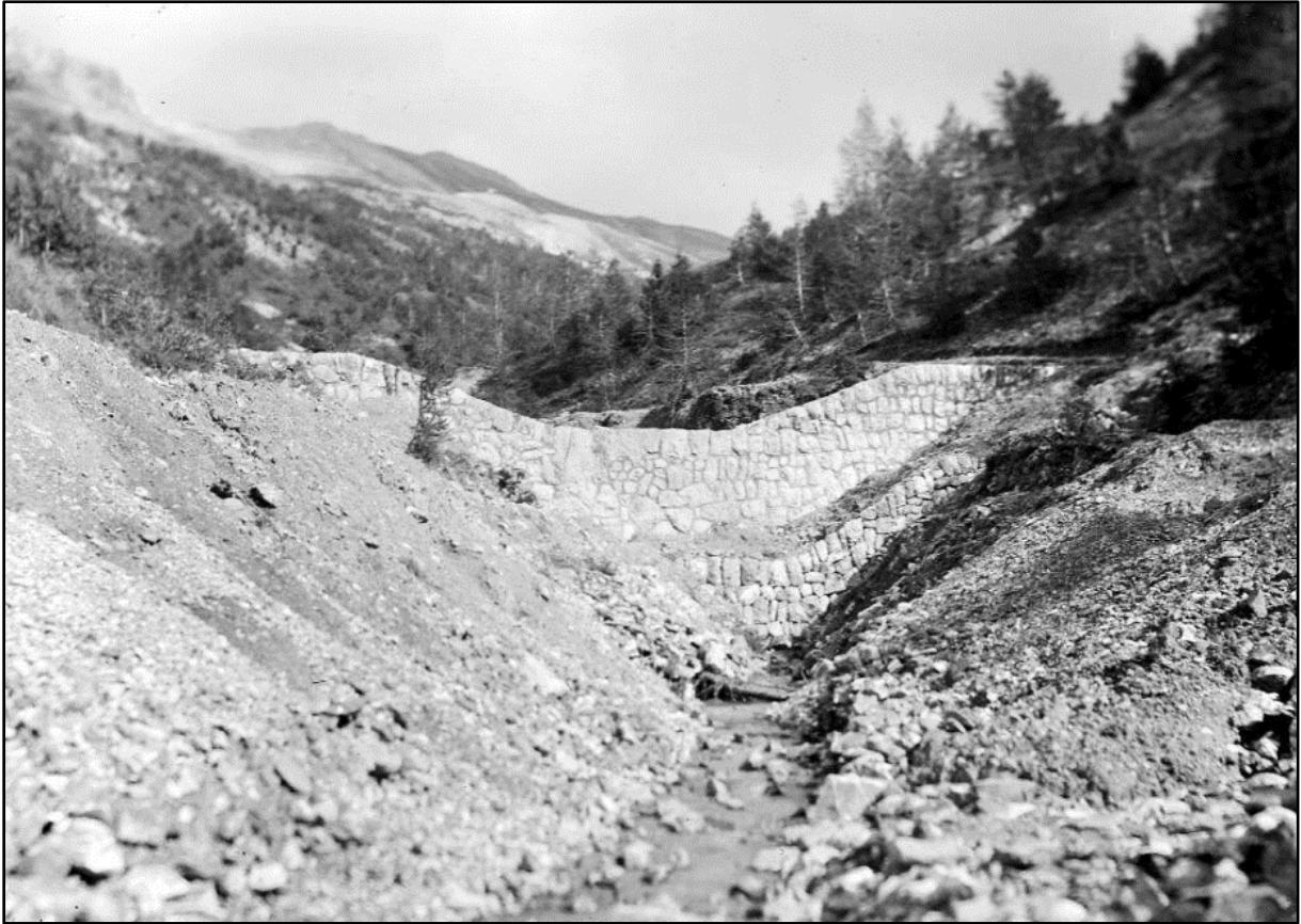
Image 4 : « Barrage 8/2 et son contre barrage (1901) »
