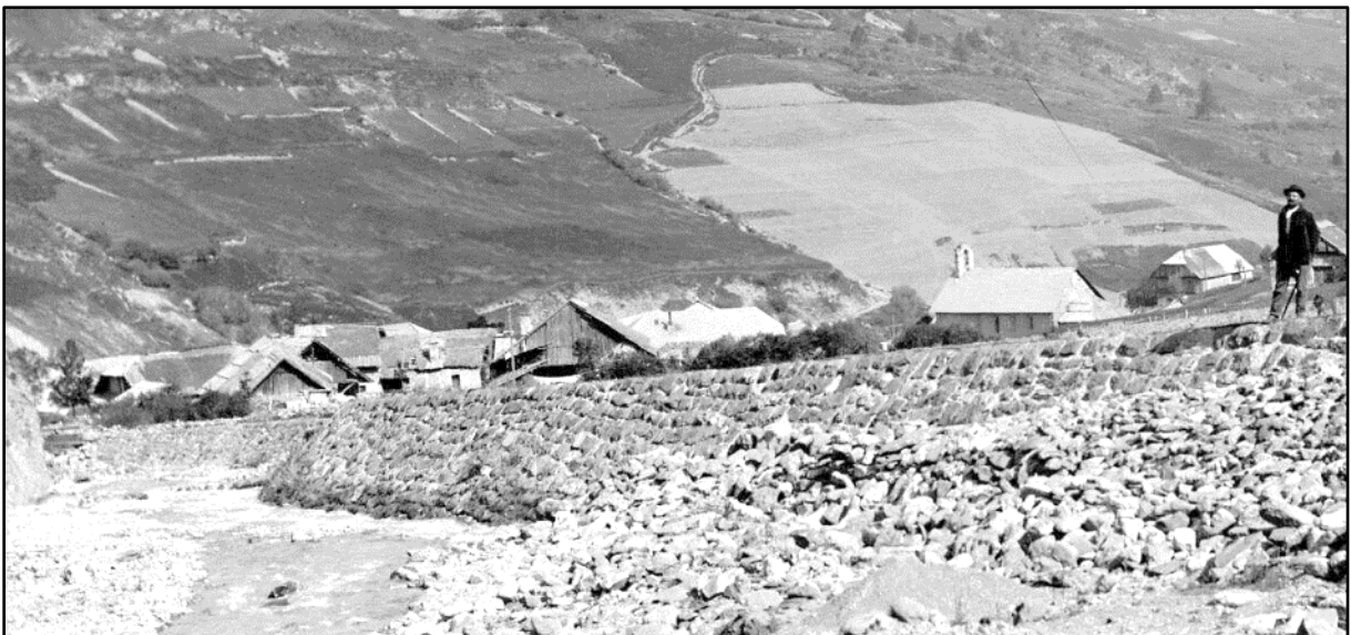
Image 23 : la digue protectrice
