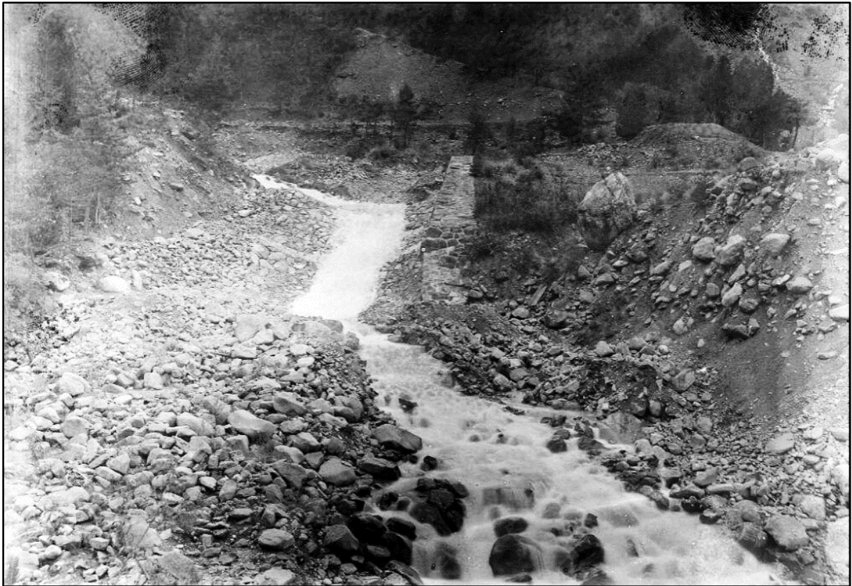
Image 23 : « Radier de glissement le long de la première digue de dérivation construit en 1923/24 »
