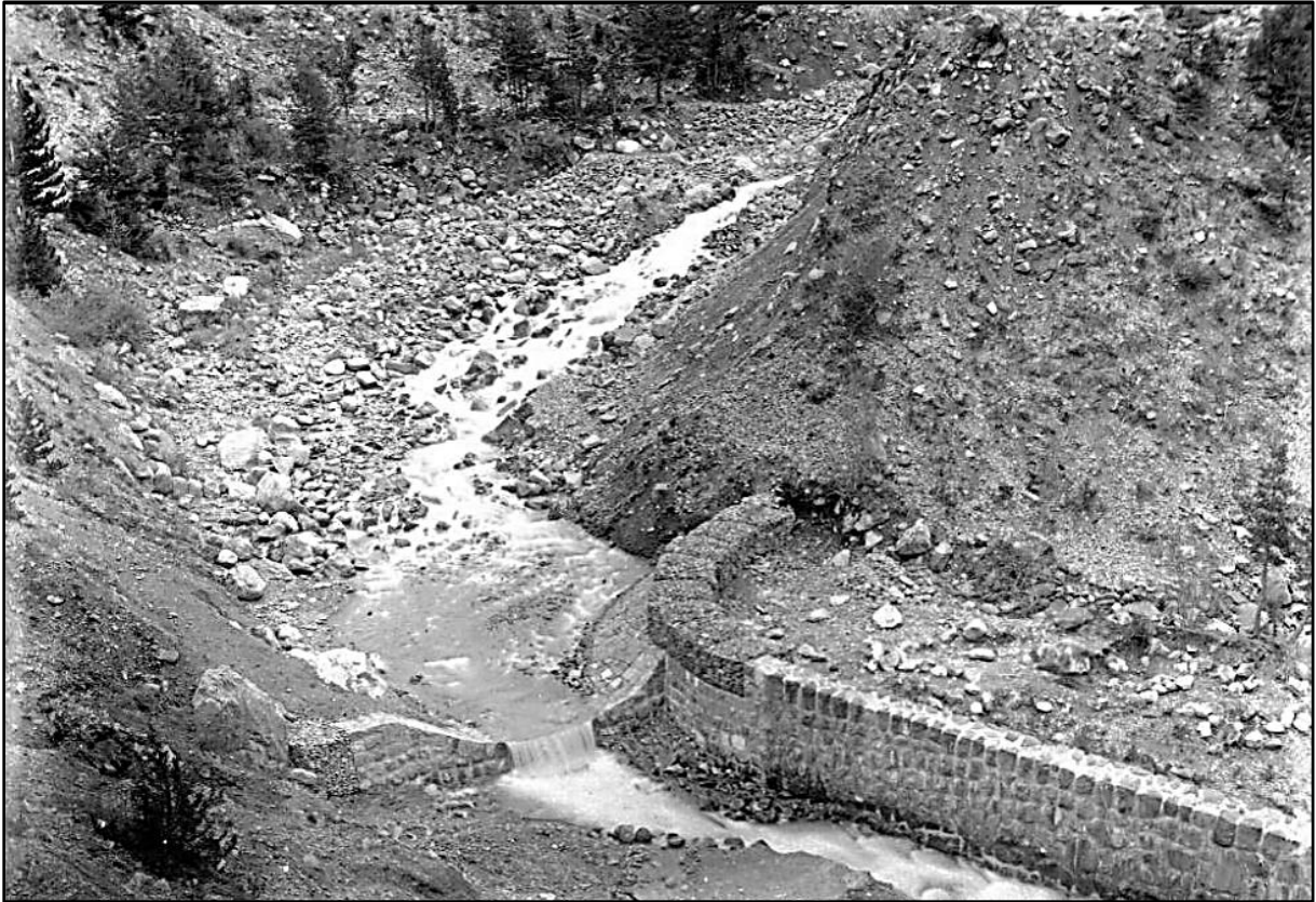
Vue vers l'amont. Après la mise en eau.
