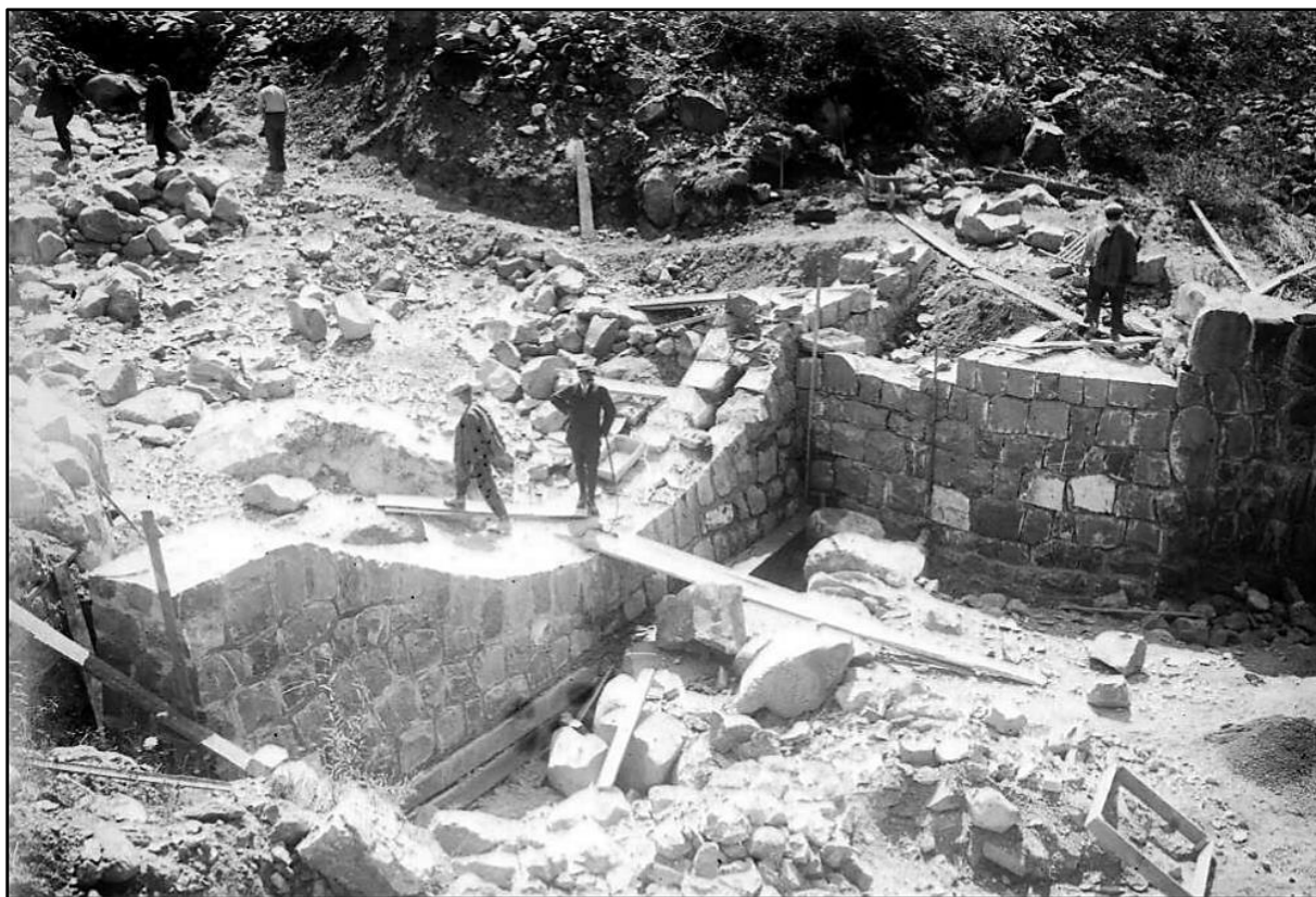
Image 16 : « Construction d'un barrage à l'amont du tunnel de Panacelle »
