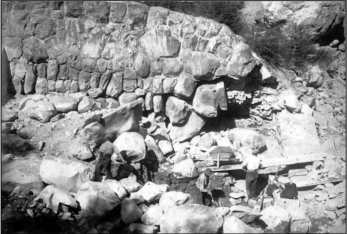
Image 8 : « Réfection de la digue supérieure à Panacelle »
