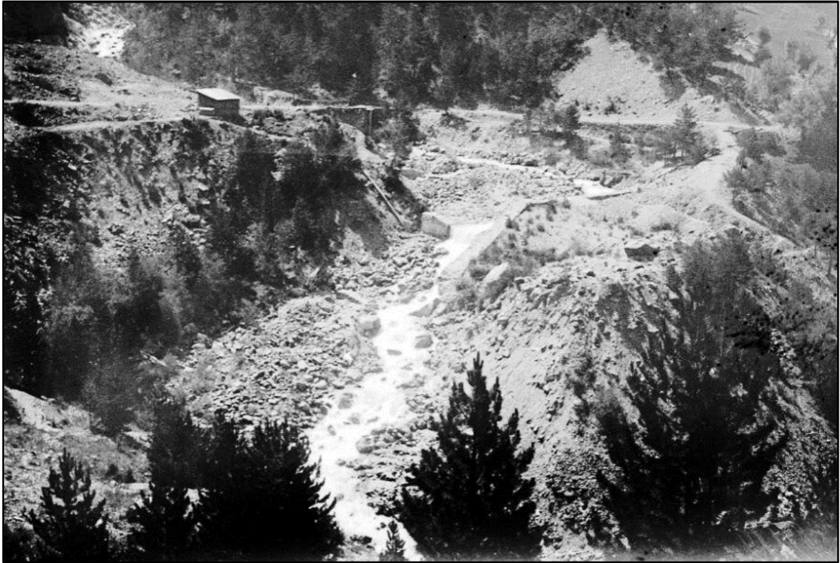
Vue rapprochée. La cabane de chantier et le torrent avant le début des travaux.
