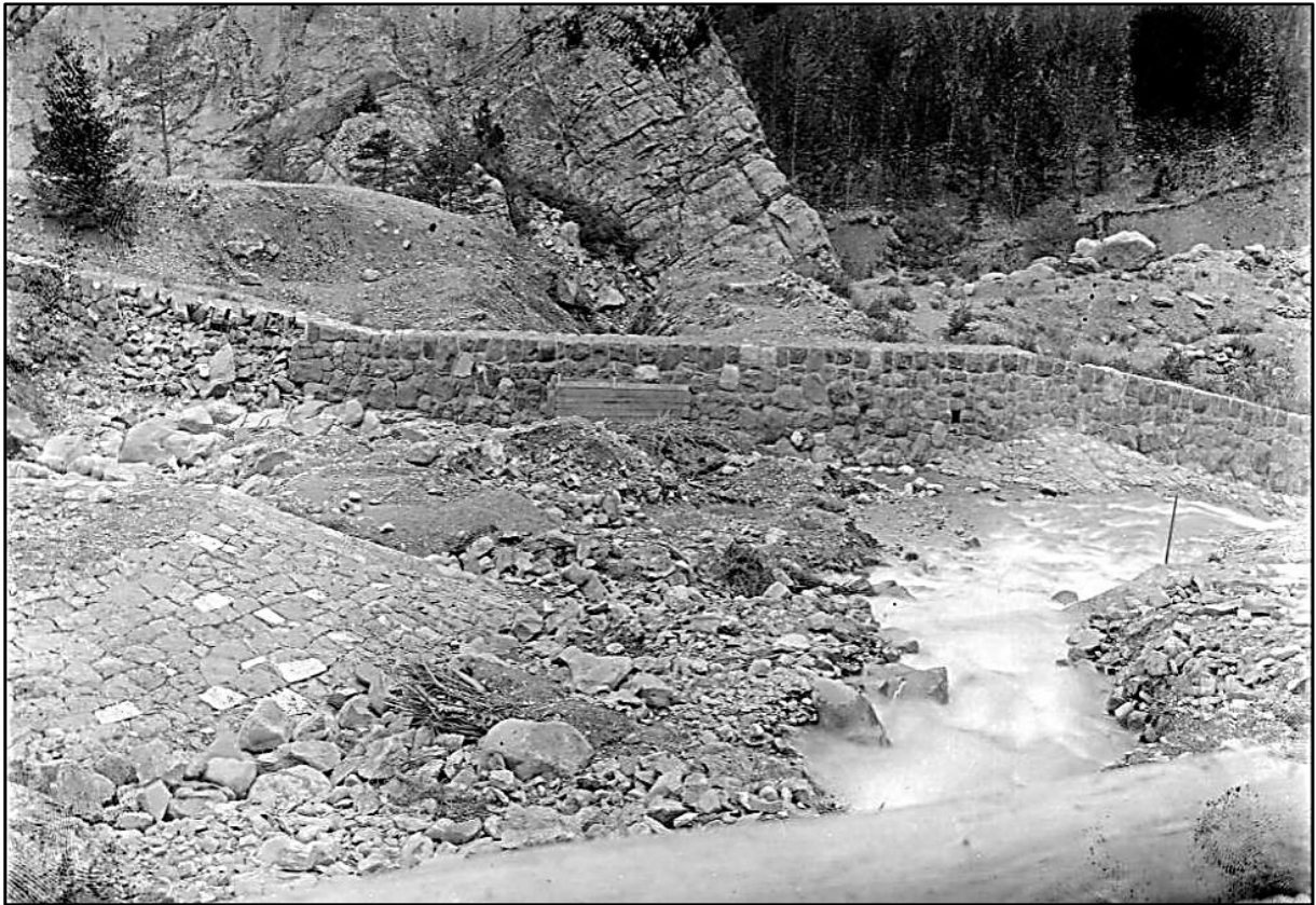
Image 22 : « Barrage en face du premier barrage de dérivation -1/4 de cône sur l'aile rive gauche »
