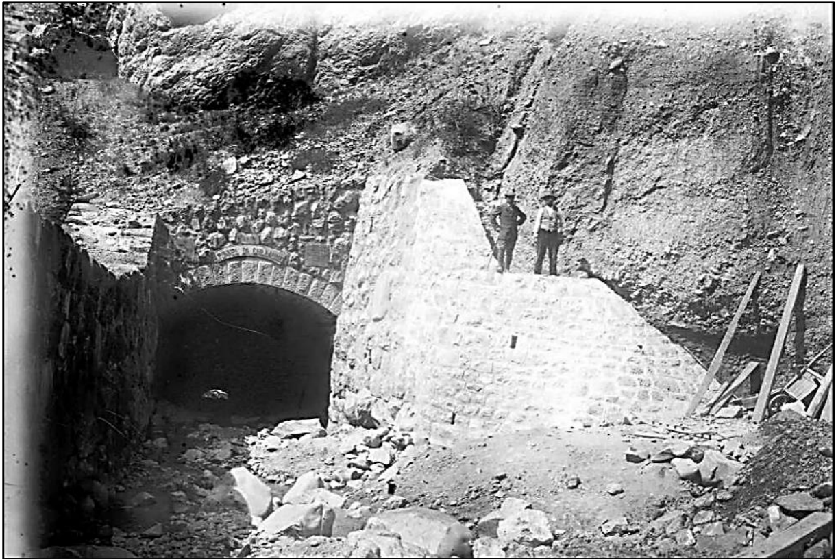
Image 17 : « Entrée du tunnel de Panacelle »
