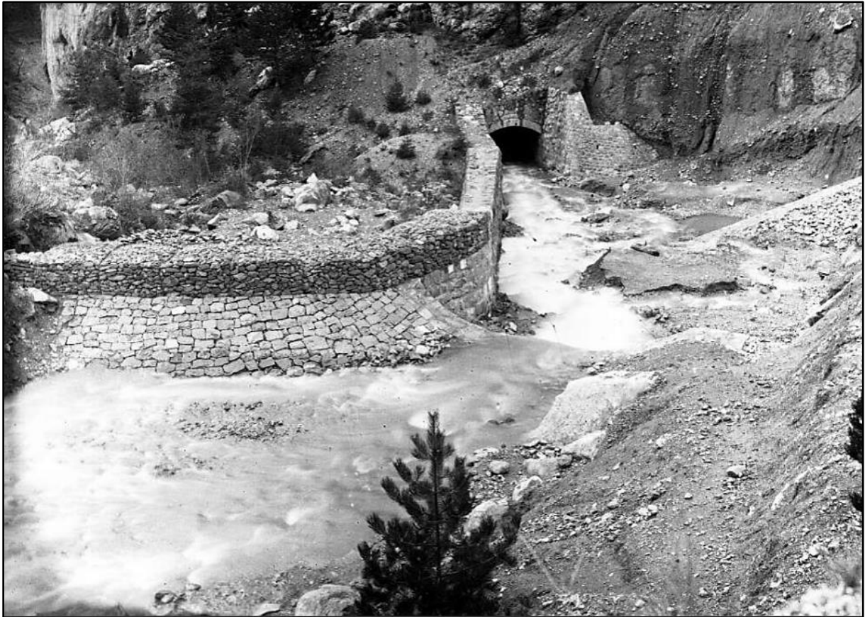
Image 25 : « Entrée du tunnel -Tête réparée de la deuxième digue de dérivation - Barrage en l'emplacement d'un ancien barrage naturel de gros blocs - Revêtement conique et gabions sur l'aile rive gauche -Un épi »
