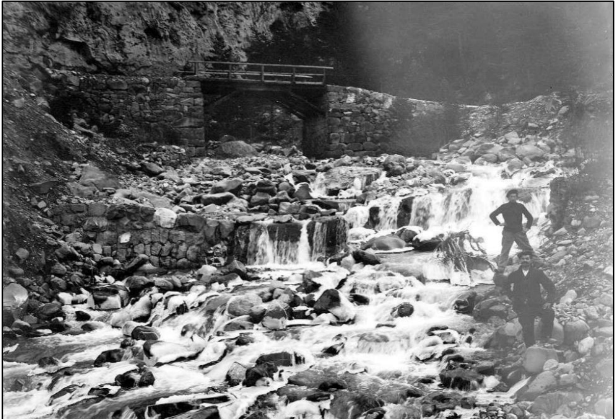
Image 3 : « Seuil n°4 démoli à la sortie du pont de Panacelle »
