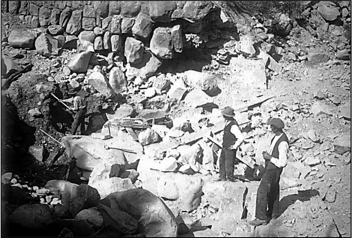
Image 7 : « Réfection de la digue supérieure à Panacelle »
