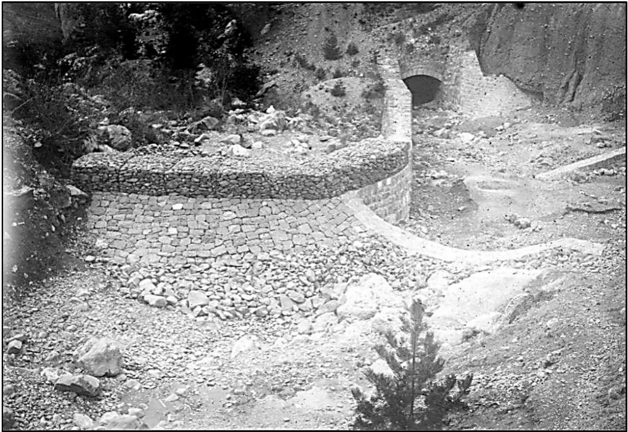
Image 18 : « Protection en maçonnerie et gabion à l'entrée du tunnel de Panacelle »
