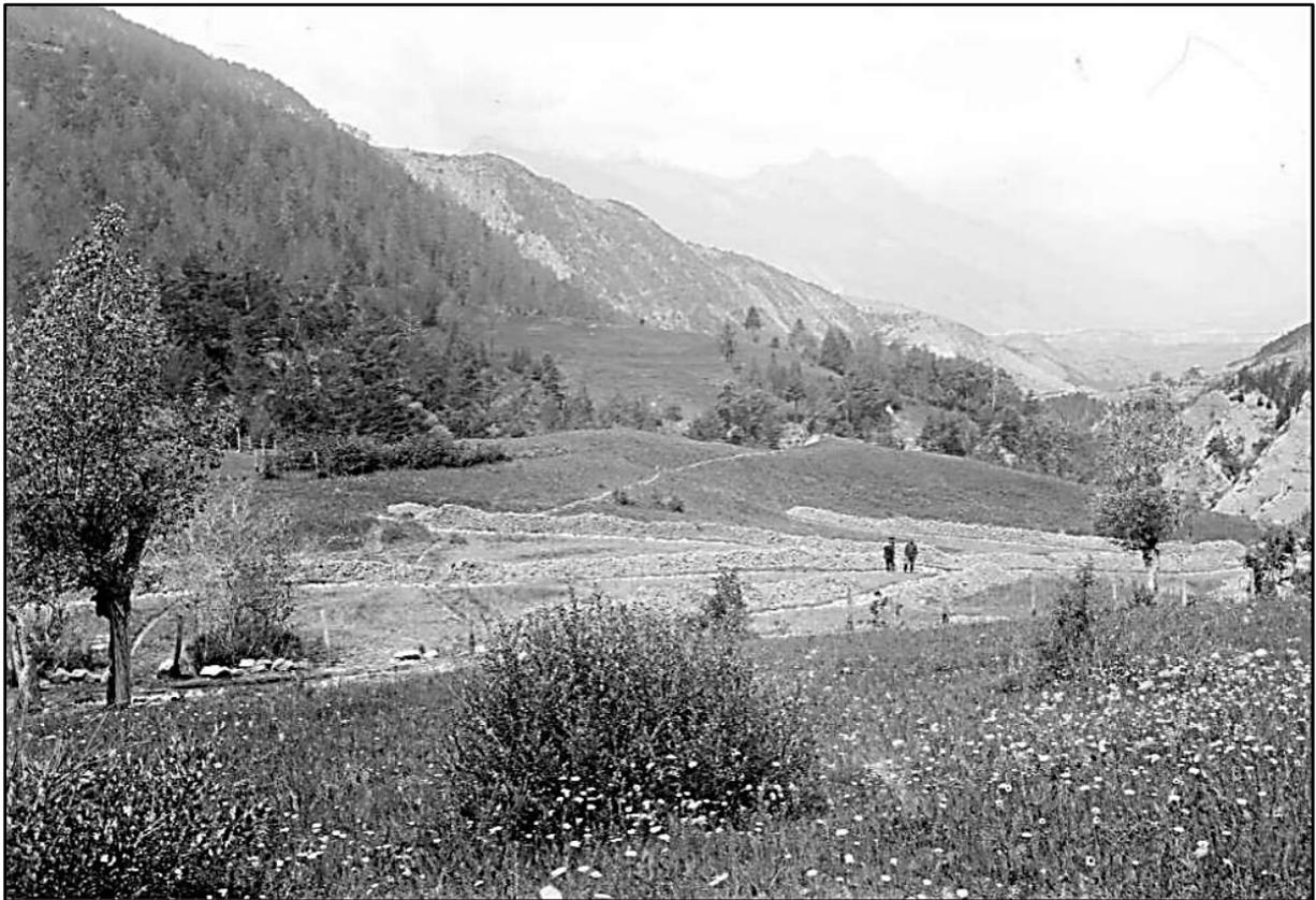
Belles tranchées creusées sur des dizaines et des dizaines de mètres tout à la main dans une prairie fleurie. On met des pierres puis on referme. Trop d'eau c'est un terrain instable qui tôt ou tard partira. Ce sont des travaux connexes, une fois le gros du chantier réalisé. Vue sur la rive gauche du Chagne voire la vallée de la Durance.
