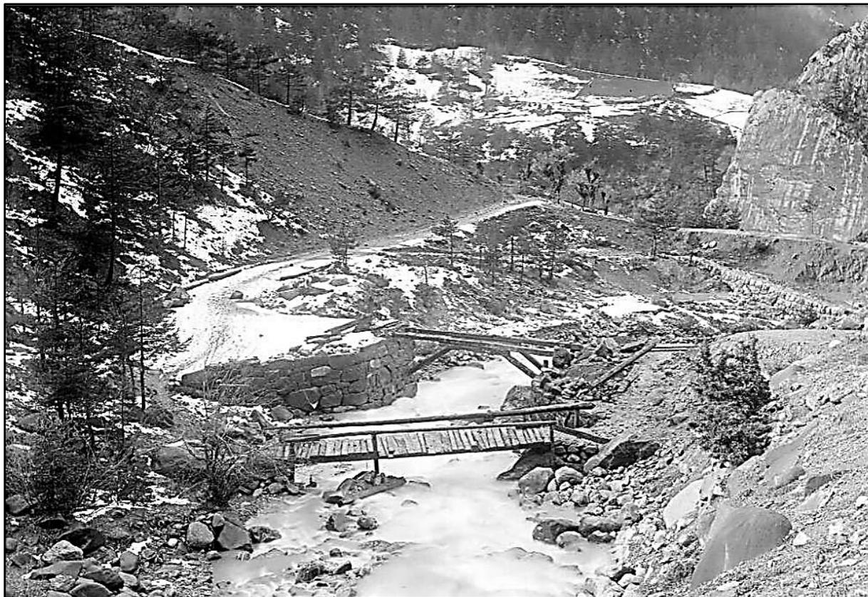
Les massifs supportant le tablier du pont, les culées, sont composés de très grosses pierres et ont bien résisté à la crue qui a emporté le tablier. Au premier plan, une passerelle provisoire a été établie un peu en amont.
