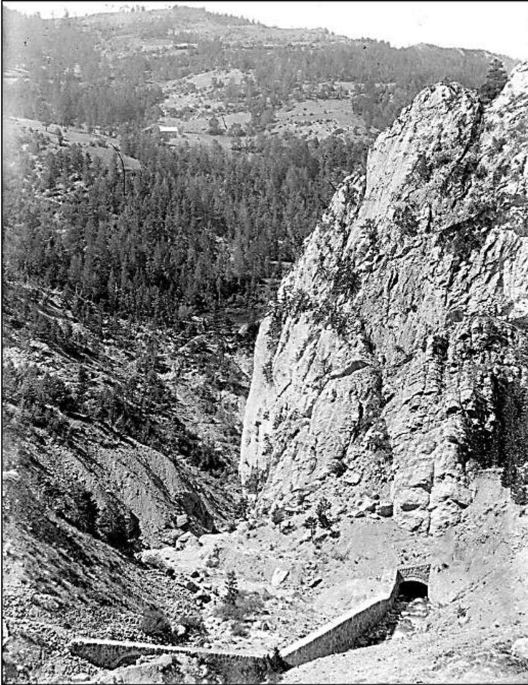
En haut, le vallon du Mélézet avec une grange, à droite le fameux rocher, en bas au centre l'ancien cheminement de l'eau et au premier plan la digue maçonnée conduisant au tunnel. On voit l'eau entrant dans le tunnel, cependant là-aussi la photo est datée de 1906, ce qui n'est pas possible. Approchons-nous.
