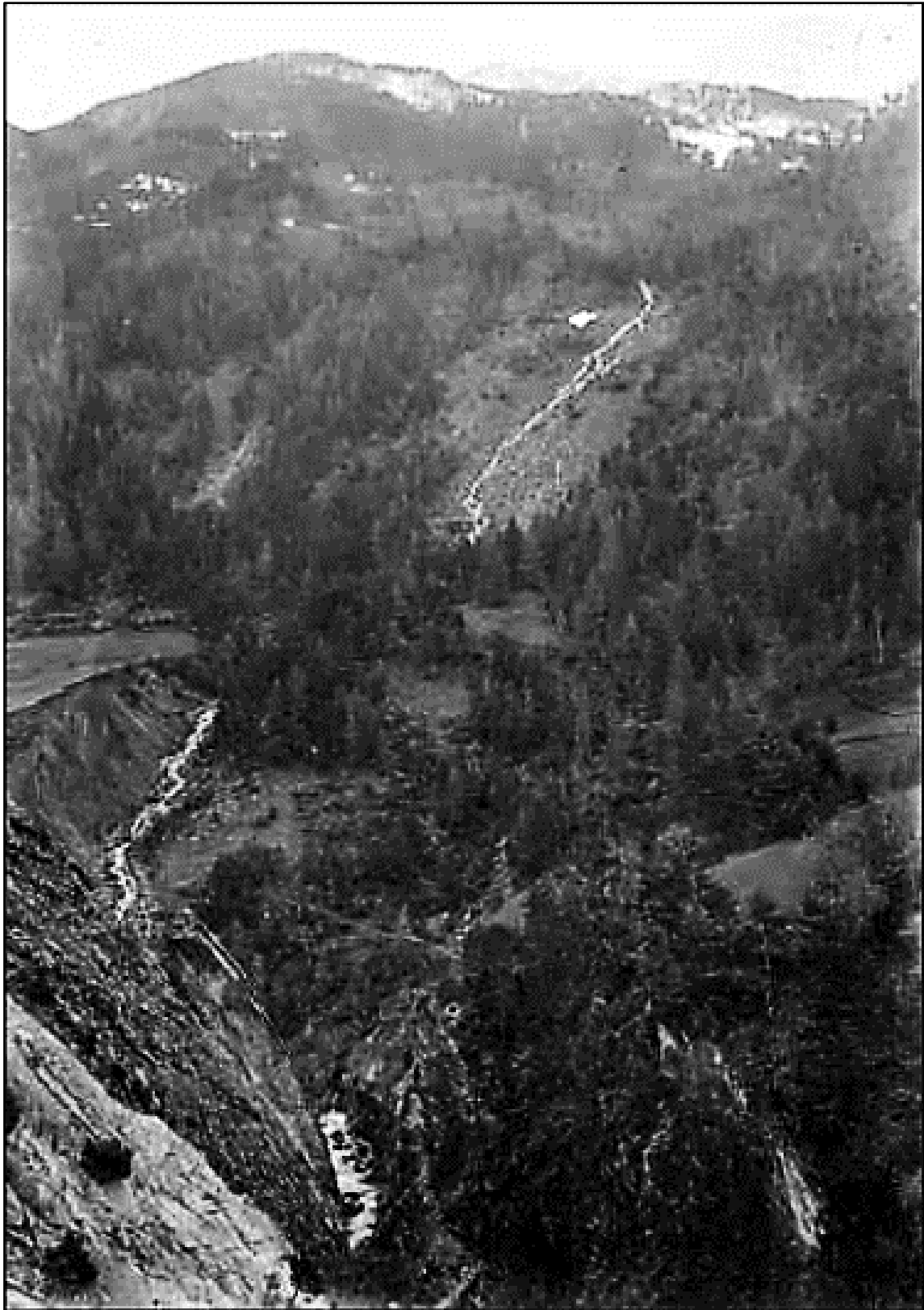
Image 7 : « Vue d'ensemble du ravin du Mélézet »
