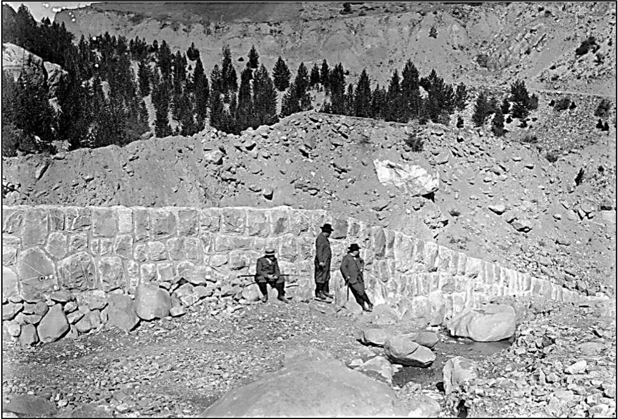
Image 12 : « Premier barrage de dérivation terminé »
