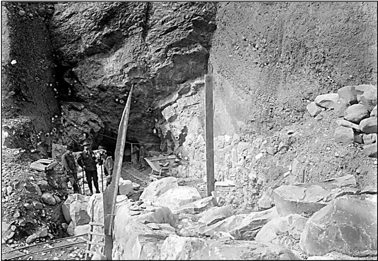
Image 15 : « Deuxième barrage de dérivation en construction, attaque du rocher à la tête amont »
