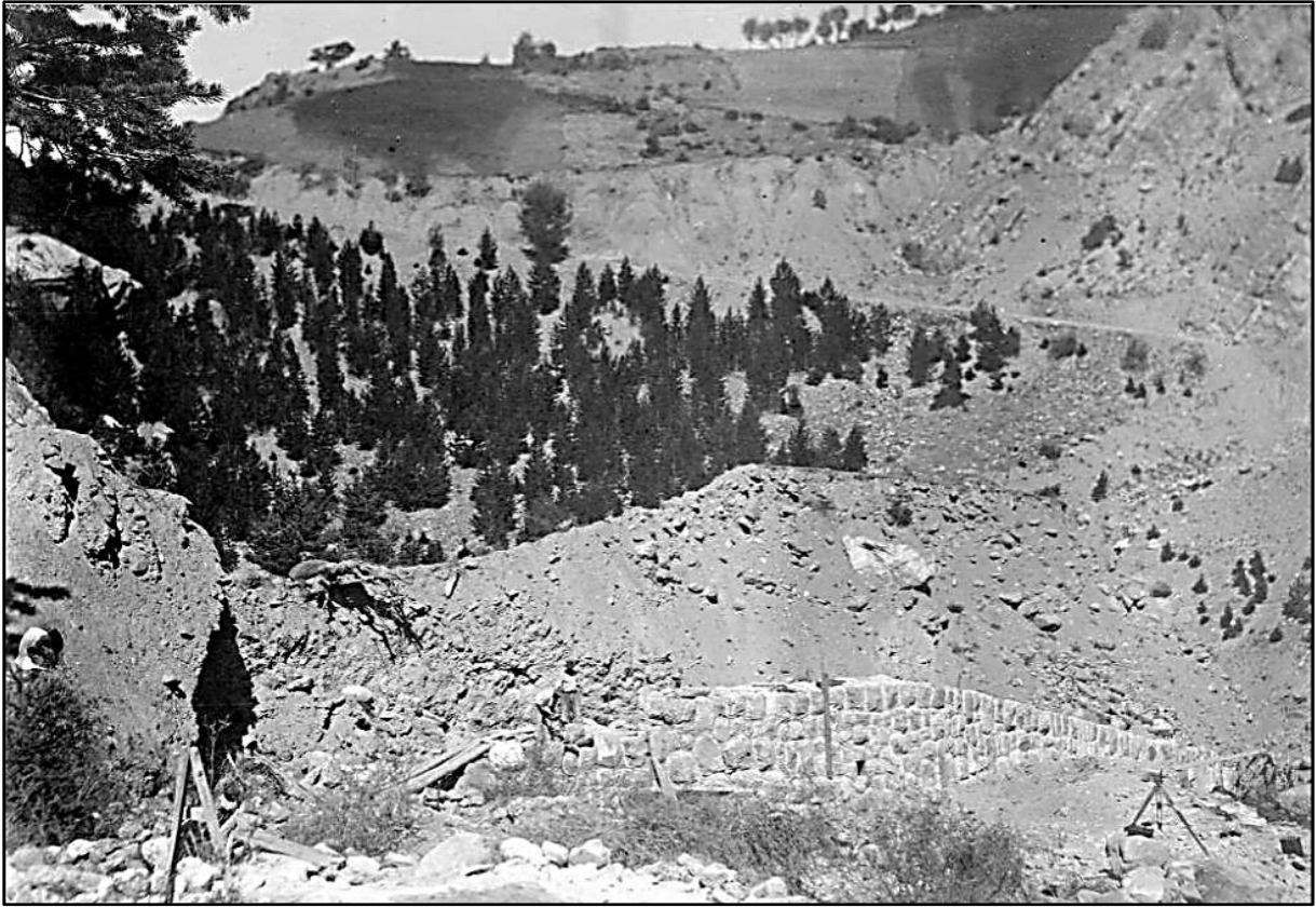
Image 10 : « Premier barrage en construction »
