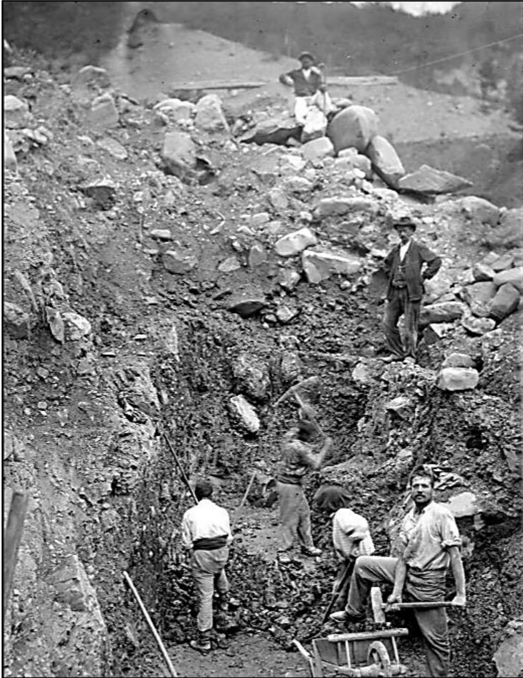
Image 8 : « Fouilles de la digue au 1 er barrage de dérivation »
