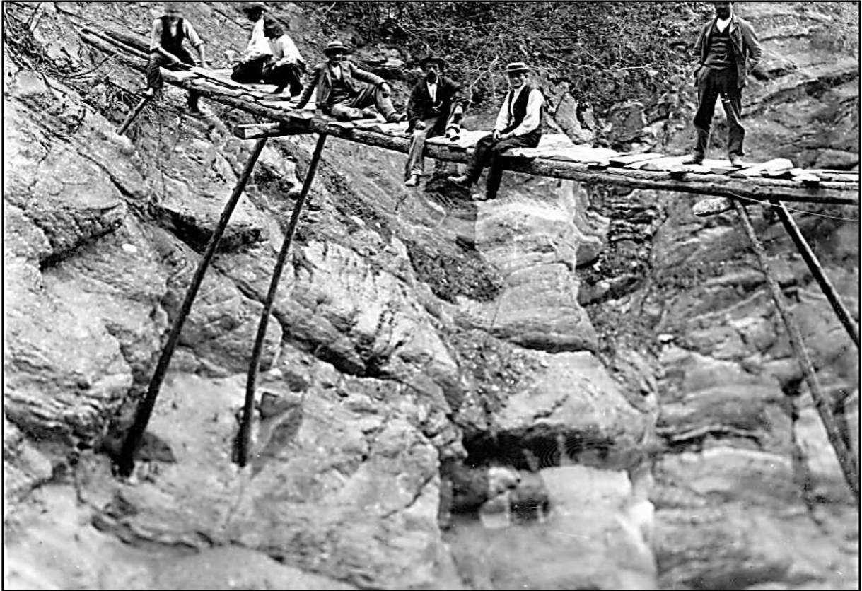
Image 19 : « La passerelle à l’orifice aval du tunnel de Panacelle »
