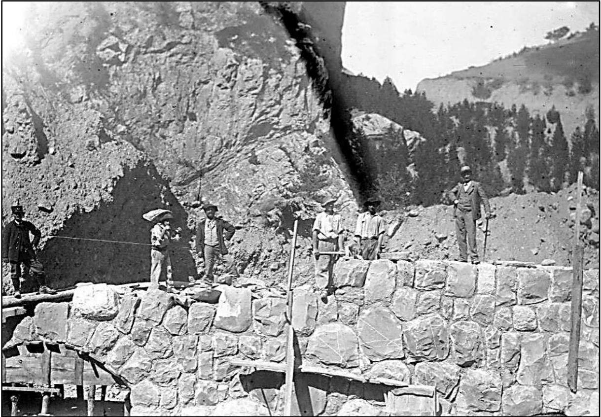
Image 11 : « Premier barrage de dérivation en construction »
