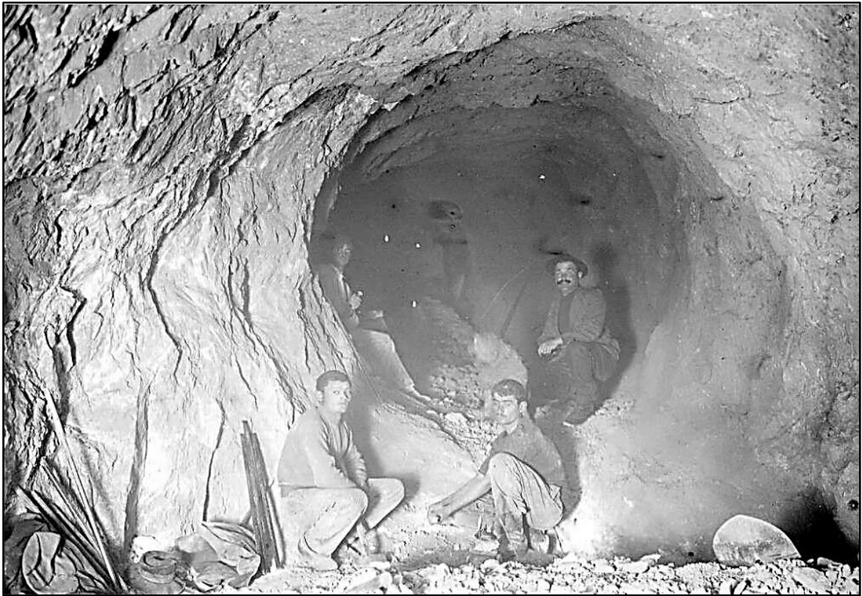
Image 16 : « Vue prise à l'intérieur du tunnel, galerie d'avancement »
