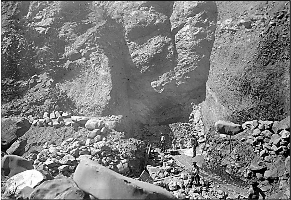
Image 14 : « Travaux à l'orifice amont du tunnel »
