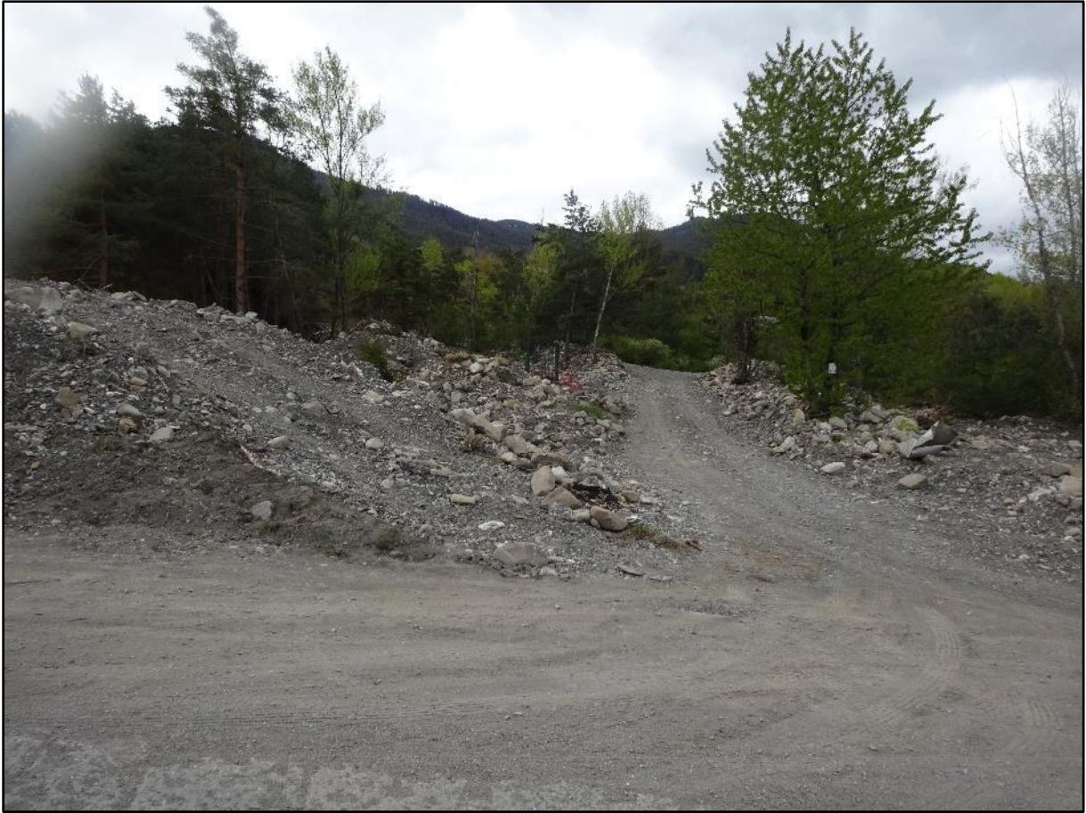
Image 7 : en amont de la route et rive gauche du torrent
