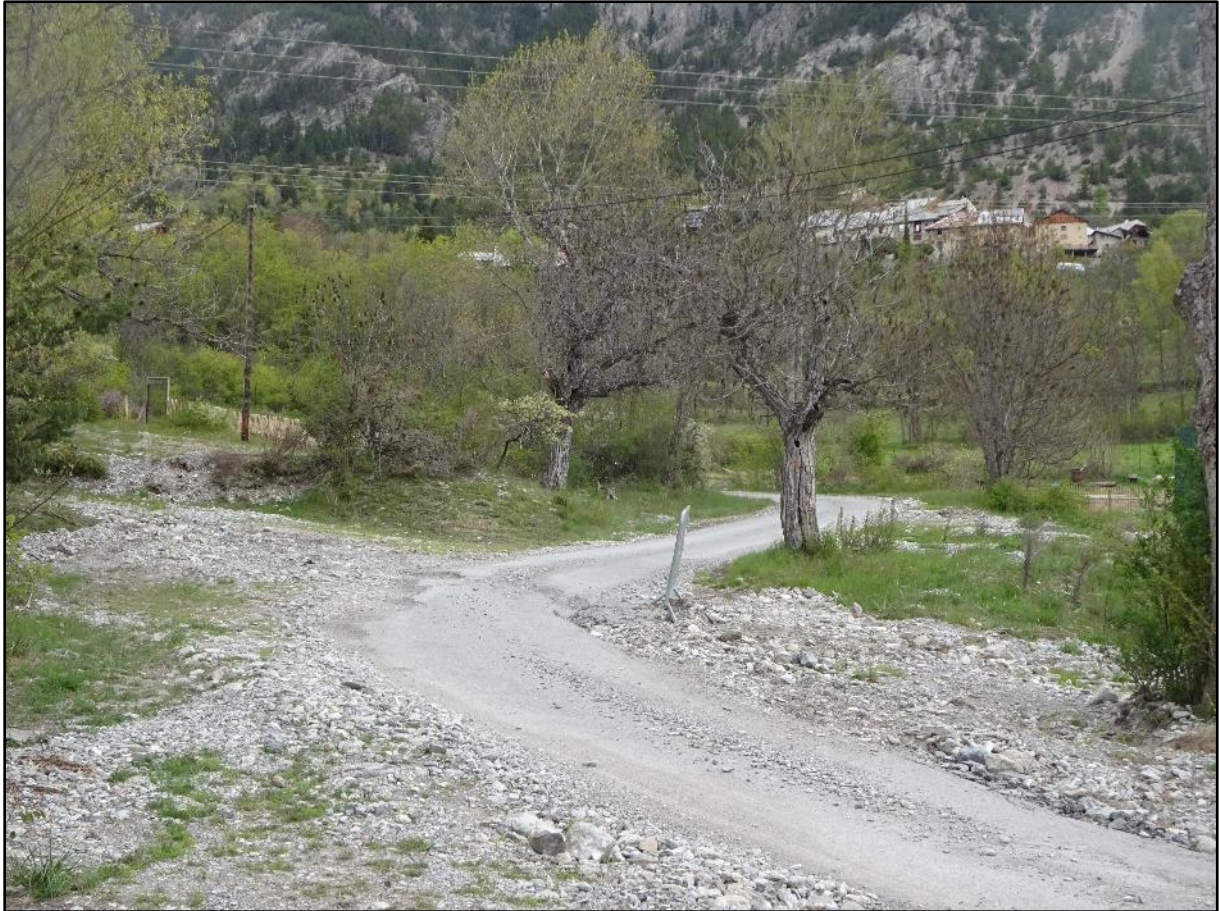
Image 16 : à la station d'épuration de la Font d'Eygliers
