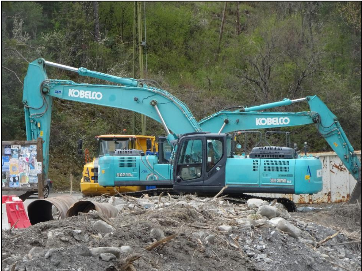
Image 22 : des pelles mécaniques
