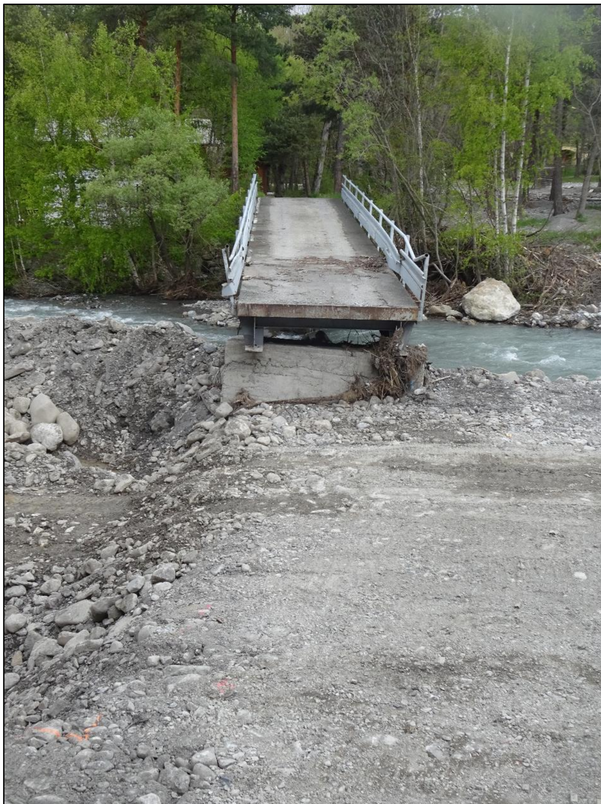
Image 29 : le pont vu de face
