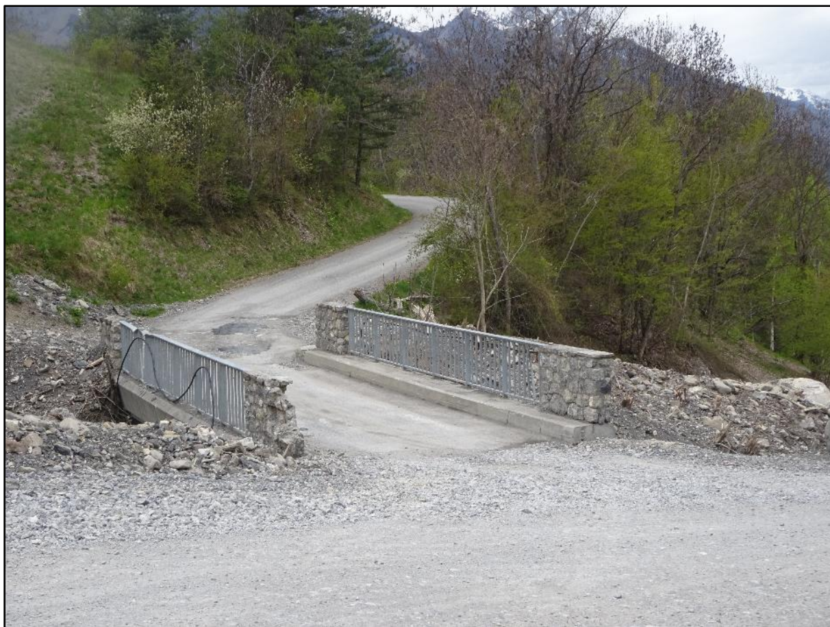
Image 18 : le dit pont
