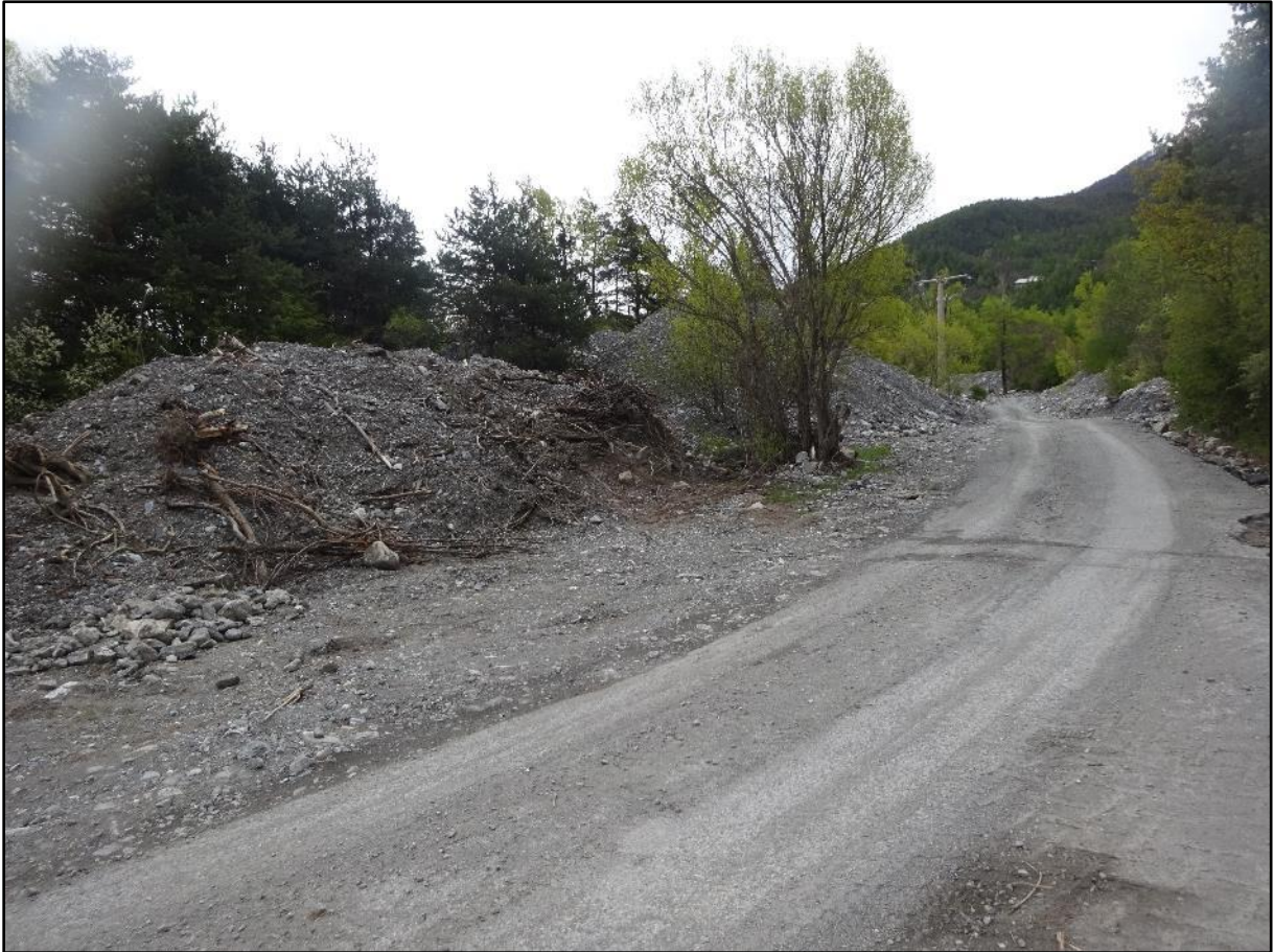
Image 4 : au-dessus du poste électrique
