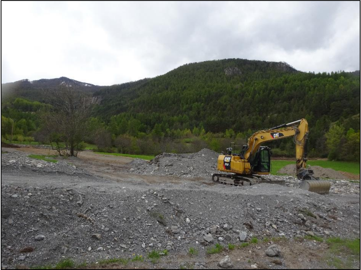
Image 8 : la pelle mécanique
