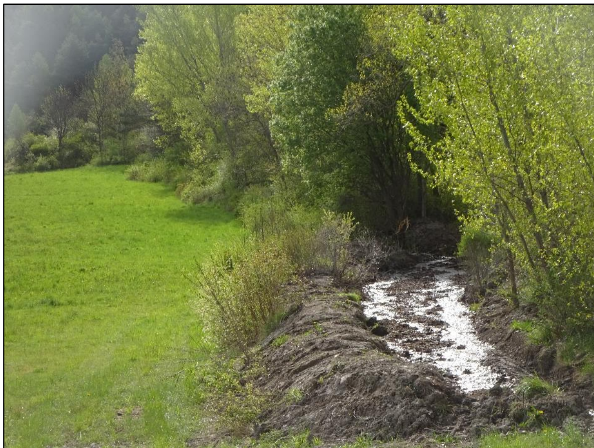
Image 16 : le torrent canalisé
