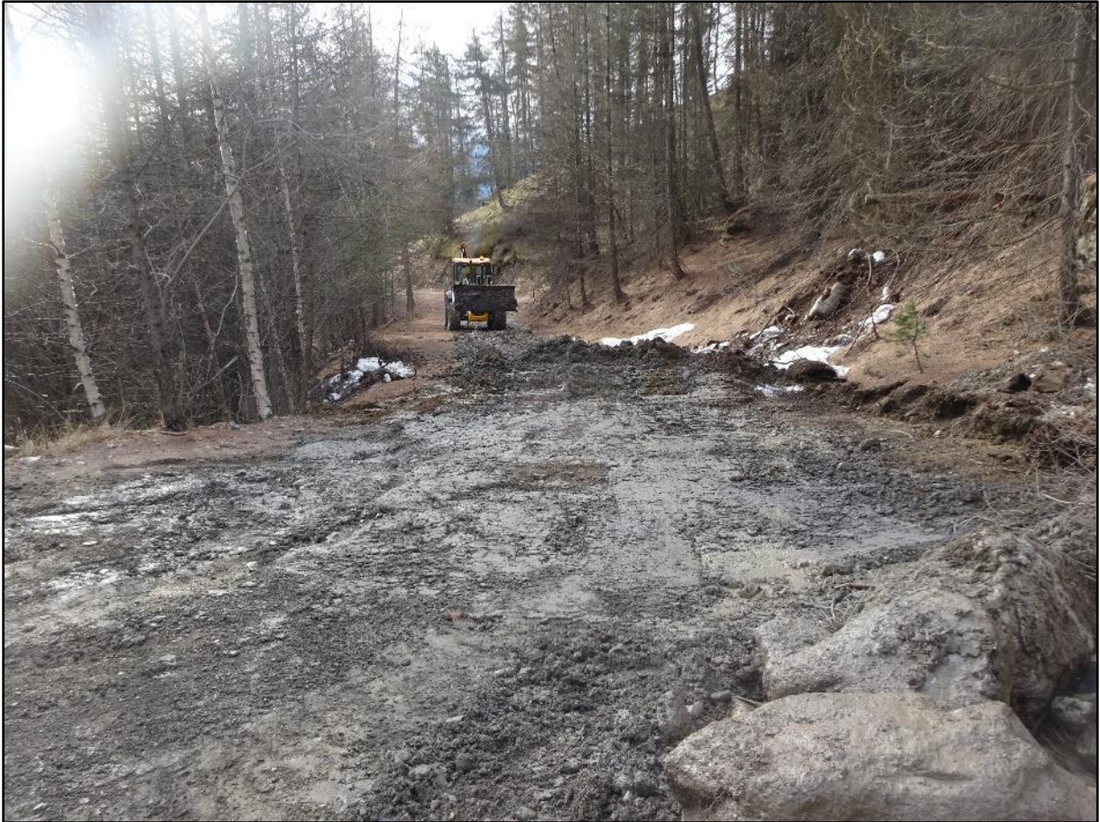
Image 20 : lissage de la chaussée
