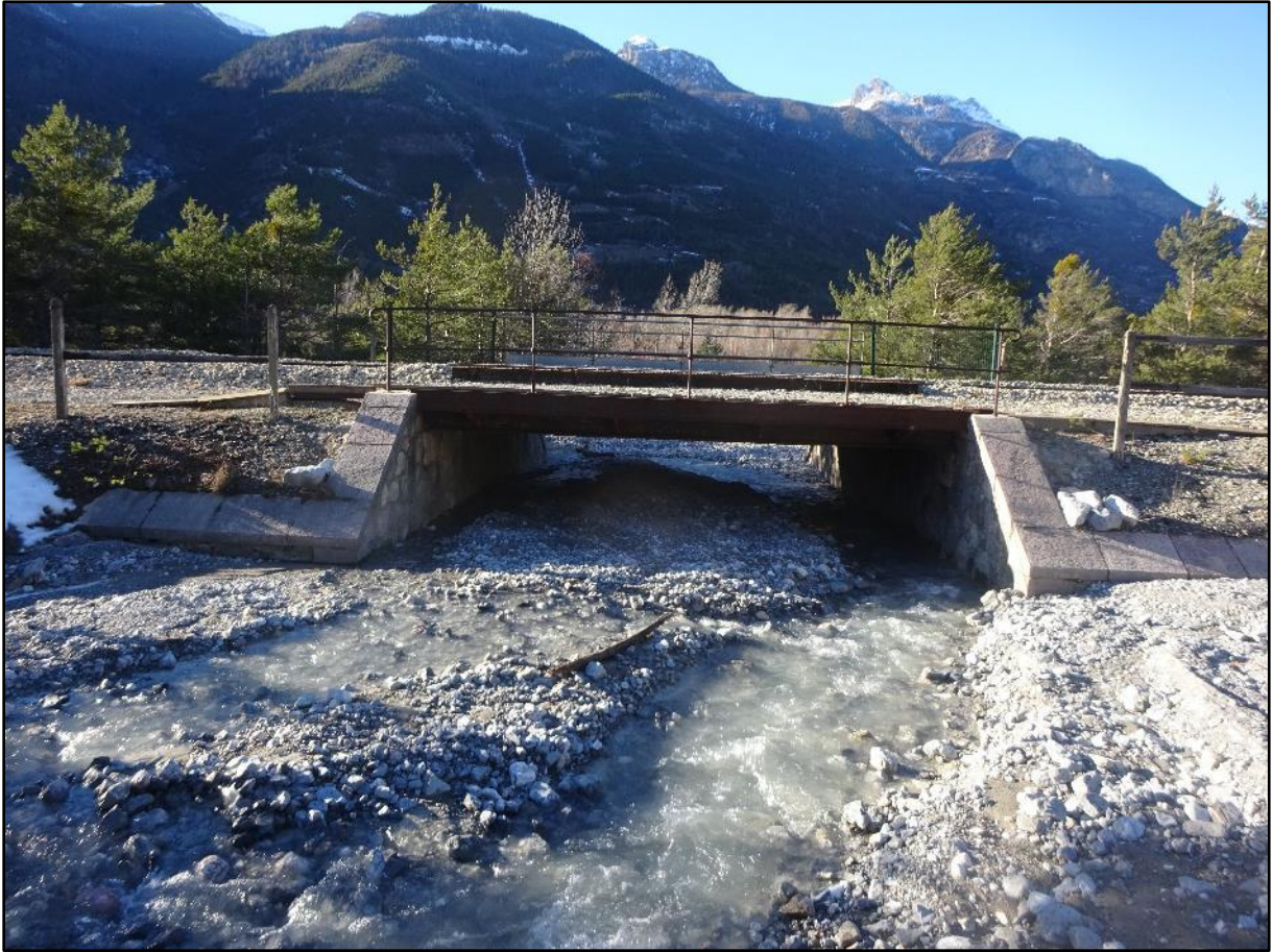
Image 9 : le même pont vu de dessus
