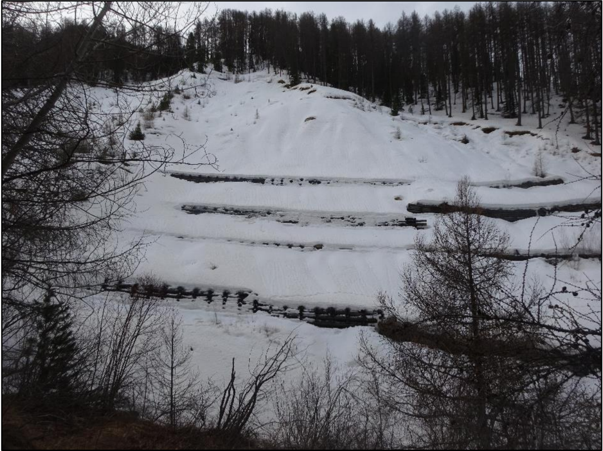
Image 5 : ouvrages de protection
