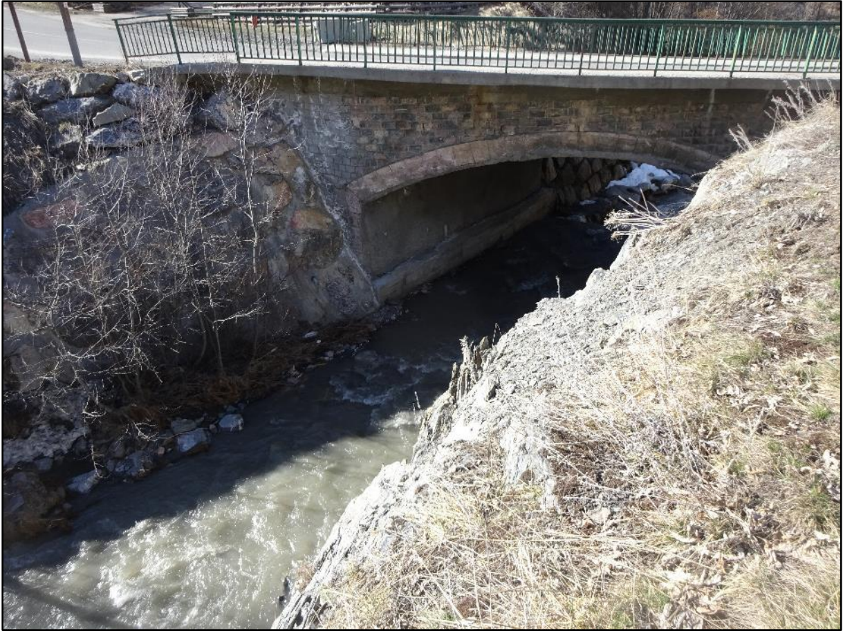
Image 24 : le pont côté amont
