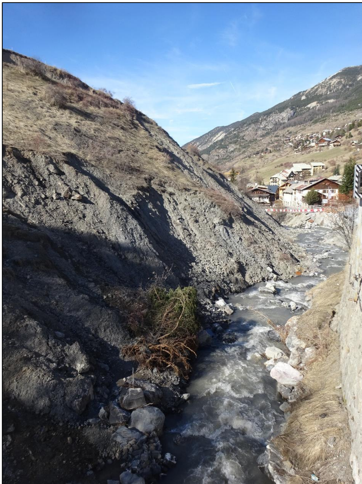
Vue vers l'aval. La terre coule sur une bonne longueur.
