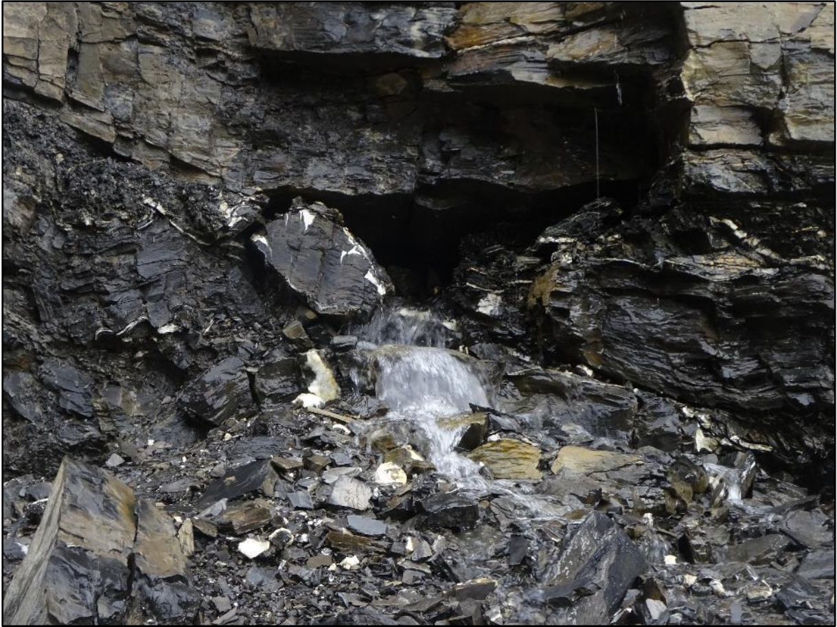
Image 26 : autre sortie d'eau d'une faille
