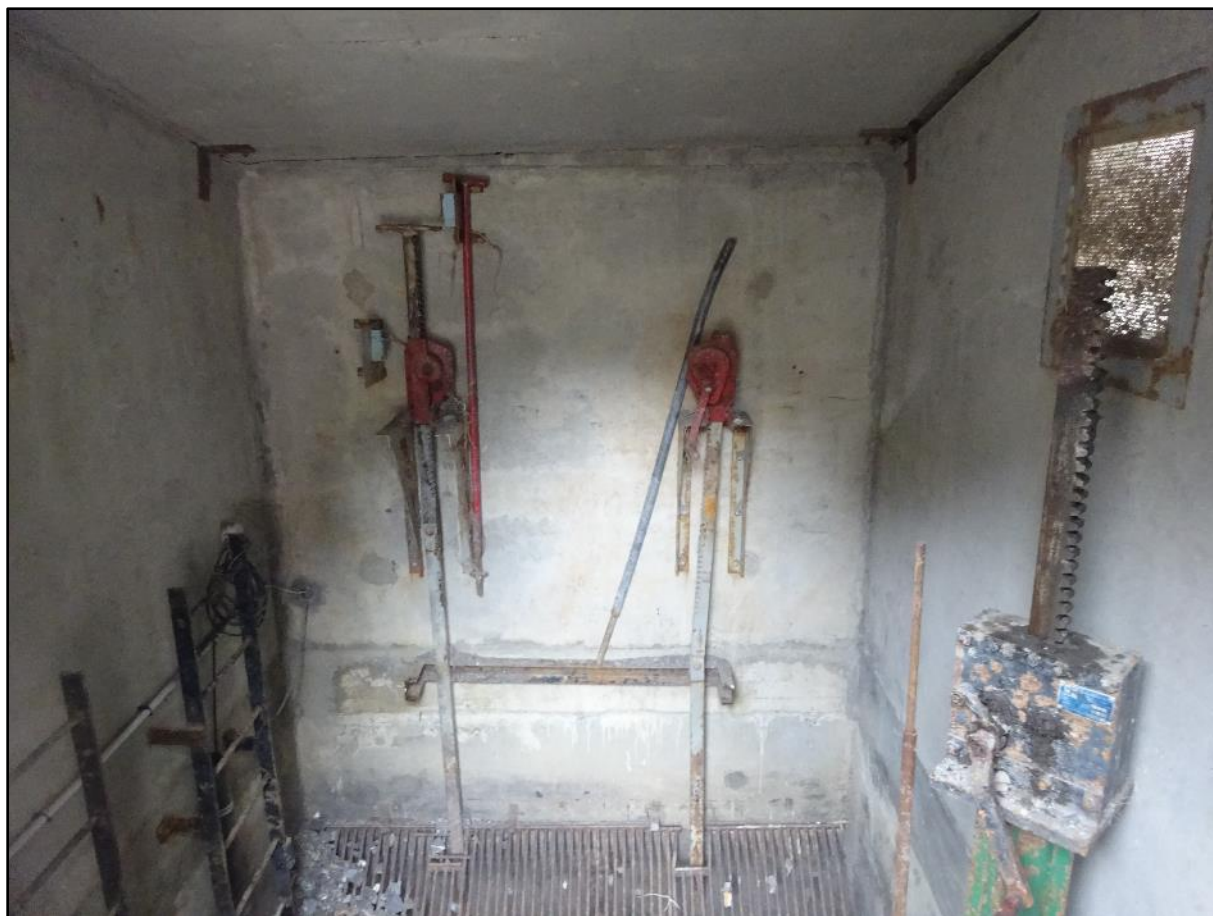
Image 3 : vue dans le bâtiment
