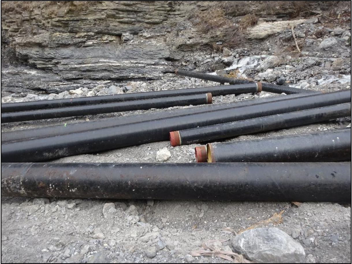
Image 24 : des tuyaux et des tuyaux
