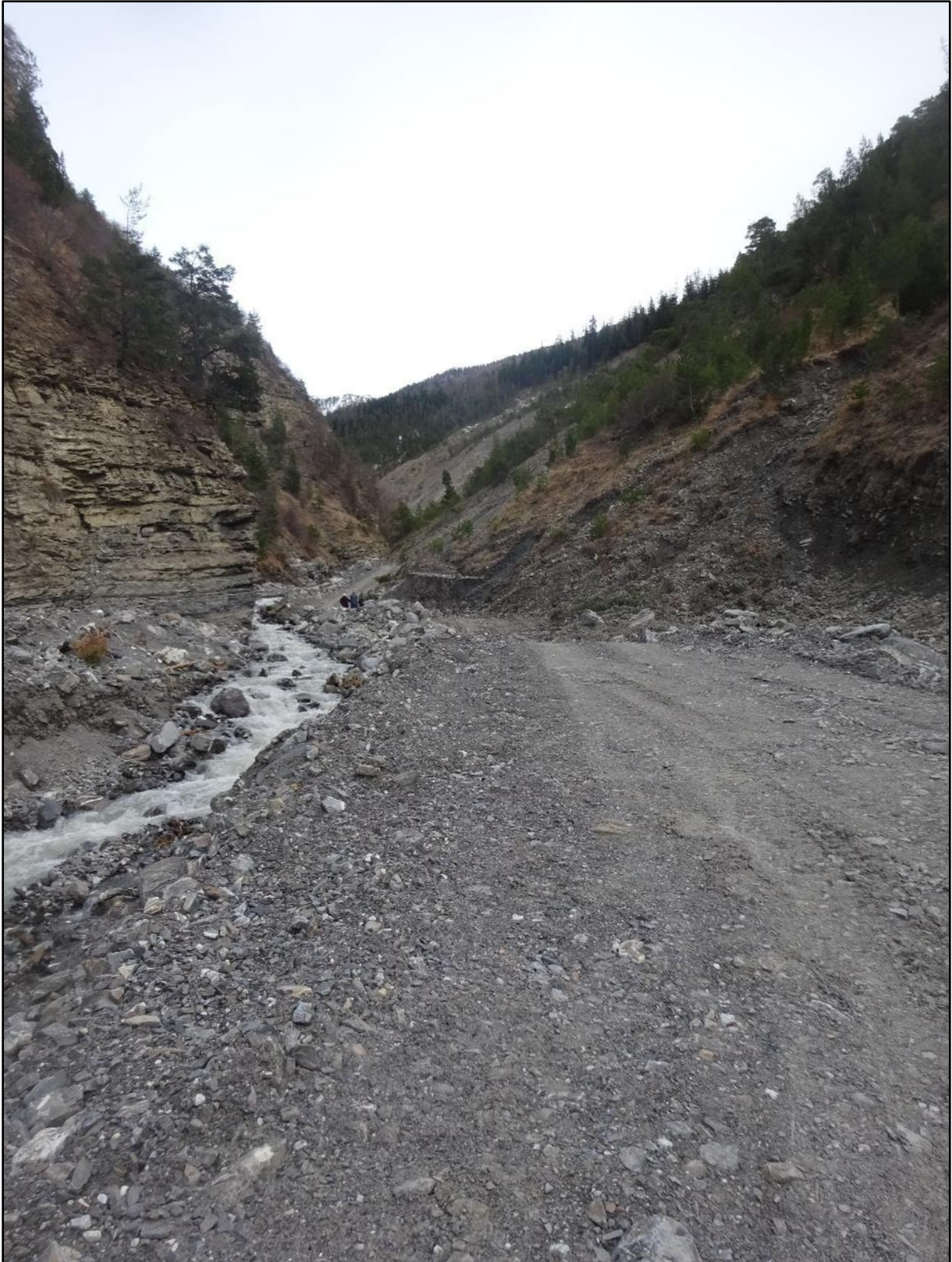
Image 19 : vue vers l'amont
