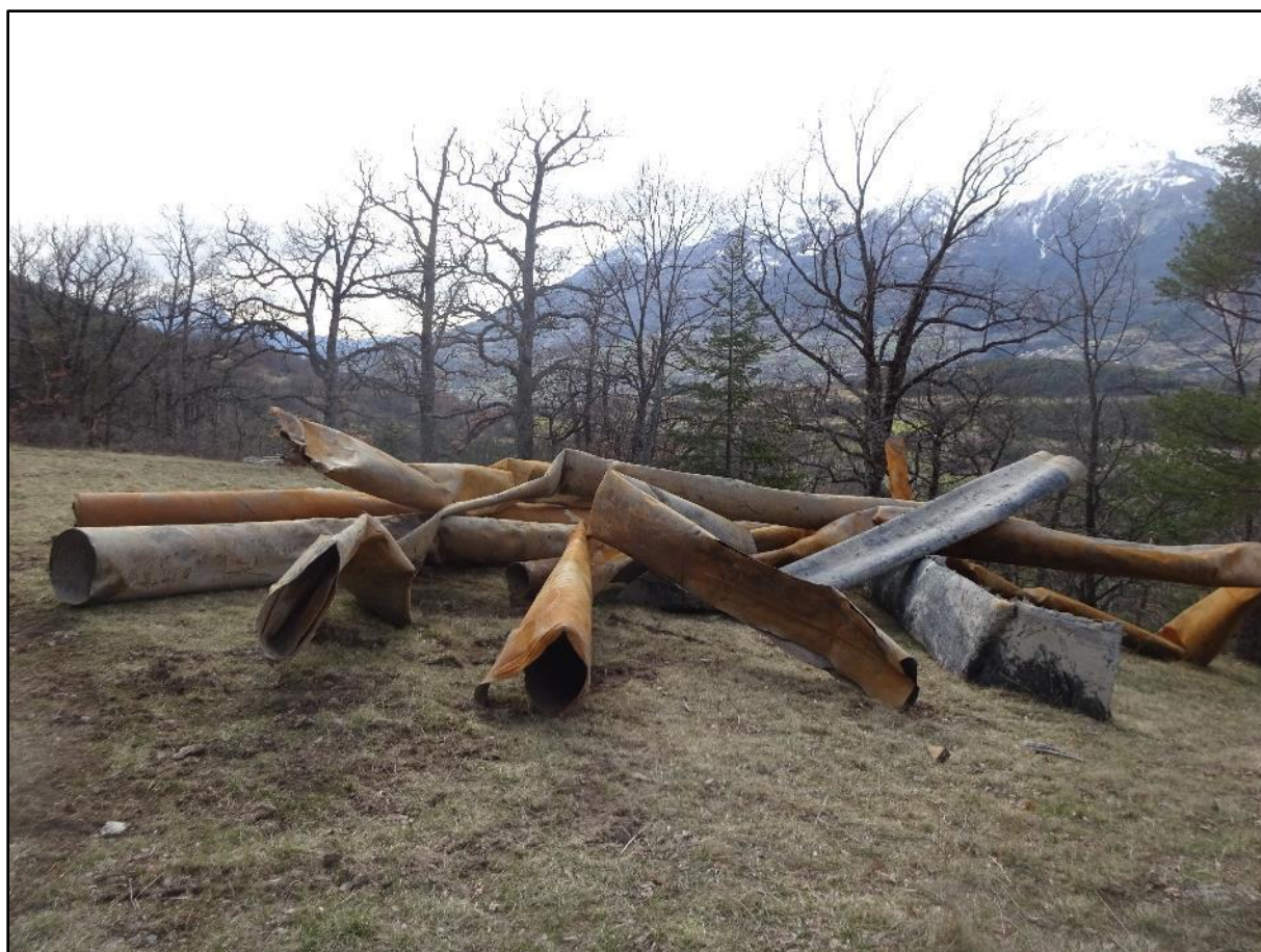
Image 1 : les anciennes conduites
