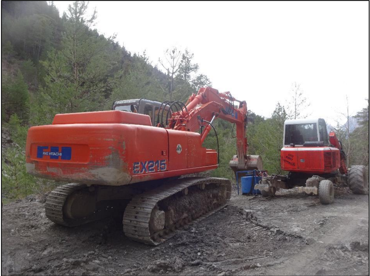
Image 13 : les deux pelles mécaniques
