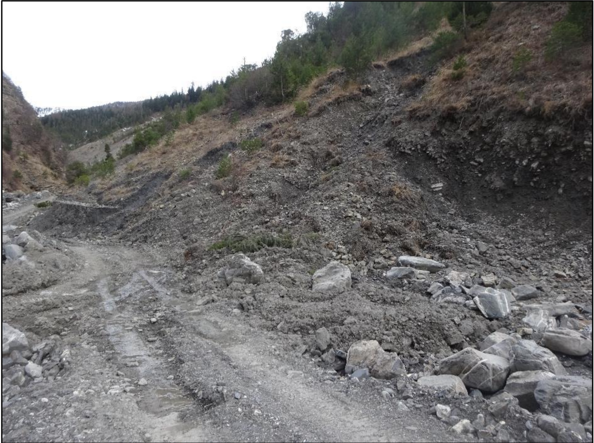
Image 20 : ça continue à s'ébouler
