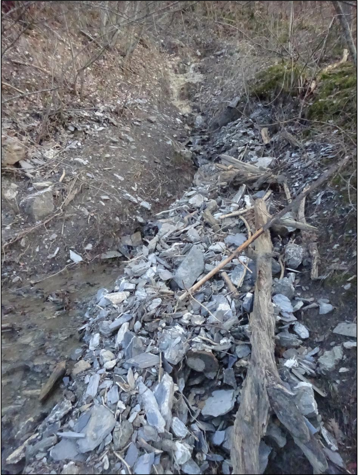
Vue vers l'amont, faible largeur.
