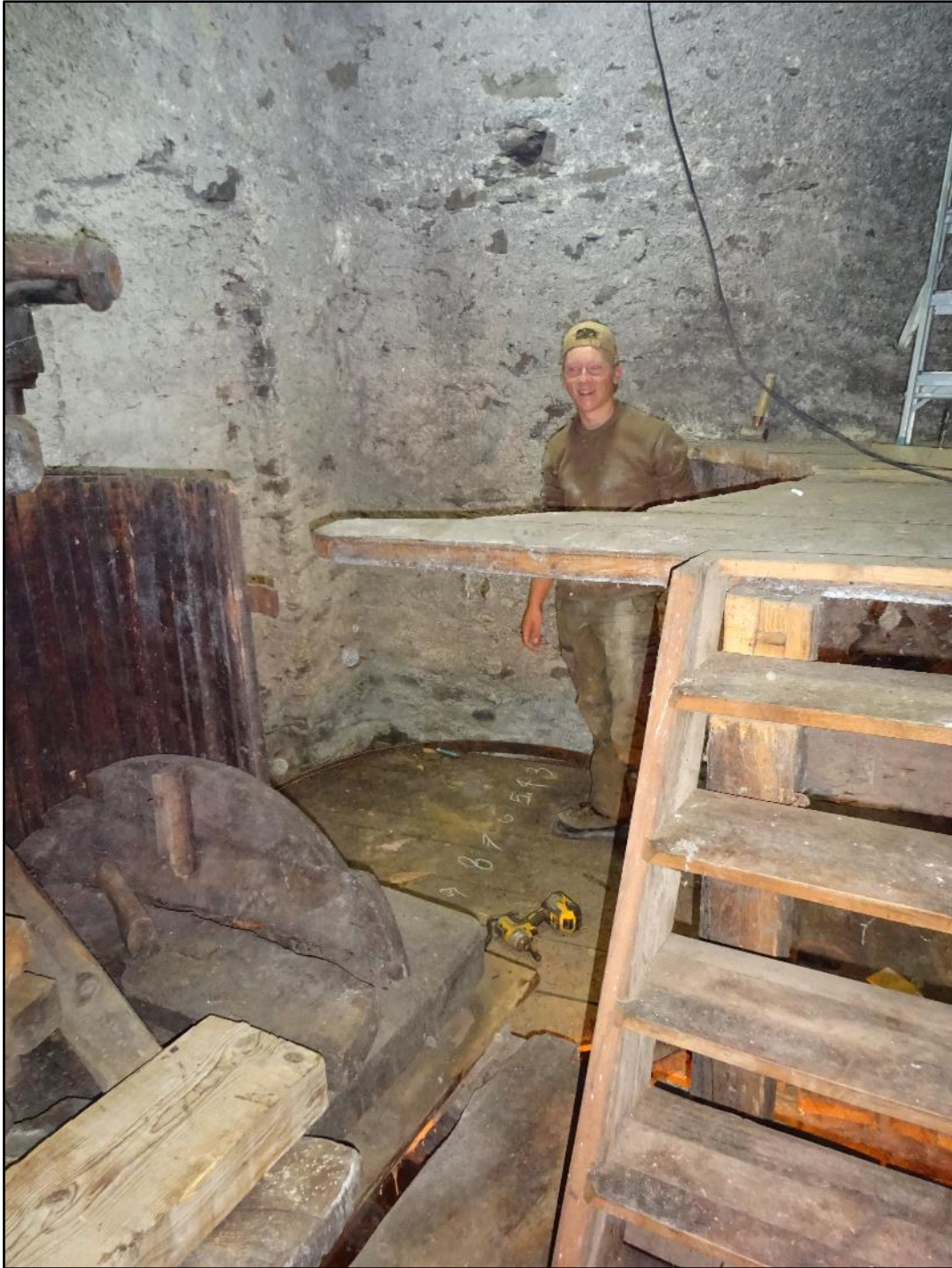
Image 101 : la tine n'a plus ses pièces verticales
